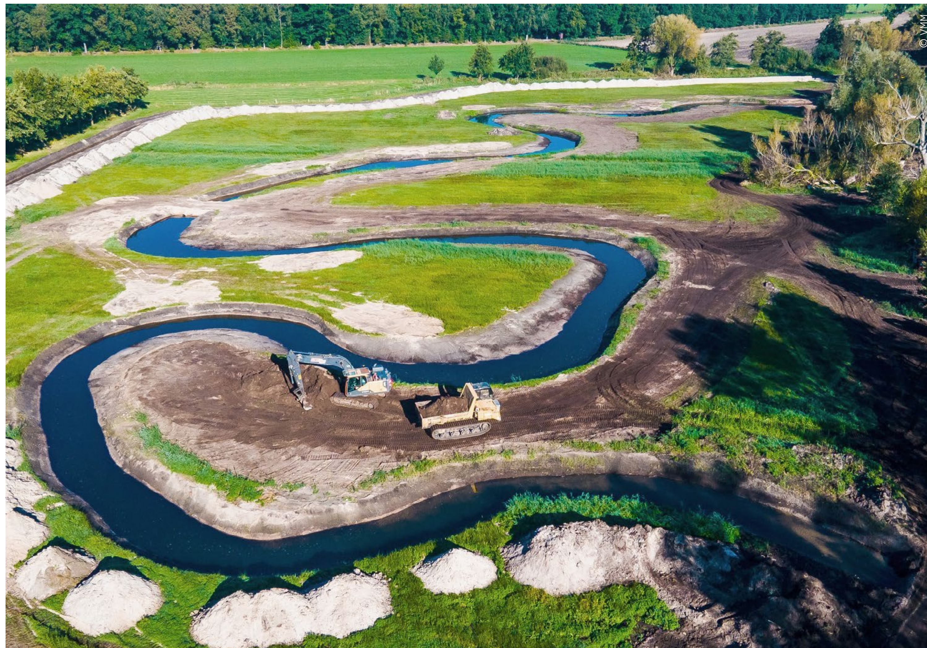
Heraanleg van de meanders in de Warmbeek
