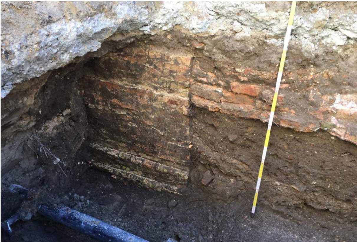
Figuur 22. Detail van de oostelijke funderingspijler (© Raakvlak).
