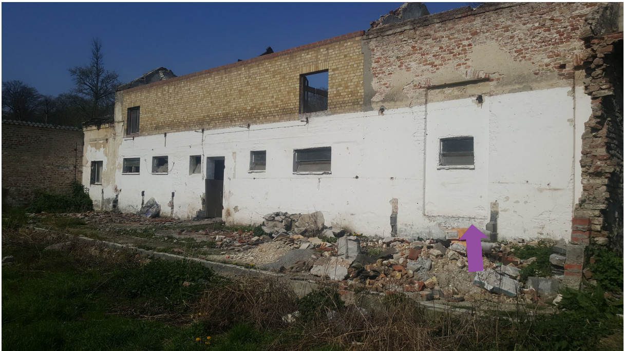
Figuur 33: Zicht naar het noorden op de zuidgevel van de stallingen tijdens de sloop in 2019. De pijl geeft de dichtgemaakte raamopening aan in muur SP76. Foto: Pieter Dewint.
