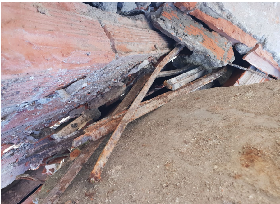
Figuur 42: Bij de sloop van de plafonds van de stallingen bleken in het puin tal van ijzeren staven aanwezig, vermoedelijk de gerecupereerde glasroeden van de serre. Foto: Pieter Dewint.
