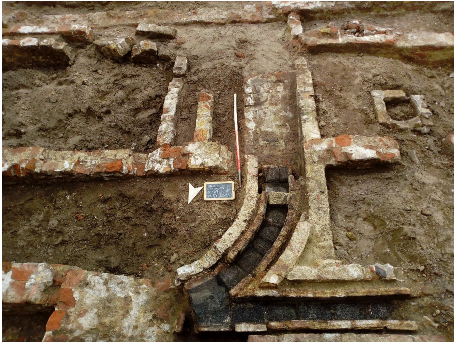
Figuur 25: De kanalen met roetaanslag. Zicht naar het zuidoosten.
