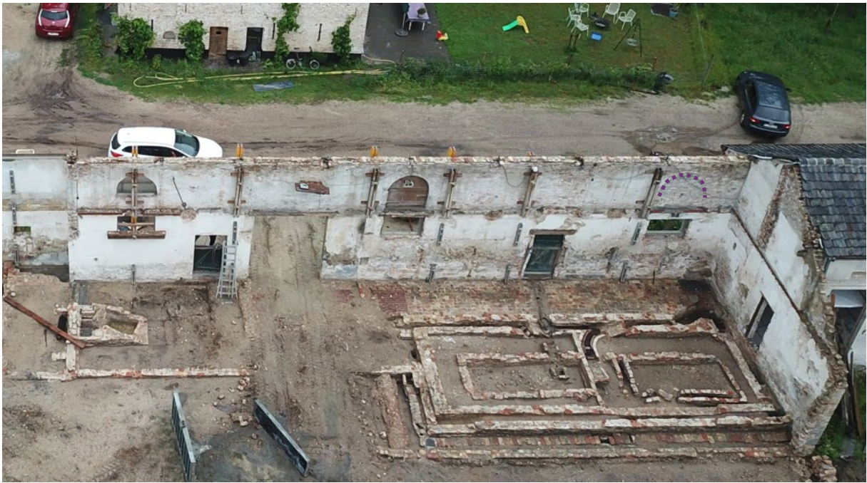
Figuur 41: Dronebeeld gericht naar het noorden, met zicht op de openingen aan de binnenzijde van de erfgevel. De twee deuren en de poort zijn duidelijk te zien, evenals de halfronde vensters. Het meest rechtse raampje was dichtgemaakt. Foto: Johan Van Laecke.
