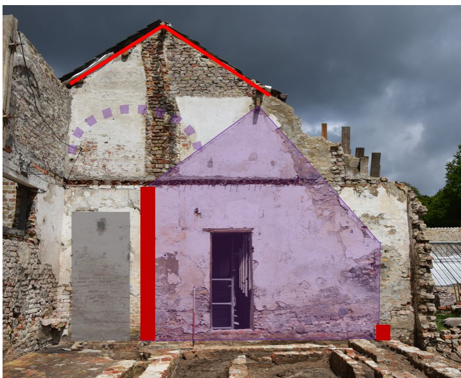
Figuur 72: Hypothetische reconstructie van de serre, waarbij de noordelijke spouwmuur hoger is en een schuin dak draagt. Hierdoor wordt een (donkere) gang gecreëerd die mogelijk bekroond was met een tongewelf. De kleine ramen in de erfgevel brachten licht in de gang.
