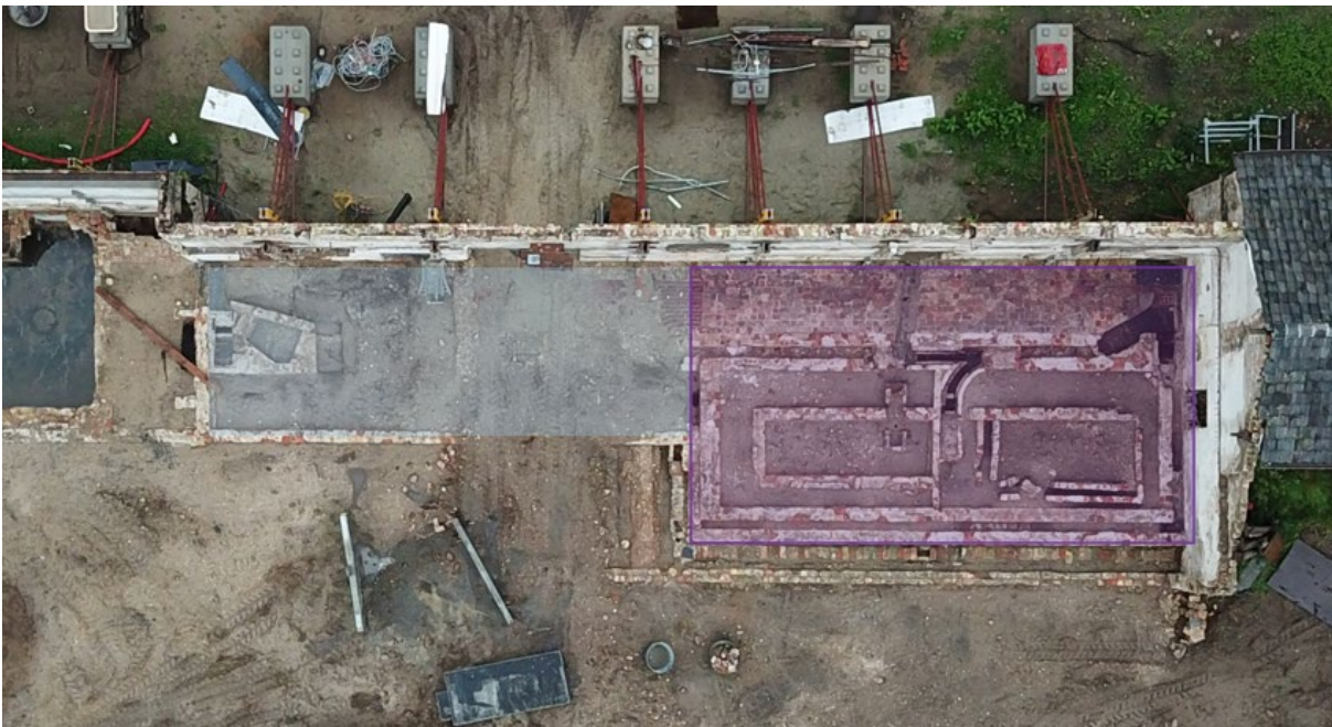
Figuur 74: In de tweede fase werd de serre (paars) verkleind en beperkt tot de oostelijke helft. In het westen werd aan de moestuinzijde een muur gebouwd (SP76) waardoor de ruimte hier (blauw) smaller werd. Deze zone kreeg een andere functie en was niet langer in gebruik als serre.
