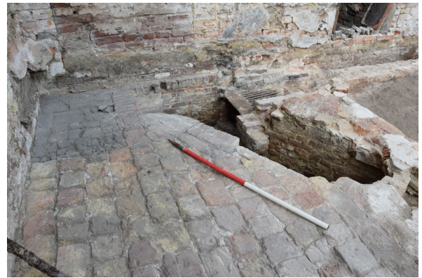
Figuur 21: De verdiepte stookplaats vanaf het gangpad. Zicht naar het oosten.
