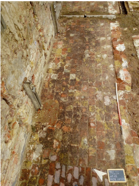
Figuur 18: Gangpad SP26 aan de noordzijde van de serre. Zicht naar het noordoosten gericht.
