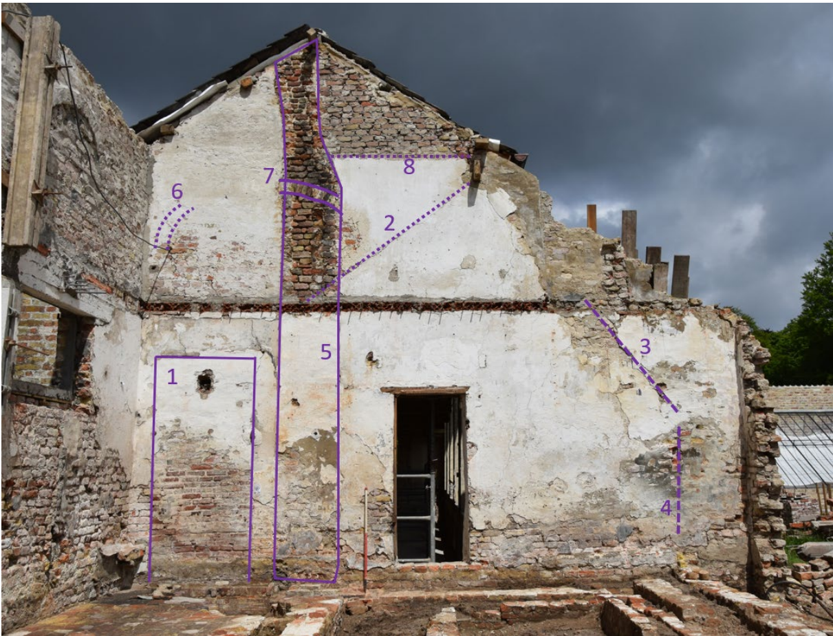
Figuur 40: De westelijke zijgevel van de orangerie, met tal van bouwsporen.
