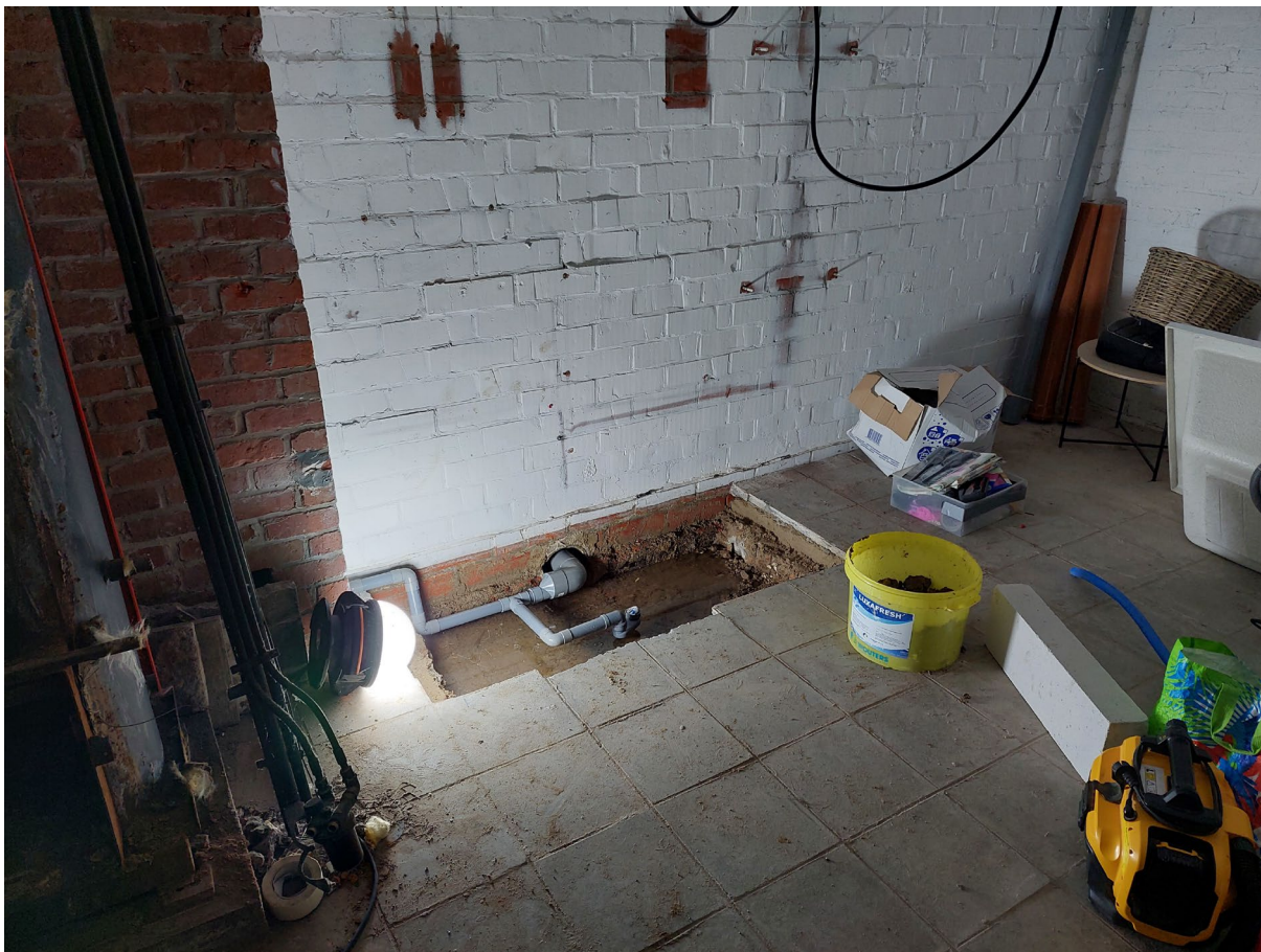
Figuur 5: Situatie op het terrein bij aanvang van het onderzoek.
