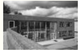
OO 1223 Project KTA Brasschaat Plaats Prins Kavellei 98, Brasschaat Programma School Bouwheer Gemeenschapsonderwijs Ontwerp Frencken Scholl architecten Bouwjaar 2012
