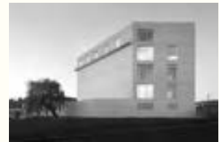
OO 1301 Project Kazerne Dossin Plaats G. De Stassartstraat 153, Mechelen Programma Museum, memoriaal en documentatiecentrum Bouwheer Vlaamse overheid, Afdeling Communicatie Ontwerp awg architecten Bouwjaar 2012
