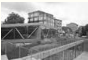
OO 1521 Project Universiteit Hasselt Plaats Martelarenlaan 42, Hasselt Programma Universiteit Bouwheer Universiteit Hasselt Ontwerp noAarchitecten Bouwjaar 2012
