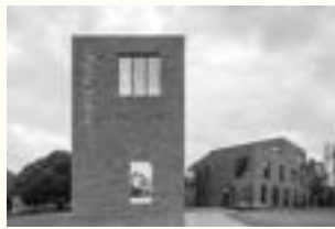
OO 1205 Project F. Sohiecentrum Hoeilaart Plaats Gemeenteplein 39, Hoeilaart Programma Gemeenschapscentrum Bouwheer Gemeentebestuur Hoeilaart Ontwerp Planners Bouwjaar 2012
