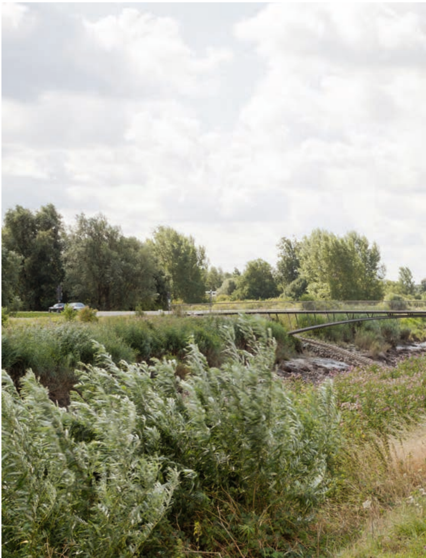
OO 1120 Fietsbruggen Zennegat, Mechelen, DFA Dietmar Feichtinger Architects, 2013
