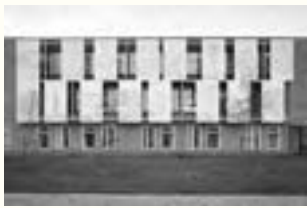
KU 0917 Opdrachtgever OCMW Nieuwpoort in samenwerking met Belfius Bouwproject Nieuwbouw woonzorgcentrum De Zathe Locatie Nieuwpoort Kunstenaars Jan Kempenaers en Kasper Andreasen Titel City Screen
