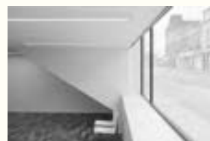
OO 1607 Project Oud Gemeentehuis Kapellen Plaats Antwerpsesteenweg 2, Kapellen Programma Multifunctio- neel gebouwencomplex Bouwheer Gemeentebestuur Kapellen Ontwerp a154 architecten Bouwjaar 2012
