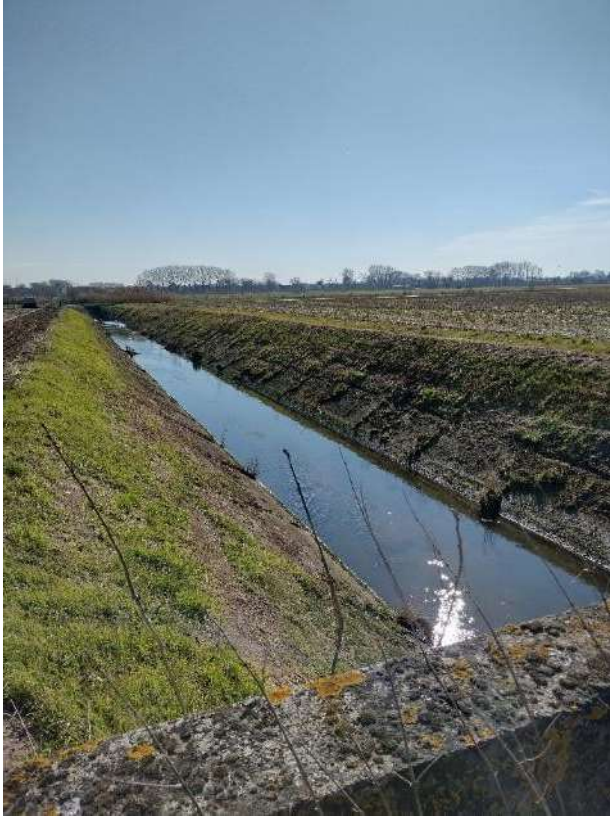
Foto 16: Gekanaliseerd deel van de Zaubeeek bij de monding in de Leie (foto VLM, 2022)
