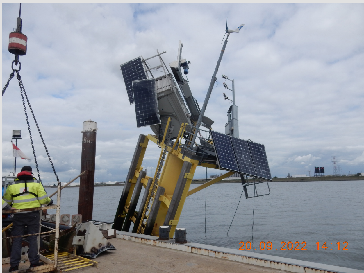
Figuur – Meetpaal Lillo dag na aanvaring door binnenvaartschip
