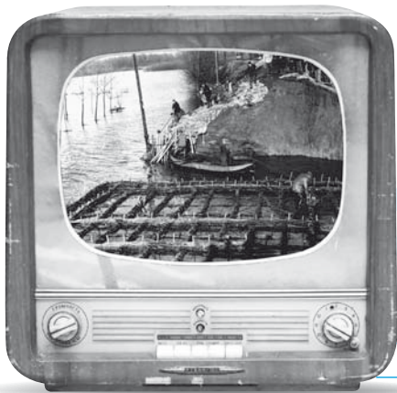
1953. Reparatie van dijken met wilgenmatten.
