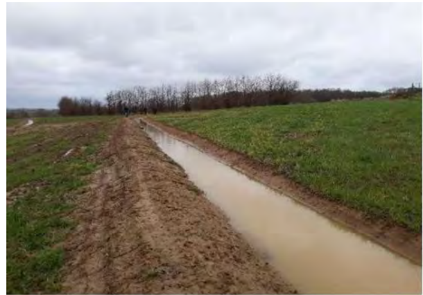
Een swale bestaat uit greppel-bermstructuur die de hoogtelijnen van het perceel volgt en wordt aangelegd om de helling te onderbreken. De greppel verzamelt water waarna het kan infiltreren, de kleine berm of aardwal met houtige aanplant ligt er onmiddellijk hellingafwaarts van. Geschikte percelen hebben een helling van minder dan 15-20%. Het aantal aan te leggen swales wordt o.a. bepaald door de hellingslengte en hellingsgraad van het perceel (Reubens et al., 2020) (foto's: Bert Reubens (ILVO)).
