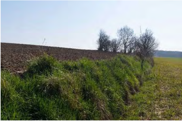
Taluds kunnen hersteld worden door de steilrand in te zaaien met grassen of te beplanten met houtige gewassen. Wanneer het talud beschadigd is door bermravijnen kan een vlechtwerk van twijgen, jutematten of planken geplaatst worden om de helling te stabiliseren.
