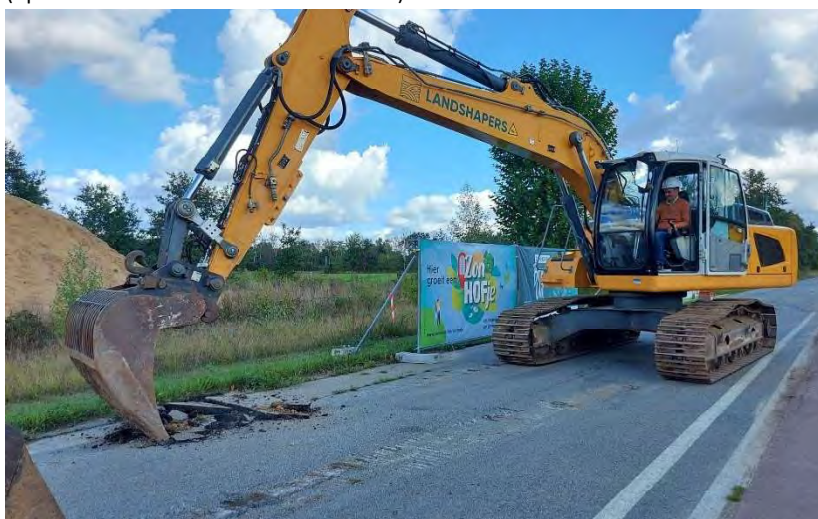
Figuur 16: voorbeeld van een onthardingsproject in het kader van landinrichting (opbreken Kauhbosstraat-Boekrakelaan)
