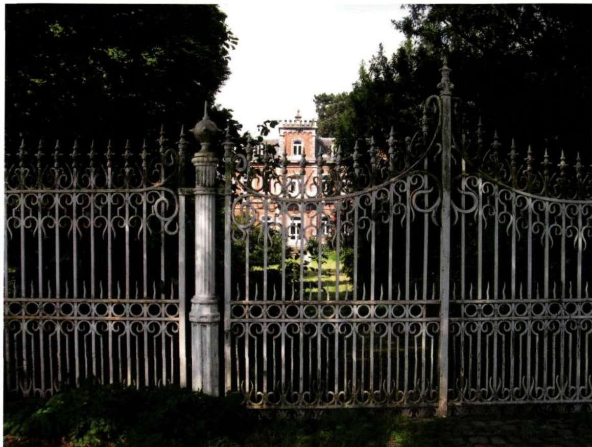
► Het toegangshek en het kasteel van Den Ast op de achtergrond (foto R. Deneef, 2004)
