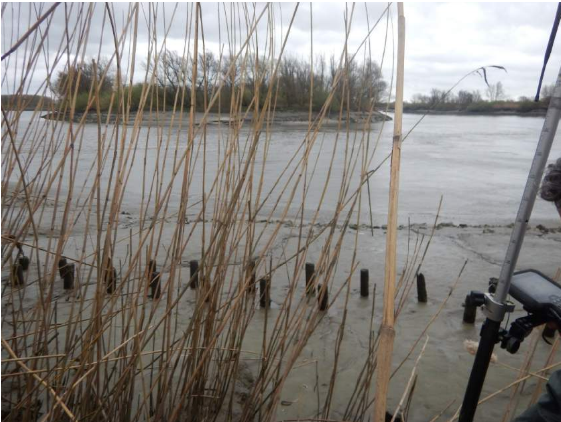
Figuur 13.32: NTMB-oever (natuurtechnische milieubouw), verstevigd met palenrijen aan de Kramp.
