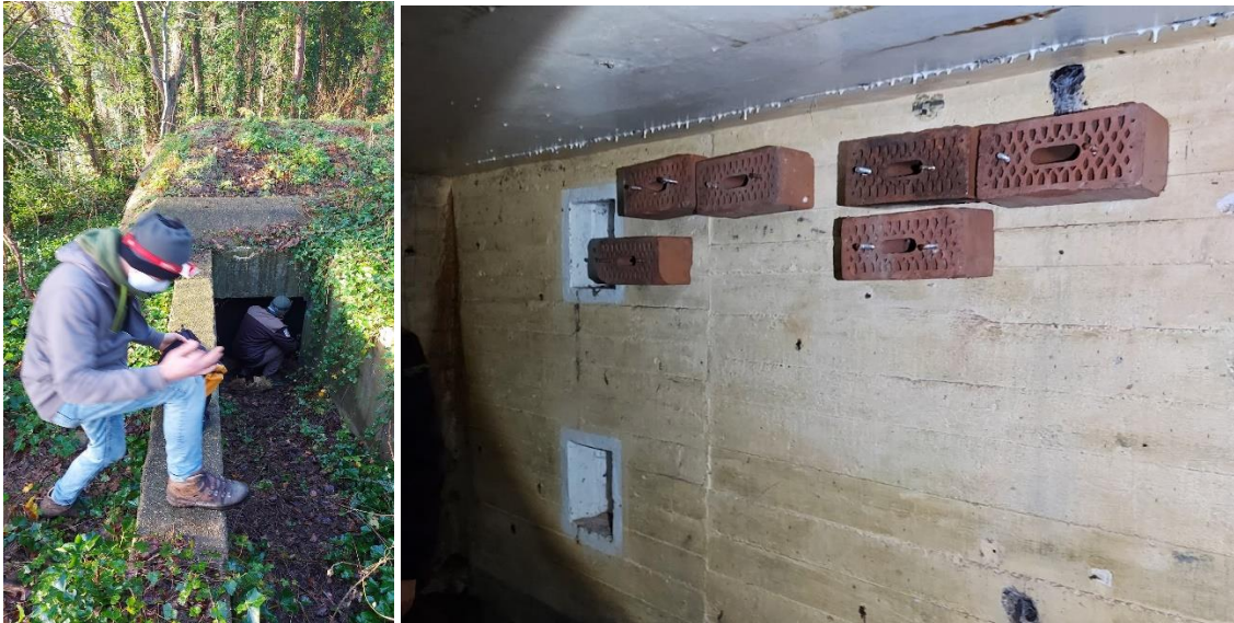
Figuur 10.8. Links: Inspectie van de bunker KK_13 van buiten. Rechts: ingerichte binnenkant met aangebrachte snelbouwstenen.
