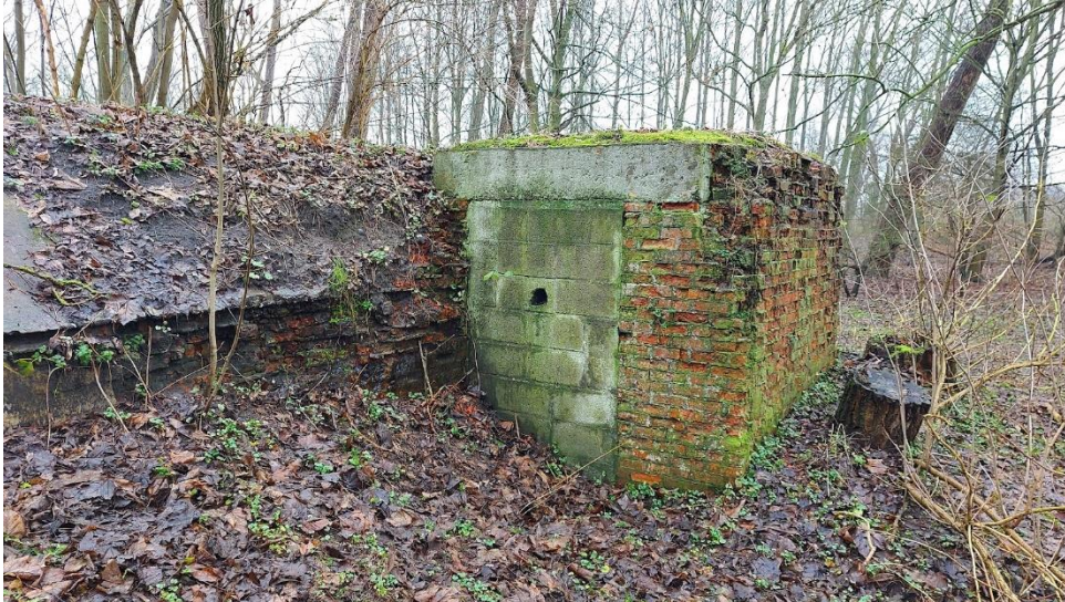
Figuur 10.2. Bunker AK_04 in Cabour.
