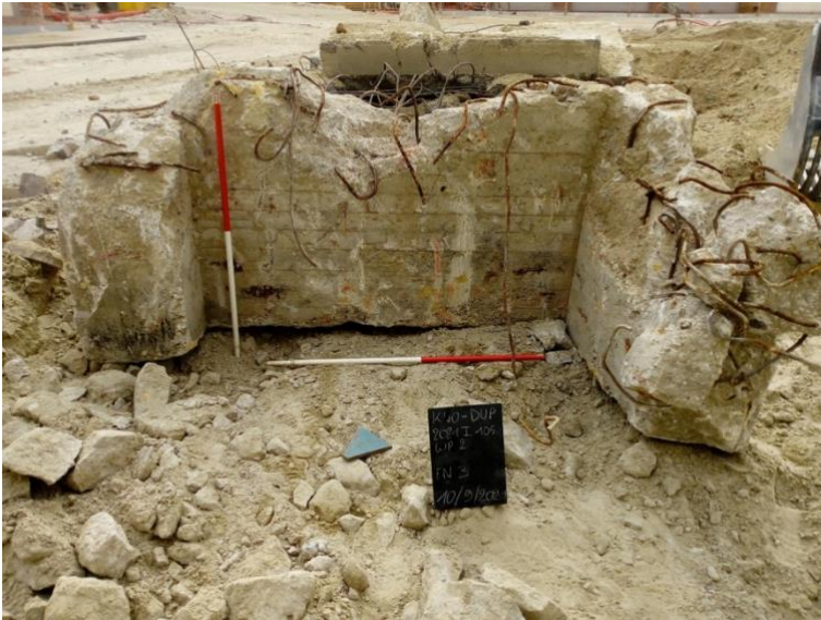
Figuur 38: De kleine betonnen constructie, die zich niet meer in situ bevond. Foto: Adede.
