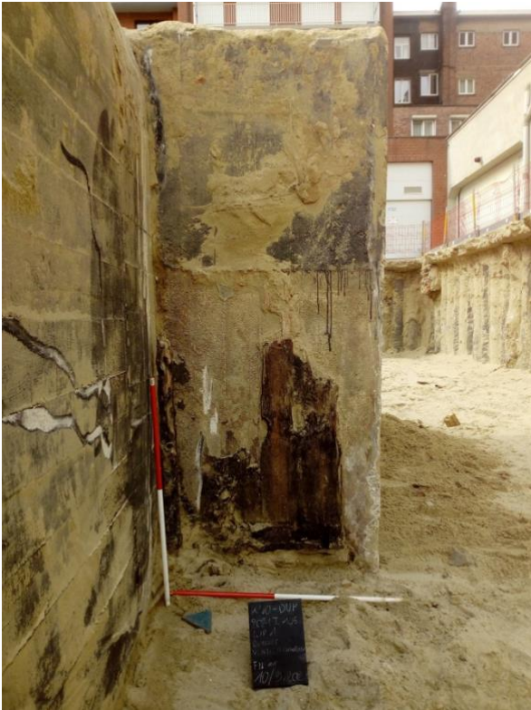
Figuur 44: Restanten van de houten bekisting in fijnspar. Foto: Adede.
