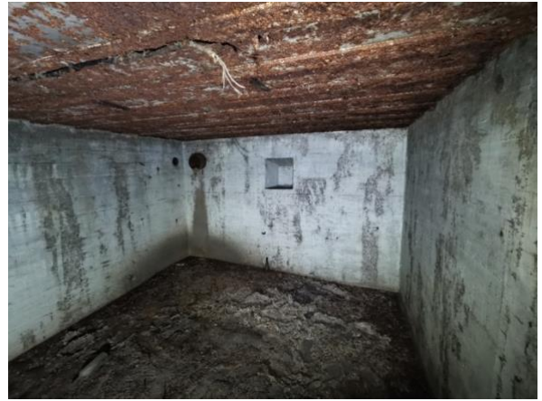
Figuur 26: Binnenzicht van kamer 2, met achteraan een blinde nis en een buis met grote diameter (5). In de westelijke zijwand, ter hoogte van buis 5 is een verbinding (10) met de aanpalende kamer. Aan het plafond hangt nog een elektriciteitskabel. Foto: Simon Vosters.
