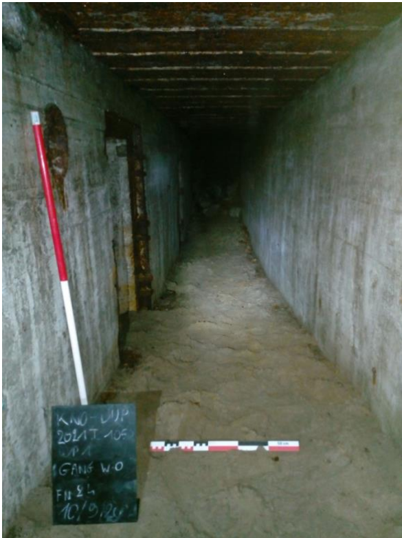
Figuur 17: Binnenzicht van de gang, vanuit de westelijke toegang. Foto: Adede.
