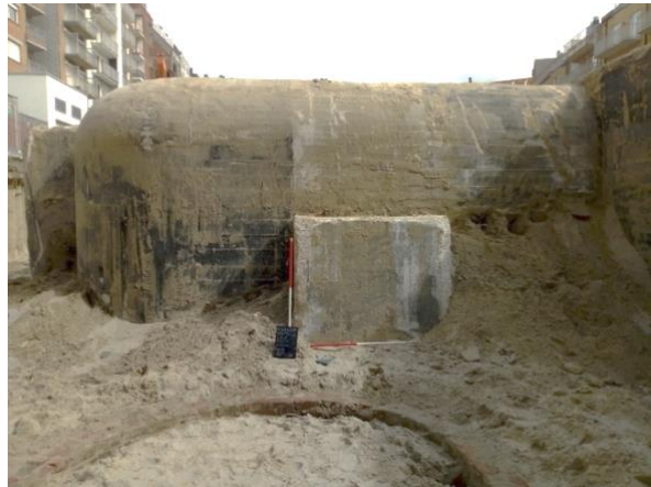
Figuur 21: Zicht op de kleinste betonnen aanbouw (granaatvanger 1) aan de zuidwestelijke zijde. De aanbouw aan de noordwestelijke zijde (voorzijde) van de bunker is beduidend hoger. Foto: Adede.
