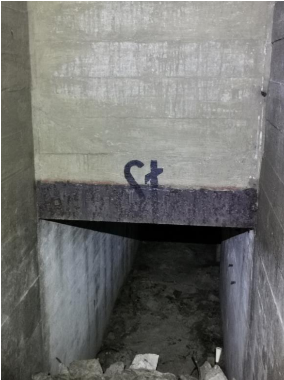
Figuur 34: Opschrift met de vermelding 'St' bovenaan de westelijke toegang, wat staat voor ' Ständiger Ausbau ', of bommenvrije schuilplaats. Foto: Simon Vosters.
