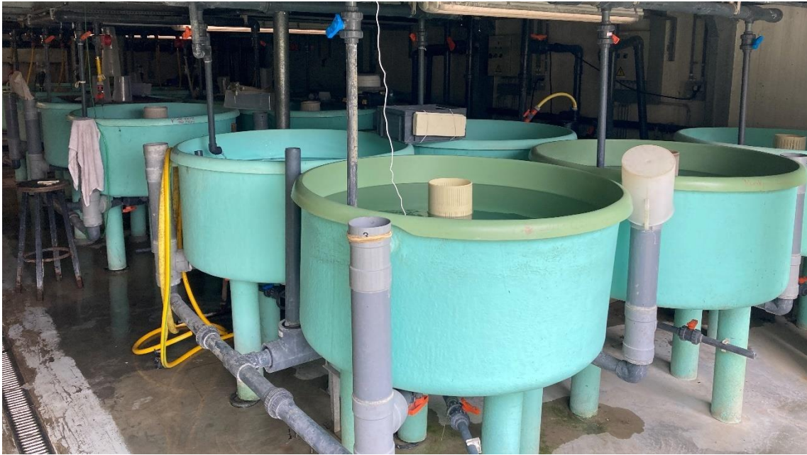
Figuur 3: Het aquacultuursysteem in de broedhal van het Onderzoekscentrum voor Aquatische Fauna bestaat uit verschillende brongevulde eenheden die via een mechanische en biologische filter gescheiden functioneren.
