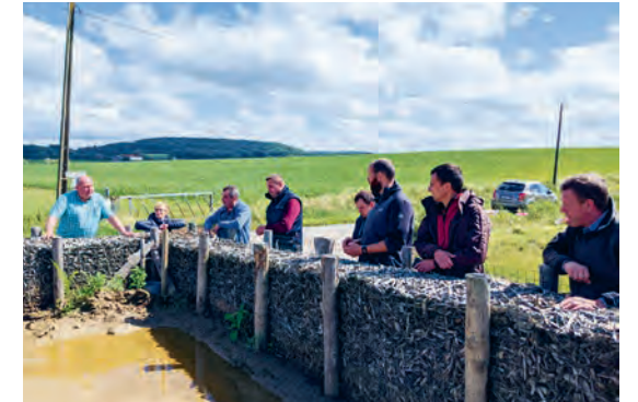
Landbouwers in de Westhoek wisselen ervaringen uit over maatregelen voor een betere waterkwaliteit en minder erosie, zoals het aanleggen van houthakseldammen. © Regionaal Landschap Westhoek
