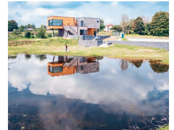
Het bufferbekken op het bedrijventerrein Keiberg-Vosseem vangt het regenwater collectief op. Na zuivering wordt het hergebruikt door de omliggende bedrijven. © Bob Van Mol
