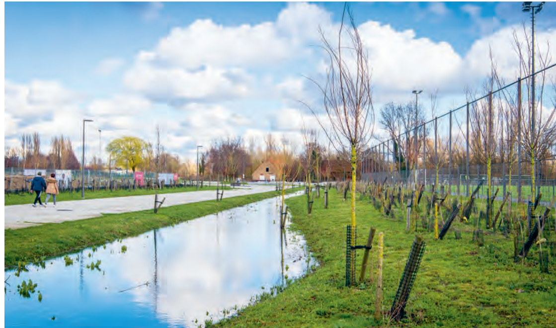
Op pleinen en plantvakken, zoals hier op Ringpark het Schijn, legt de stad infiltratiezones aan om zoveel mogelijk regenwater te bufferen. © Stad Antwerpen, Frederik Beyens
