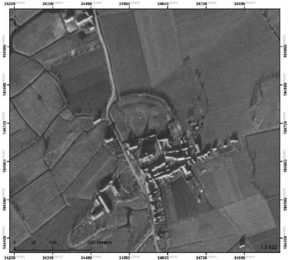
Figuur 109 Luchtfoto 1944 (bron: NARA)
