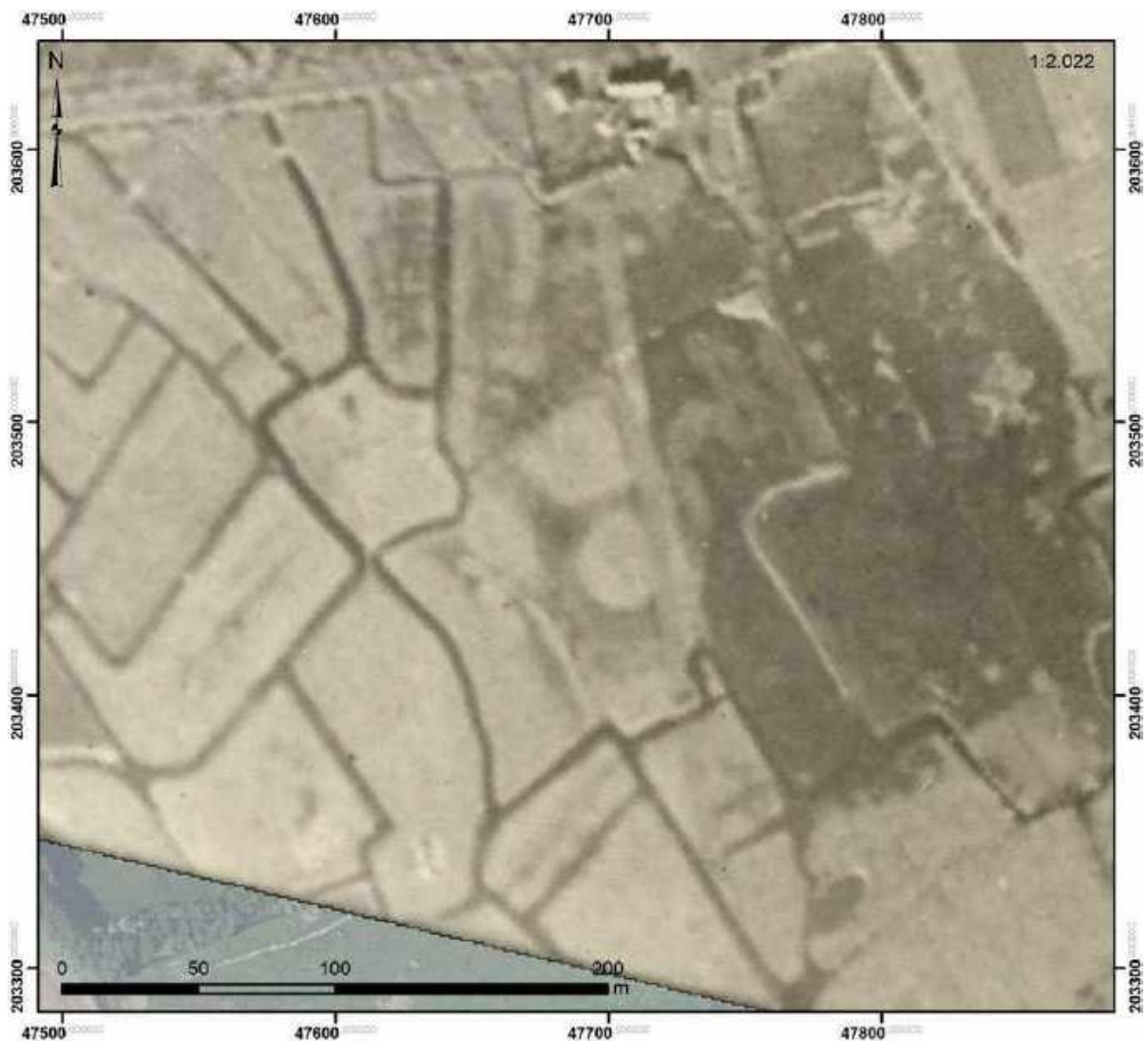
Figuur 185 Luchtfoto 22 oktober 1917 (bron: KLM)
