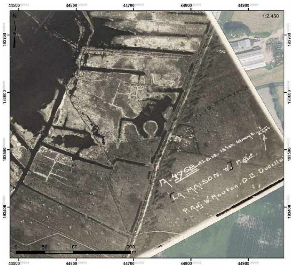
Figuur 85 Luchtfoto 21 augustus 1918 (bron: KLM)
