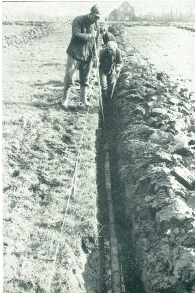
Het leggen van buizen (Ameryckx 1960)
