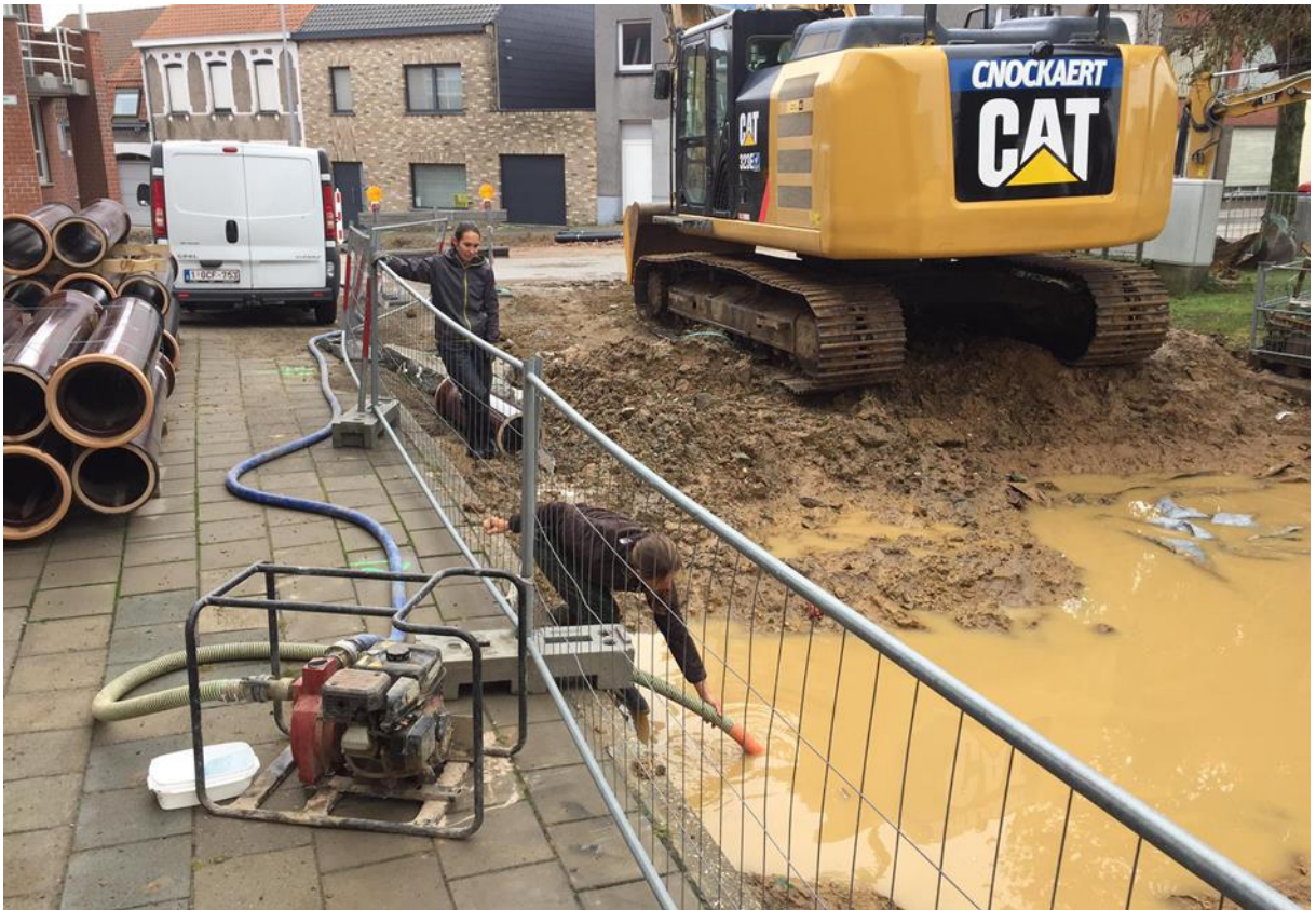
Figuur 11: Wegpompen van het water uit de oostelijke opvangput. Foto genomen op 29 september 2020 (© agentschap Onroerend Erfgoed).
