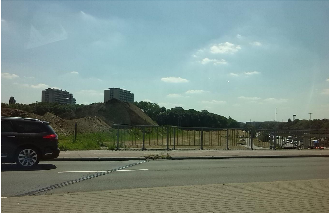
Foto 6-6 Afscherming van meetpunt 4 van het wegverkeerslawaai van de R1 door zandhopen (foto genomen op 3 juli 2014)
