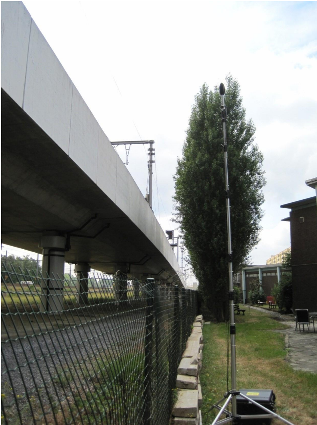
Foto 6-4 Meetpunt 3 in Luchtbal (Columbiastraat 8)
