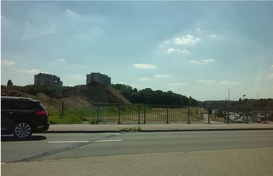
Foto 6-6 Afscherming van meetpunt 4 van het wegverkeerslawaai van de R1 door zandhopen (foto genomen op 3 juli 2014)
