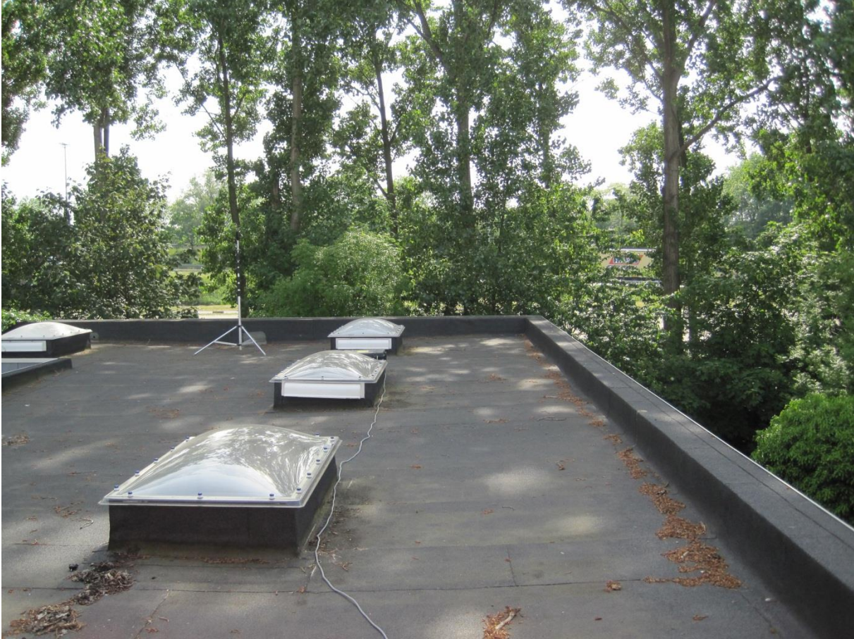
Foto 2 Meetpunt 1 op het dak van het buurthuis. Aan de zijkant van de achterkant van het buurthuis (kant van de R1) bevinden zich geen aansluitende gebouwen.
