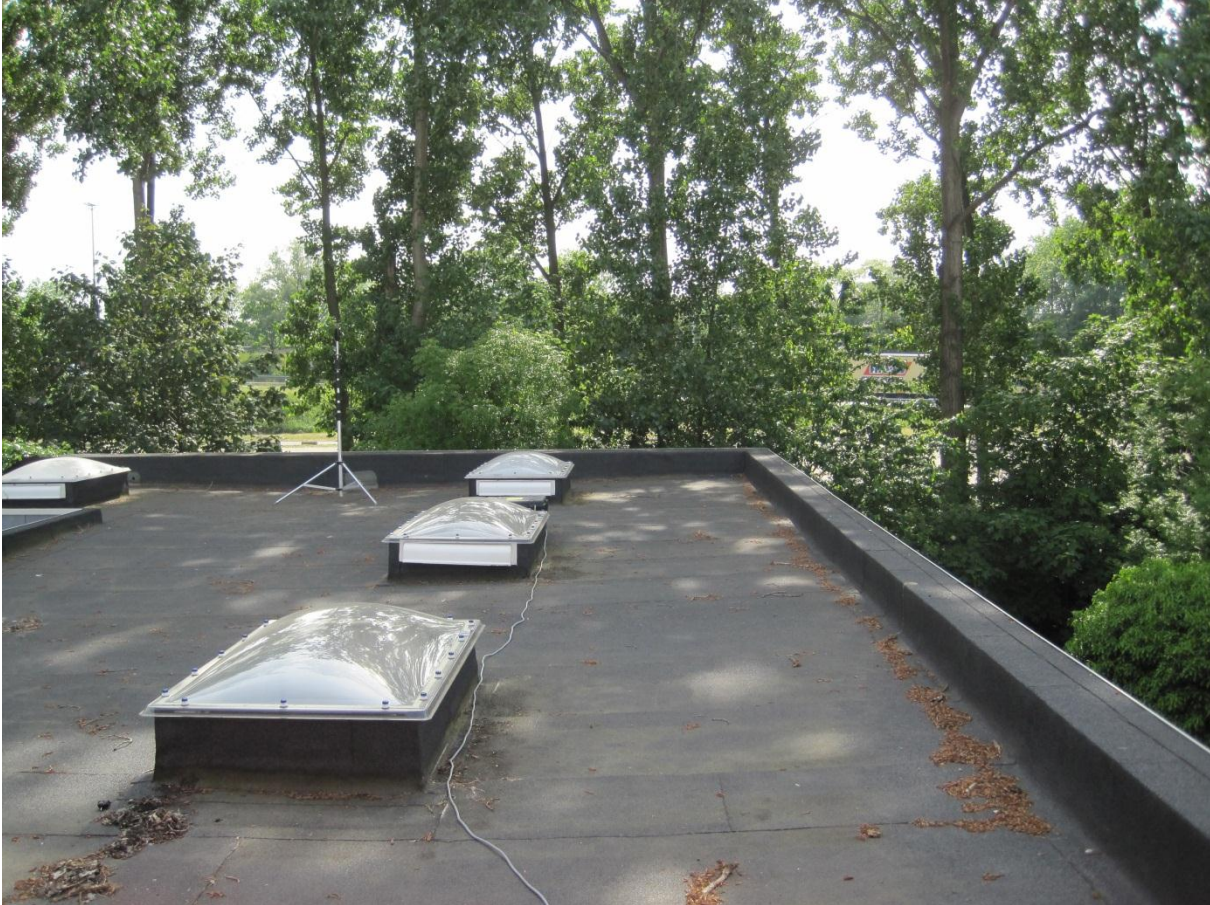
Foto 2 Meetpunt 1 op het dak van het buurthuis. Aan de zijkant van de achterkant van het buurthuis (kant van de R1) bevinden zich geen aansluitende gebouwen.
