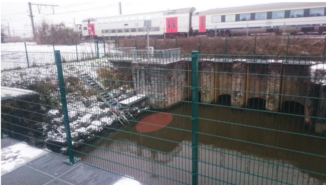
Figuur 13 Zicht op het begin van de ondergrondse koker vanop de duiker net stroomafwaarts het terugslagkleppencomplex van het Caemerlinckxgeleed. De artificiële substraten werden tussen de trap en de bakstenen oever geplaatst (rode cirkel).
