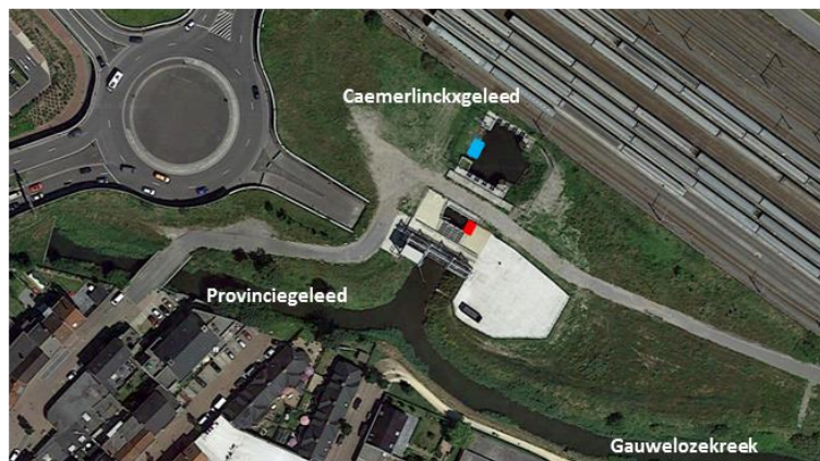
Figuur 9 Studiegebied; detail van het niet ingebuisde gedeelte van het Caemerlinckxgeleed ter hoogte van het terugslagkleppencomplex met de locatie van de palinggoot (rood) en de flottangs (blauw).
