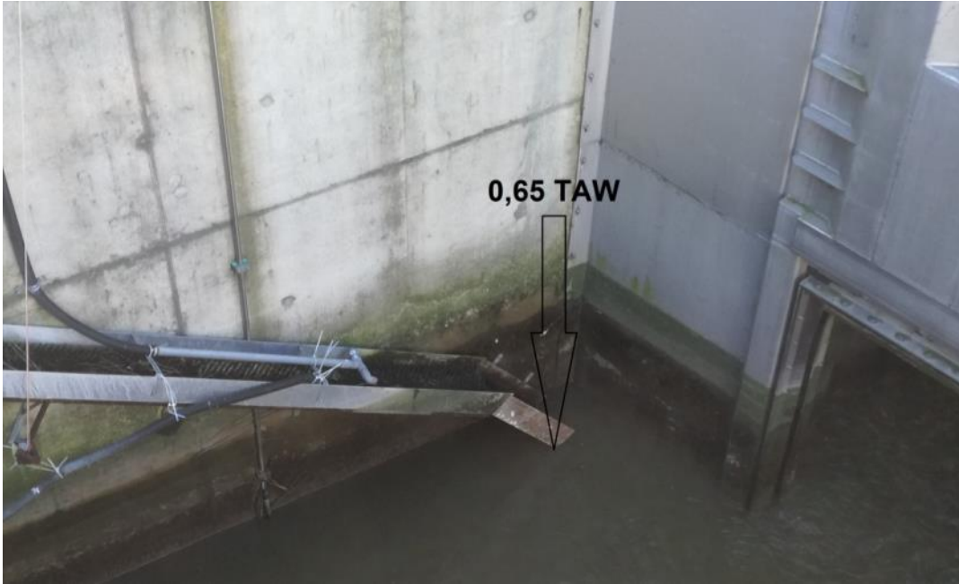
Figuur 12 De glasaalgoot werd begin 2020 verlengd.
