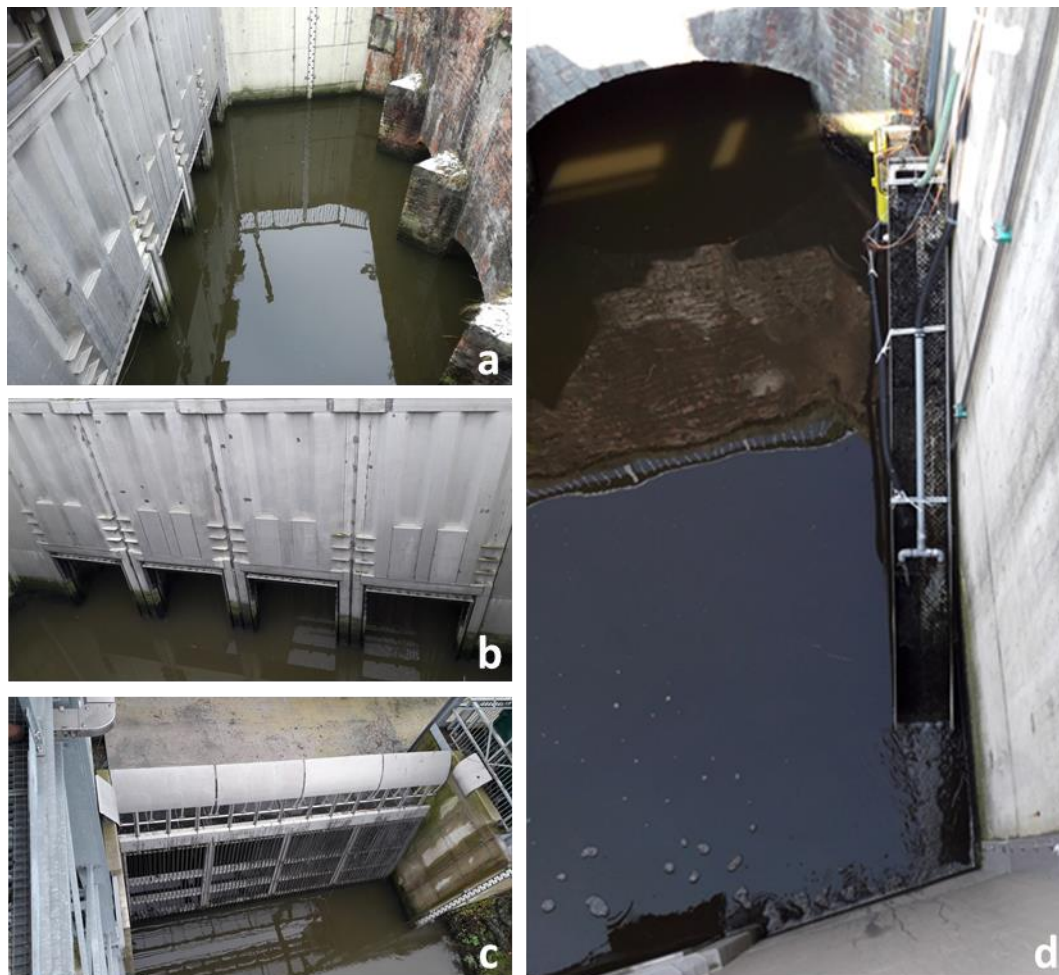
Figuur 11 Het terugslagkleppencomplex aan het Caemerlinckxgeleed met een beperkt niet-overdekt gedeelte tussen de terugslagkleppen (b) en een duiker (a, rechts in beeld) waar de glasaalgoot langs de rechterdamwand werd geplaatst (d). Het krooshekken bevindt zich aan de stroomopwaartse zijde van het complex (c).
