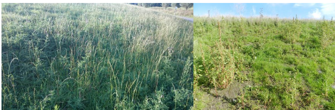
Figuur 79 Nieuwe dijk langs de Durme waar inzaaien met het geadviseerde mengsel succesvol is (19/09/2019) (links), en een nieuwe dijk langs de Zeeschelde waar dit niet het geval was (rechts) (28/09/2015).
