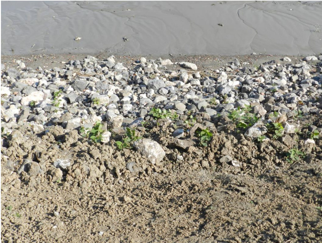
Figuur 71 Uitschietende Japanse duizendknoop ( Fallopia japonica ) op een pas aangelegde dijk doordat grond is gebruikt die besmet was met wortelstokken en/of stengels (02/10/2013).
