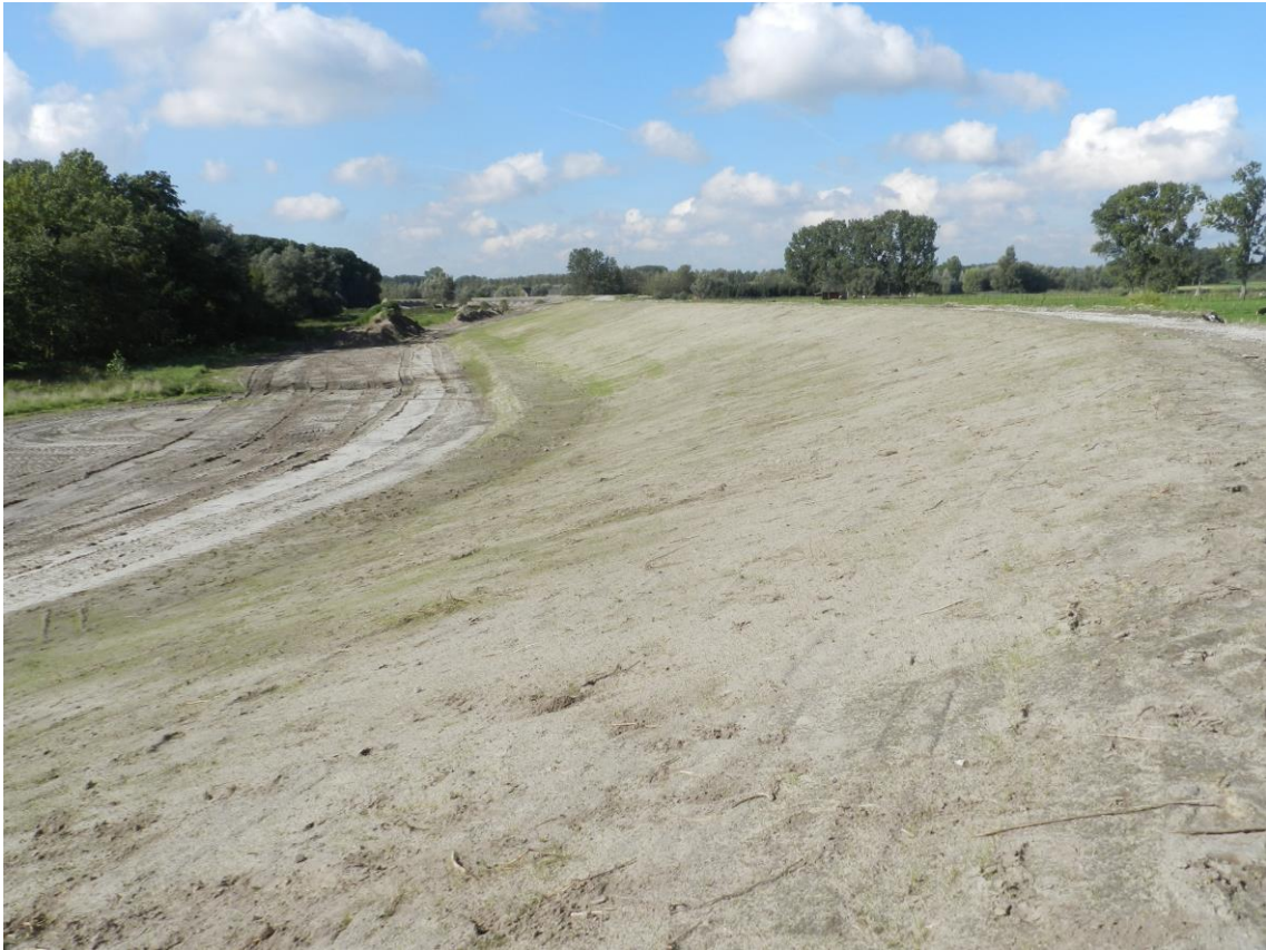
Figuur 16 Een pas ingezaaide dijktafsluiting zoals in Uitbergen (LO) zonder herkenbare vegetatie wordt bijvoorbeeld als Type 10 Andere beschouwd (28/09/2015).
