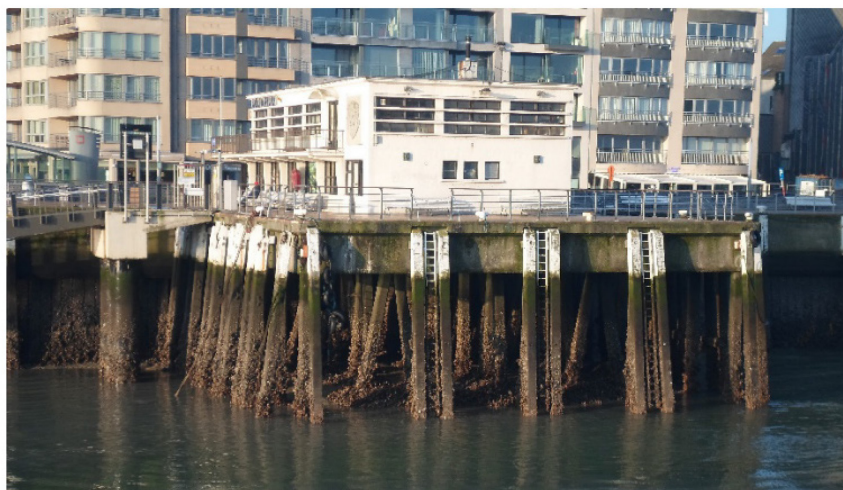
Figuur 1 – Noordzeeaquarium in Montgomerydok: uitstekend kaavlak op palen.
