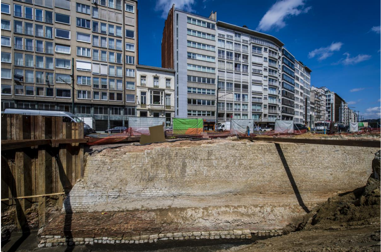
Figuur 6: De typische opbouw van de flank van bastion Huidevetterstoren, bij de opgraving in 2016 (© Stad Antwerpen, foto: Frederik Beyens).
