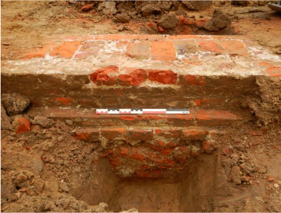
Figuur 7: Opbouw van de fundering aan de westzijde (buitenzijde) (© Lisa Van Ransbeeck).
