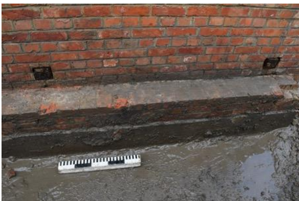
Figuur 12: De afgezaagde dwarsbalken in de muur die dienstdeden als ondersteuning van de houten zitbanken (© agentschap Onroerend Erfgoed).
