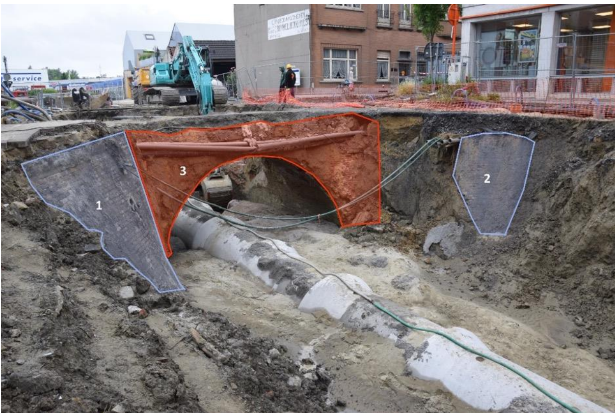
Figuur 6: Zicht vanuit het noordoosten op de vestingwerken van de stad (1), het ravelijn ten noorden van de Beverepoort (2) en de brug tussen beide (3) (© agentschap Onroerend Erfgoed).
