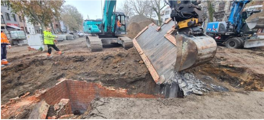
Figuur 3: De situatie op het terrein tijdens het weghalen van de bovenste betonplaat op 24 november 2021 (© Michael Vandenbergh).
