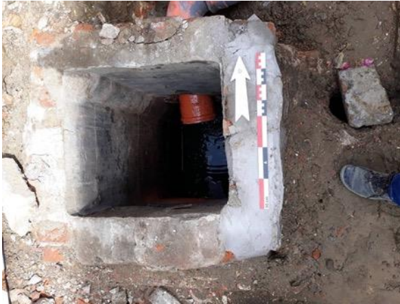
Figuur 7: Bovenzijde van het mangat boven op de citerne (© Tim Bellens).
