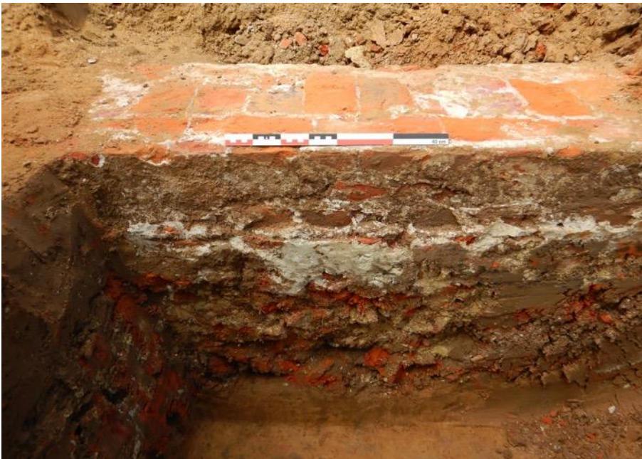
Figuur 8: Opbouw van de fundering aan de oostzijde (binnenzijde) (© Lisa Van Ransbeeck).
