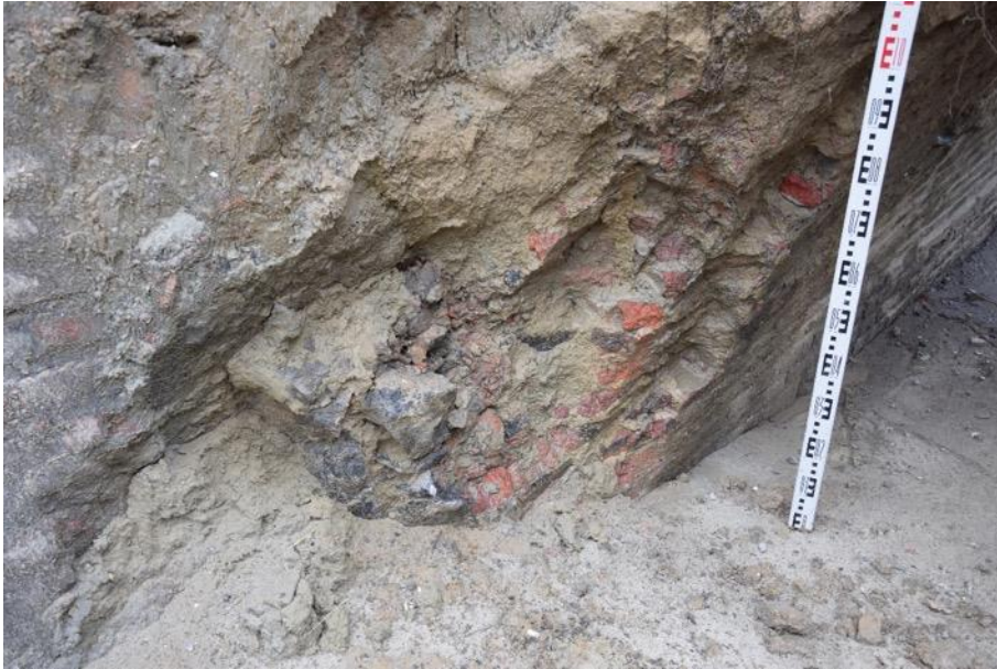
Figuur 7: Fundering van de brug tussen courtine en ravelijn (© agentschap Onroerend Erfgoed).
