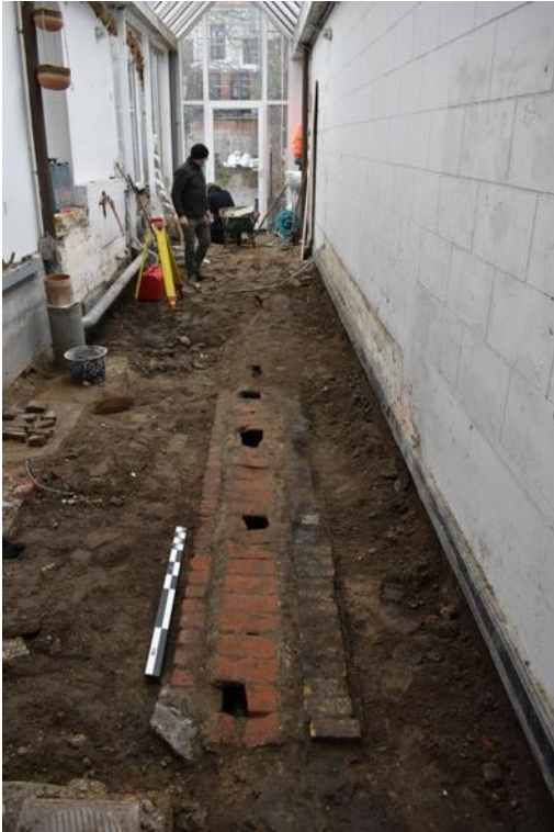
Figuur 4: Het afvoerkanaltje in de doorgang naar de tuin (© agentschap Onroerend Erfgoed).
