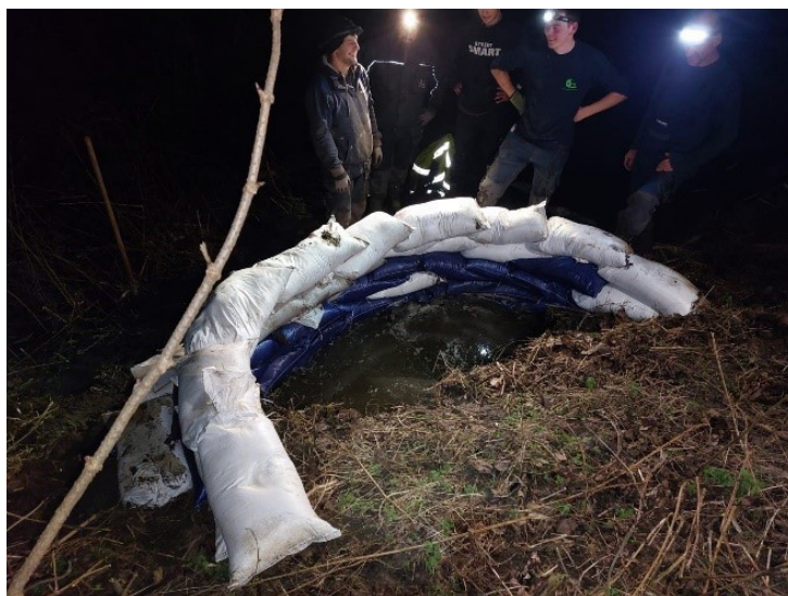
Figuur 41: Aanleg buitendijkse dammen bij doorsijpeling (bronnetje) doorheen Durmedijk in Zele Hoek op 3 en 4 januari 2024
