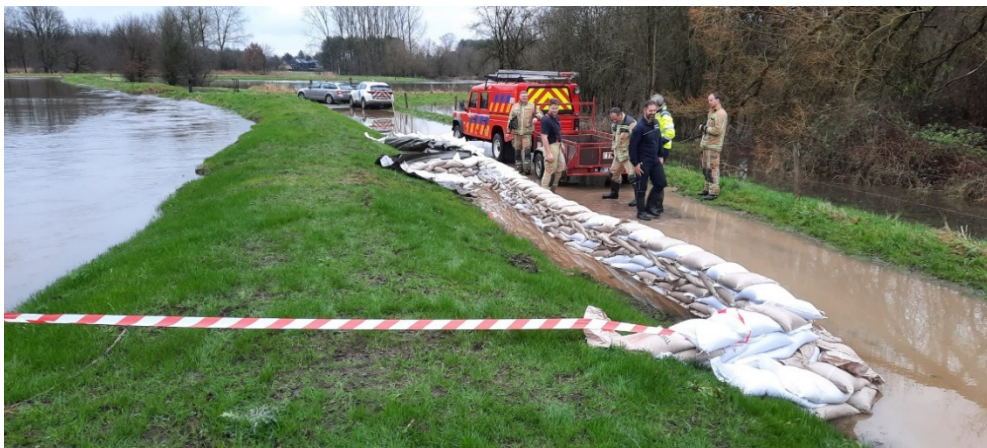
Figuur 69: Doorsijpeling en maatregelen aan Demerdijk Testelt (6 januari 2024)
