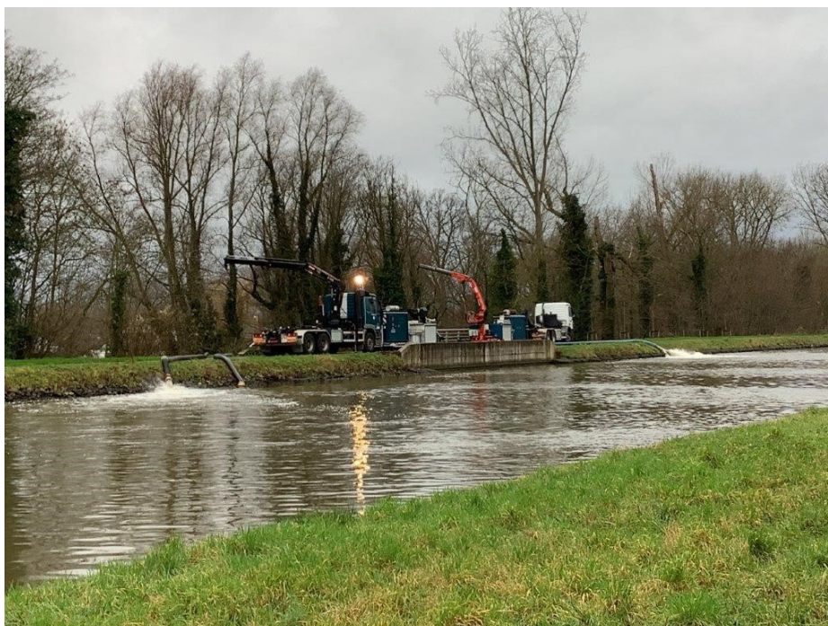
Figuur 70: Plaatsing van pompen van Barebeek naar het Kanaal Leuven-Dijle in Zemst door de Civiele Bescherming
