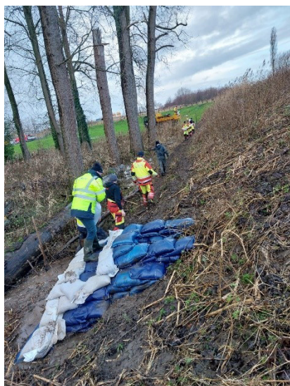
Figuur 41: Aanleg buitendijkse dammen bij doorsijpeling (bronnetje) doorheen Durmedijk in Zele Hoek op 3 en 4 januari 2024
