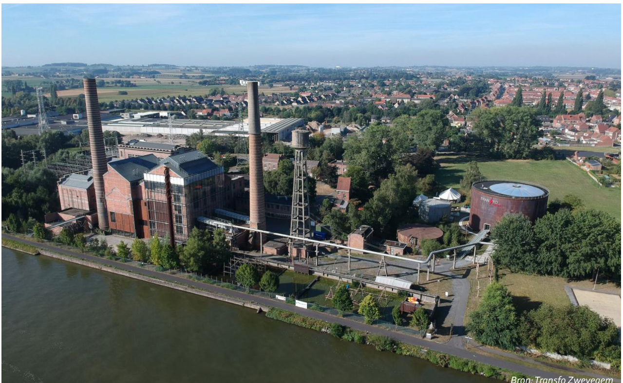
Bron: Transfo Zwevegem
