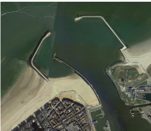
(c) 2 nieuwe havendammen zijn voltooid (Google Earth, 2018)
