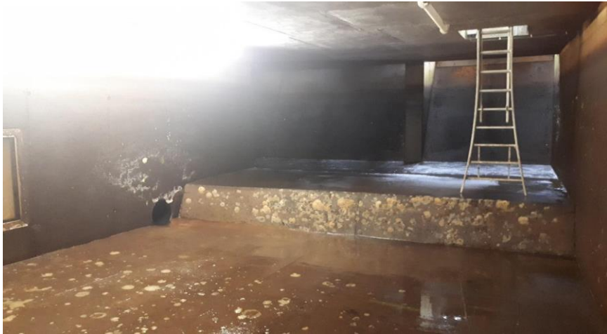
Foto 16: Vissen die stroomopwaarts tegen de stroming in migreren (i.e. gecreëerd door werkende vijzels) kunnen niet verder zwemmen dan tot aan de uitstroomopening van de vijzels. Deze ruimte bevindt zich onder het pompegebouw. Op vast ingestelde tijdsintervallen sluiten terugslagkleppen deze ruimte af en wordt een klep geopend in de zijwand van de muur en aansluitend op de bodem van deze afgesloten ruimte. Na openen van de klep stroomt het water met eventueel aanwezige vissen via de opening in de zijwand gravitair terug naar het Groot Schijn.
