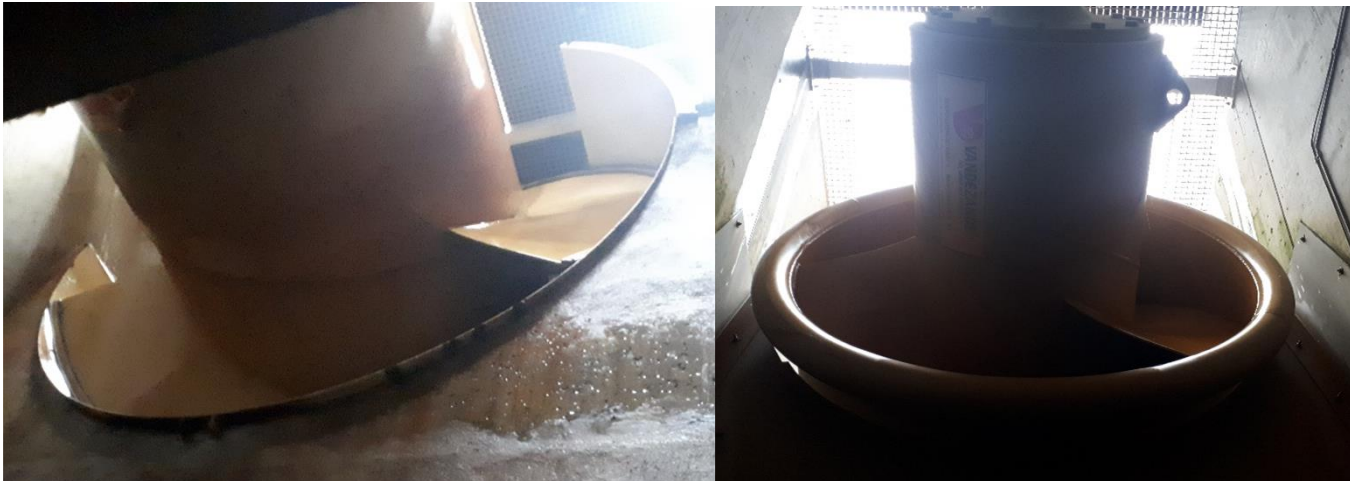
Foto 4: Close up van het opwaartse uiteinde van respectievelijk een stormvijzel (links) en een buisvijzel (rechts) van het PGGGS
