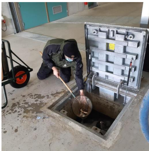
Foto 12: Bij elk testscenario werd een controlegroep van 50 individuen met een schepnet ingebracht in de uitstroom van de geteste vijzel. Via een luik in de vloer van het pompgebouw kon de vis eenvoudig ingebracht worden.
