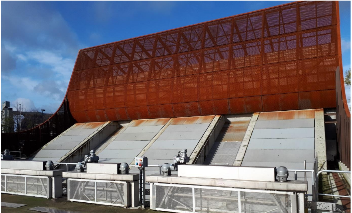
Foto 2: Het PGGs met onder de brede en smalle roosters respectievelijk verscholen de vier stormvizels en de twee buisvizels
