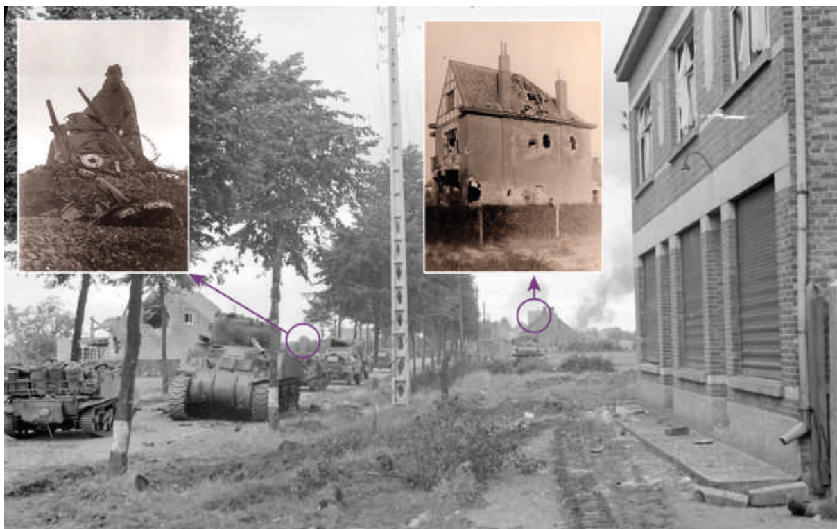
Figuur 102: een foto gemaakt op 10 september 1944 toont de aanval op het oosten van Helchteren. De woning rechts is het huidige nummer 32 aan de Kazernelaan (© Imperial War Museum en agentschap Onroerend Erfgoed).
