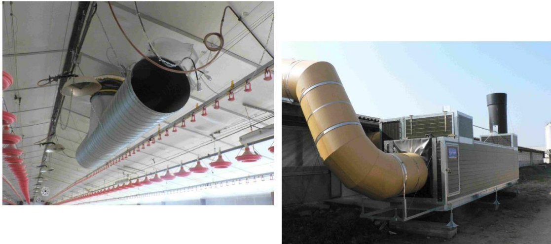
Figuur 6: Voorbeeld van warmtewisselaar voor pluimveehouderij met links de warme lucht die de wisselaar binnenkomt en rechts de warmtewisselaar. 44
