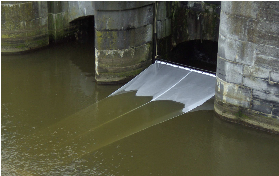
Fig. 5. Plaatsing van de fuij in een spui-opening van de IJzer, stroomopwaarts van het spuicomples.
