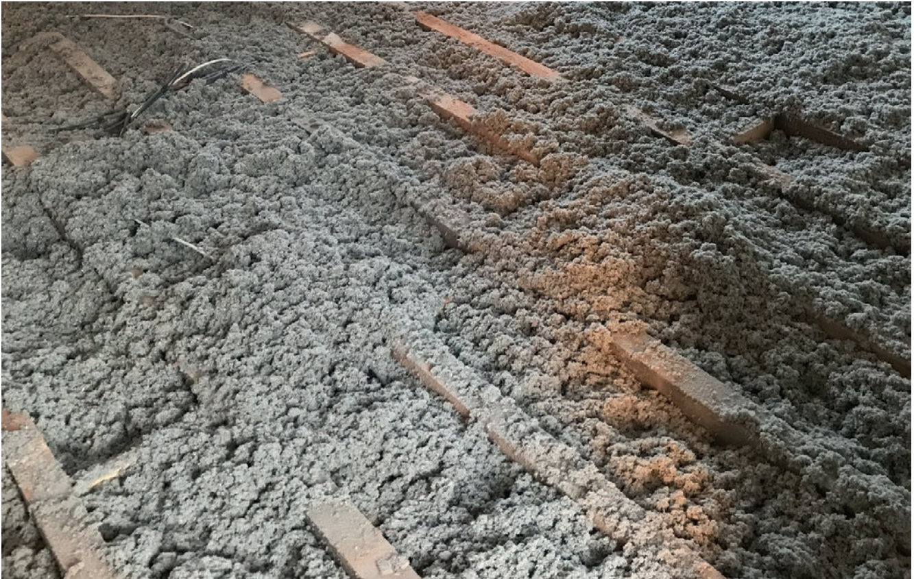
Ingeblazen cellulose in een houten vloer ter verbetering van het thermisch en akoestisch comfort
