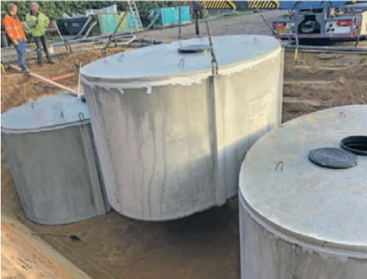
Figuur 3 Installatie van een hemelwaterput (bron: GEP)
