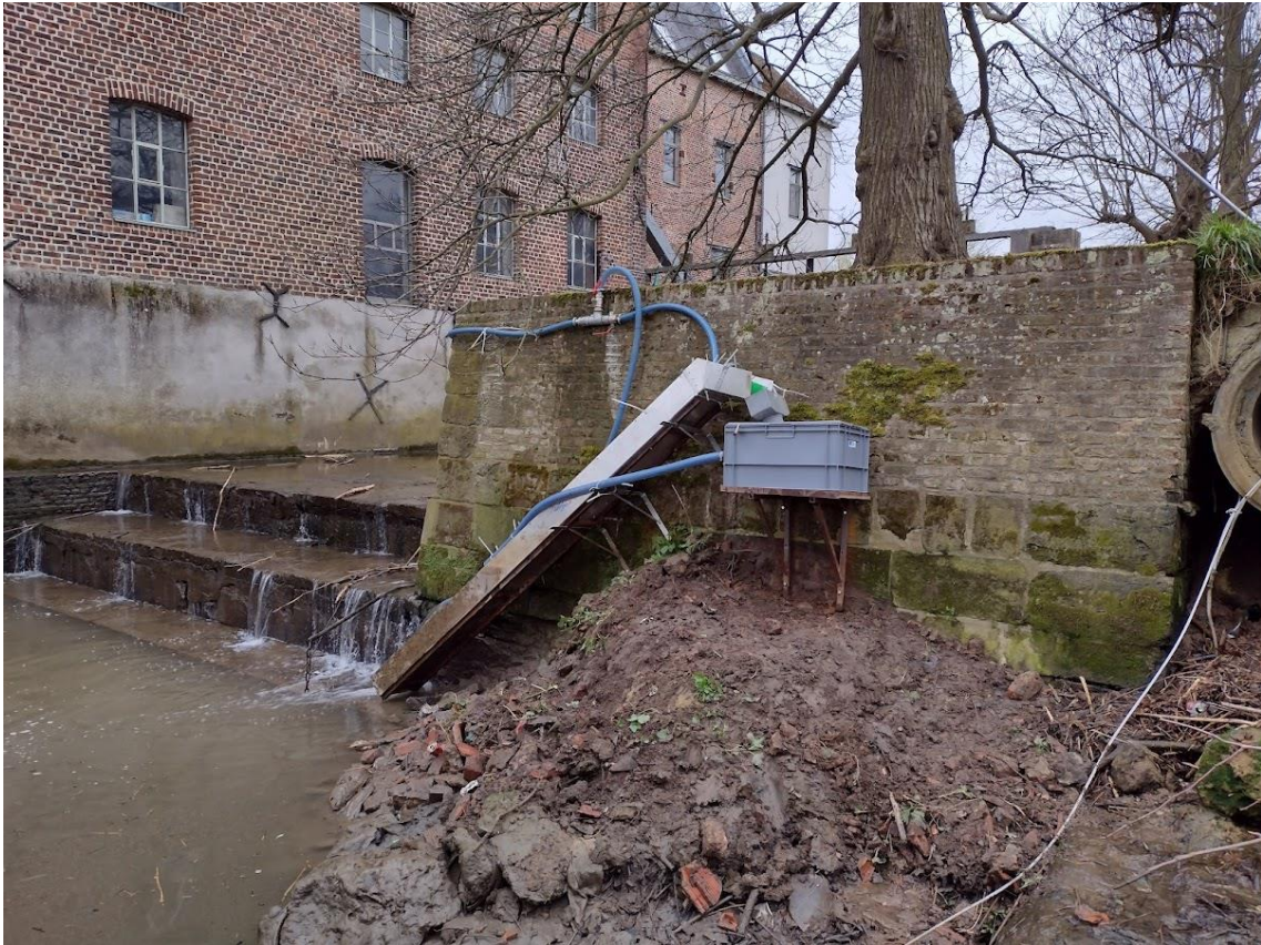
Figuur 70. Met een palinggoot (april 2022) in de turbinekom, net stroomafwaarts van de vaste stuw, wordt onderzocht of jonge paling naast de vistrap ook via een tweede migratiefaciliteit om de turbine in Rotselaar kan geleid worden.
