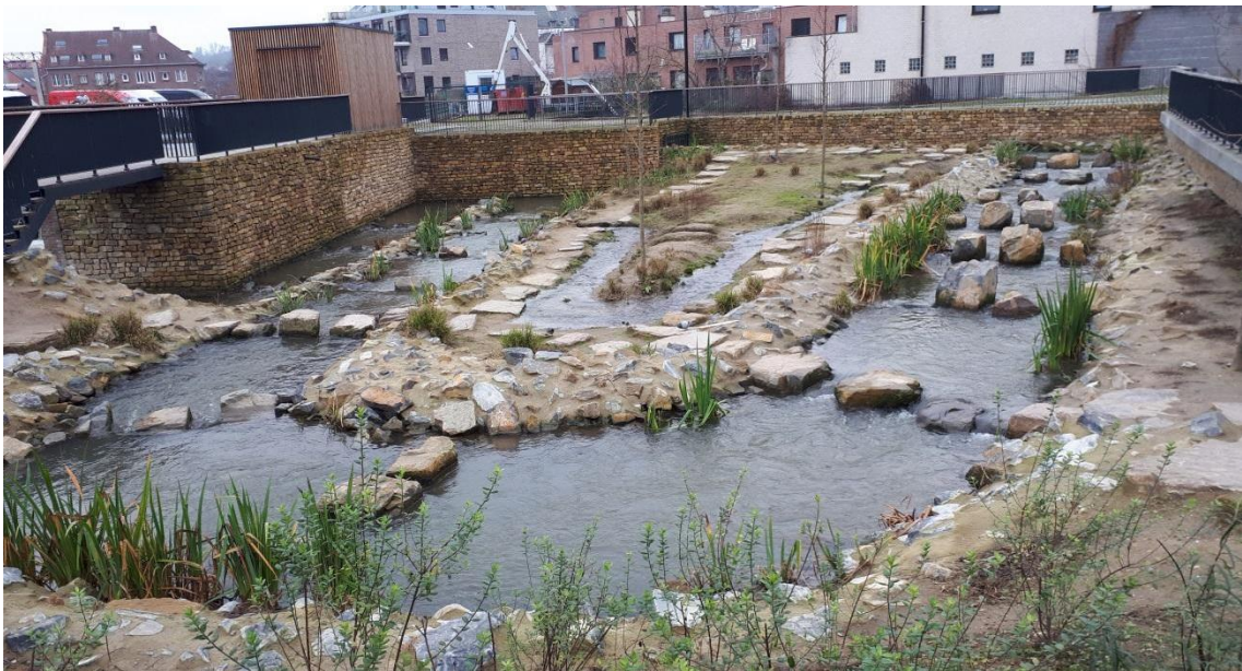
Figuur 9. De bekkenvistrap met grote stoorstenen op de 4 de arm van de Dijle ter hoogte van de sluismlen.
