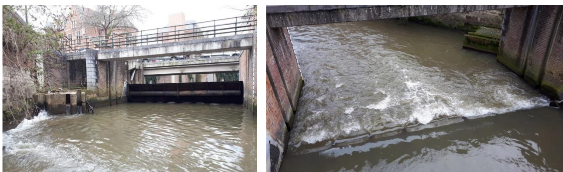
Figuur 5. De stuw Karel Van Lotharingen in Leuven wordt enkel in uitzonderlijke omstandigheden opgetrokken zoals bijvoorbeeld tijdens werkzaamheden voor de plaatsing van de visdetectieantennes (Links: stroomafwaarts zicht). Onder normale omstandigheden en in functie van vismigratie wordt ze maximaal neergelaten waardoor er nog een beperkt verval is (rechts: stroomopwaarts zicht).
