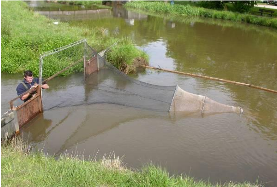
Figuur 10. Een vistrapfuike-vangconstructie bestaande uit roosters, inox kader en een fuik op de bekkenvistrap in de Kleine Nete in Herentals
