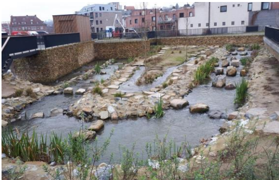
Figuur 17. De bekkenvistrap met grote stoorstenen op de 4 de arm van de Dijle ter hoogte van de sluismolen (Foto links) en stroomopwaarts van de meest stroomopwaartse drempel er een rooster met sponningen (Foto rechts). Stroomopwaarts van het rooster is de intake van de vispassage over enkele meters ingekokerd. De vistrapfuik werd in deze koker geplaatst en strak getrokken.
