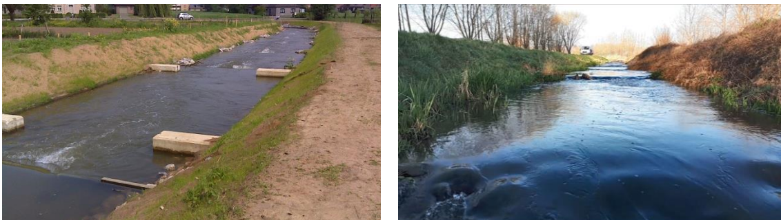
Figuur 3. De bekkenvistrap op de Dijle in Rotselaar vlak na realisatie (Links: stroomafwaarts zicht; Foto VMM) en verdrongen ruwe V-vormige stortstenen drempels van de vistrap in 2021 (rechts: stroomopwaarts zicht).
