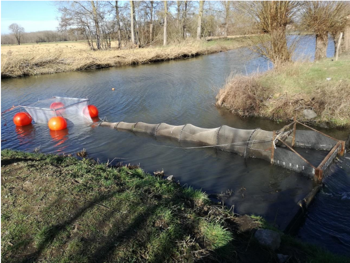
Figuur 16. Op de meest stroomopwaartse gesitueerde houten drempel van de vistrap in Rotselaar werd achtereenvolgens een kooi met beverrooster en een fuik met Noors leefnet bevestigd om stroomopwaarts migrerende vissen te vangen en bevers uit de fuik te weren.
