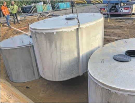
Figuur 3 Installatie van een hemelwaterput (bron: GEP)
