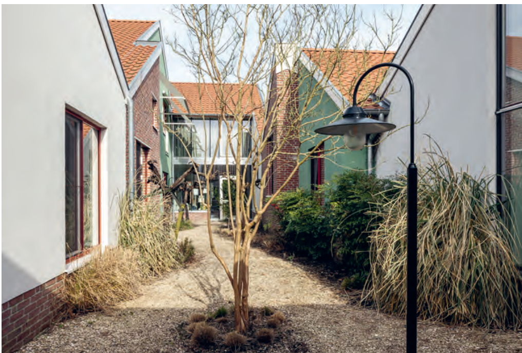
De binnentuinen brengen groen en licht tot in de kern van het gebouw.
