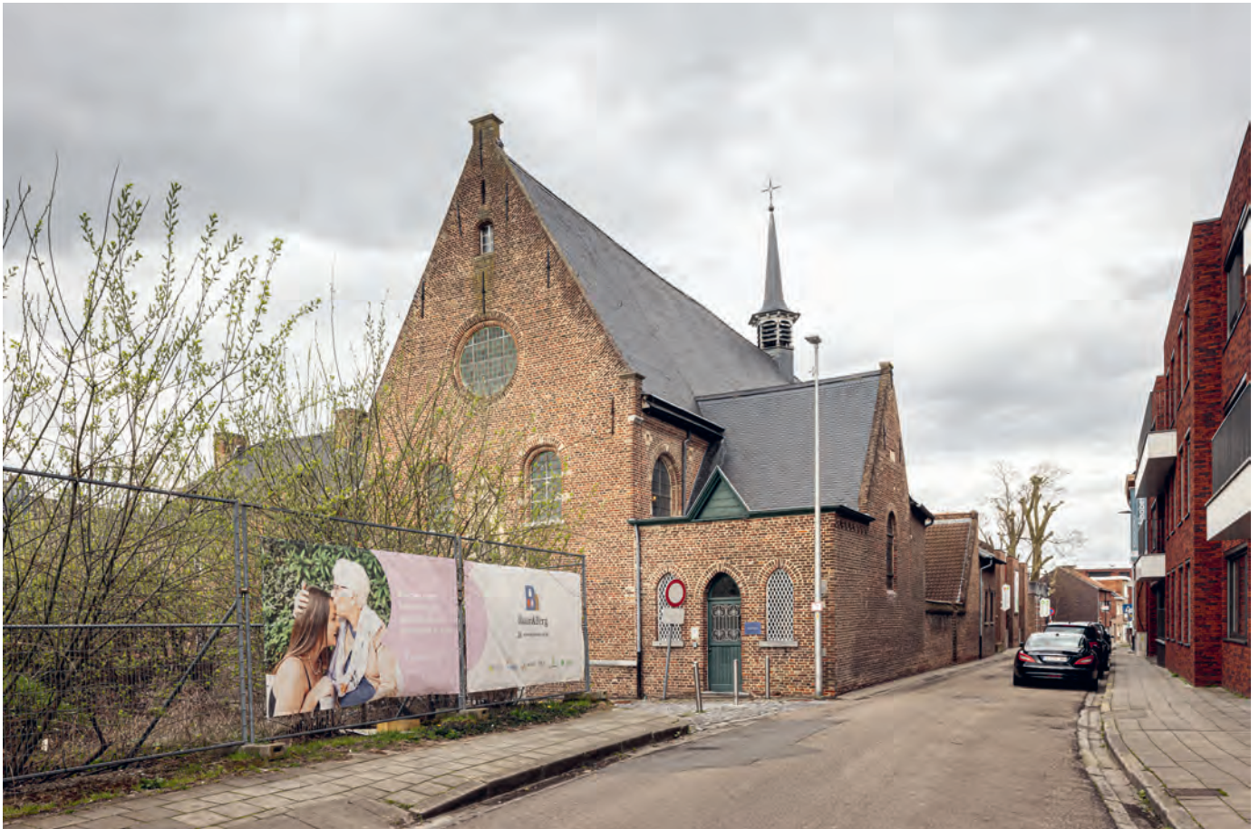
De kapel kreeg een nieuwe bestemming als ontmoetingsruimte van het OCMW. Het erfgoed krijgt een prominente plaats in het nieuwe stadsdeel.
