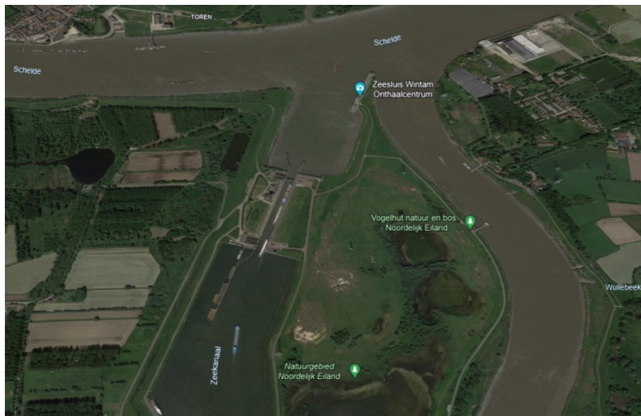
Figuur 1 – Situering sluis Wintam (Bron: Google Earth)
