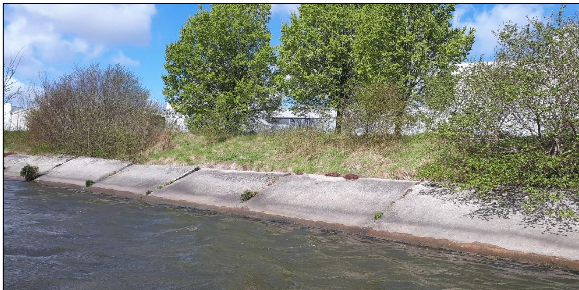
Foto 9. Verharde oevers met betonplaten ter hoogte van traject 8.
