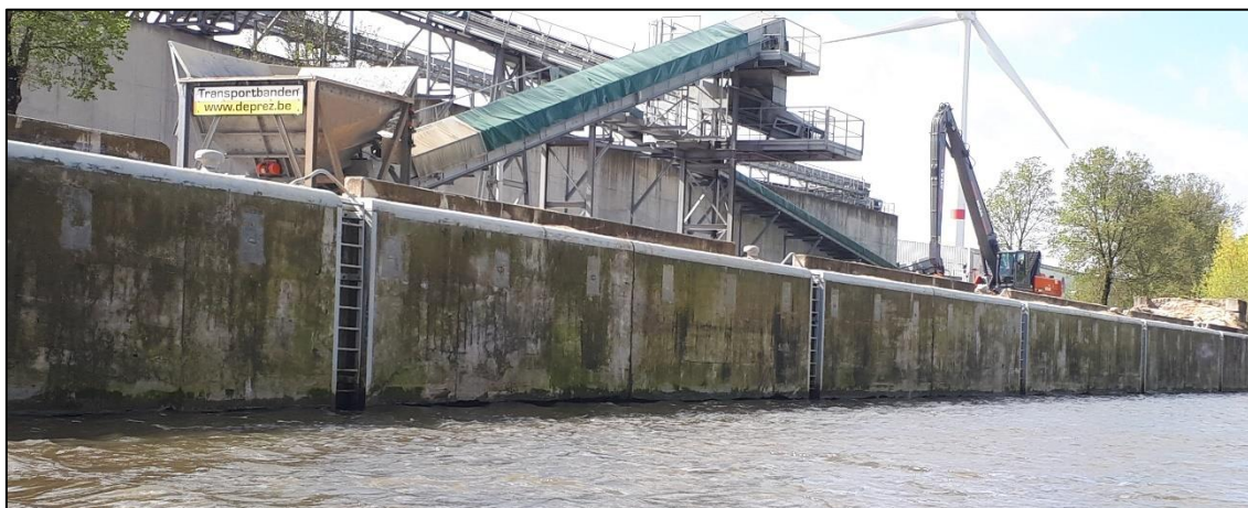
Foto 10. Kaaimuren ter hoogte van traject 7.
