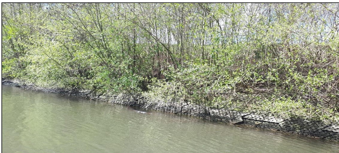
Foto 5. Doorgroeitegels ter hoogte van traject 21.
