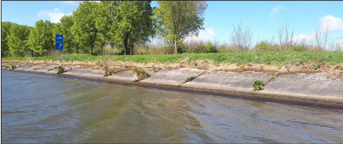
Foto 1. Betonoevers ter hoogte van traject 2.
