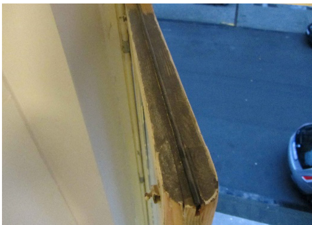
Hersteld raam met toevoeging van kierdichting, Brussel
