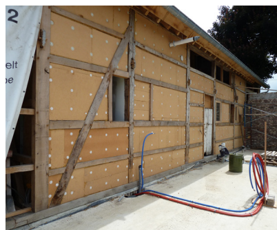
Na-isolatie in een vakwerkconstructie van een hoeve in Alken
