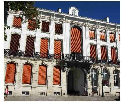
Opnieuw gemaakte historische zonnewering. Tienen, Muziekacademie
