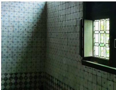
Het aanbrengen van isolatie is niet aangewezen voor deze kamerhoge bekleding van wit-blaauwe geglazuurde tegels. Het risico op materiaalverlies is te groot. Achterhuis Den Doorenboom, Antwerpen
