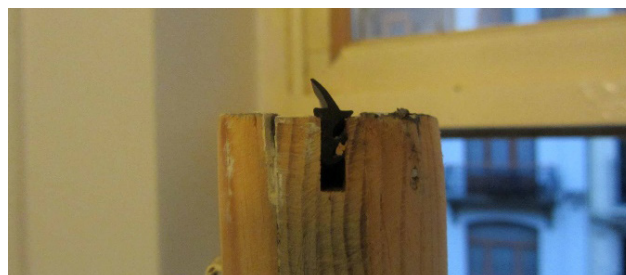
Plaatsen van een tochtstrip als kierdichting in een bestaand raam. Brussel
