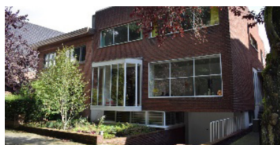
Uitkragende vloer en erker in het modernistisch burgerhuis naar ontwerp van architect Nachman Kaplansky, Deurne
