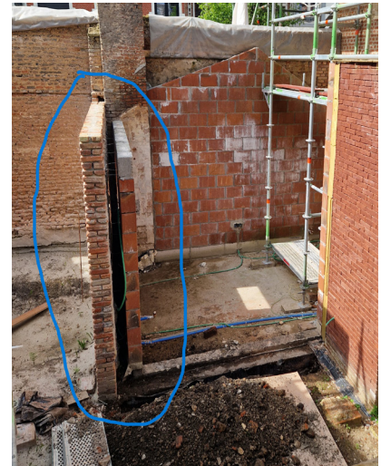
Bij de renovatie van deze begijnhofwoning in Lier is ervoor gekozen om muurwerk met stabiliteitsproblemen te ont-dubbelen aan de binnenzijde. In de spouw komt isolatie.
