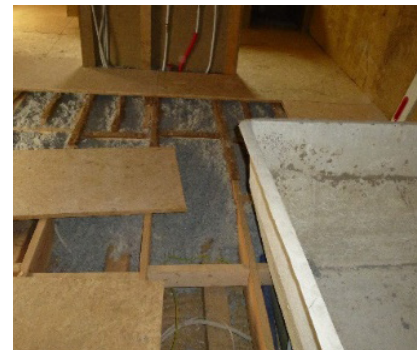
Een nieuwe houten structuur, opgevuld met 20 cm papier-vlokken onttrekt de historische vloer aan het zicht.
