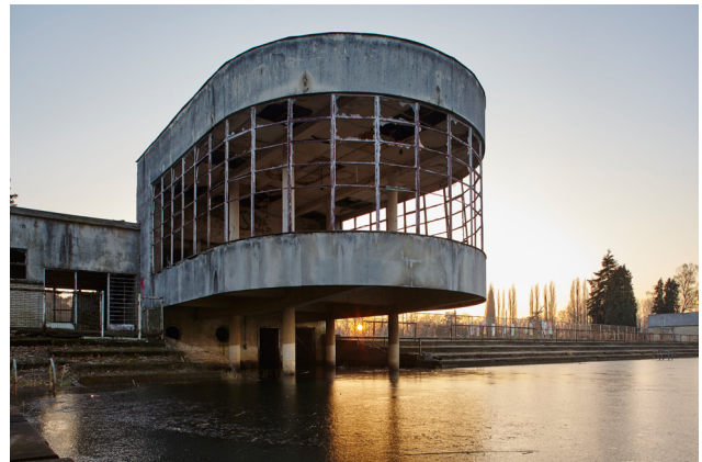
De cafetaria van het openluchtzwembad in het domein Hofstade is uitgevoerd in gewapend zichtbeton
