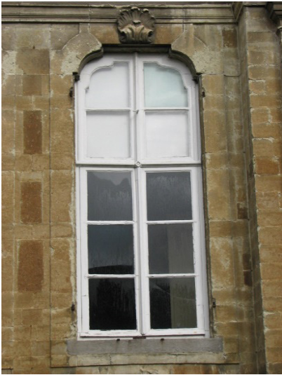
Priesterhuis uit 1756, beschermd omwille van de artistieke waarde. Het schrijnwerk volgt de 18de-eeuwse vormgeving van de raamopening met schouderstukken. Groot-Bijgaarden, Wivina-abdij
