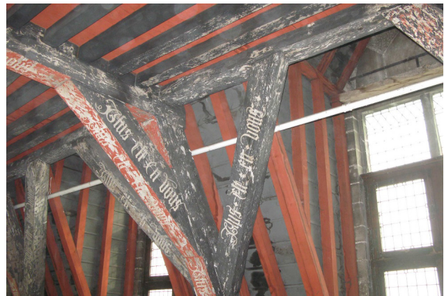
In de neogotiek werden in het Gruuthusemuseum de spanten beschilderd in rood en zwart en voorzien van het devies Plus est en vous. Het spreekt voor zich dat deze afwerking zichtbaar blijft. Brugge, Gruuthusemuseum
