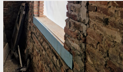
Na-isolatie ter hoogte van de doorlopende vensterdorpel om een koudebrug te voorkomen. Lier, Begijnhof
