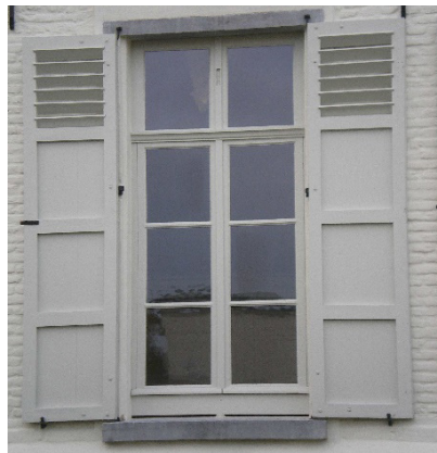
Hetzelfde raam na restauratie. Meuzegem, pastorie FREDERIK MAHIEU, ONROEREND ERFGOED
