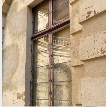
In deze deur bleef historisch glas bewaard. Een deel werd vernieuwd door hedendaags floatglas. Bemerkt het verschil. Italië, Kasteel Montemagno
