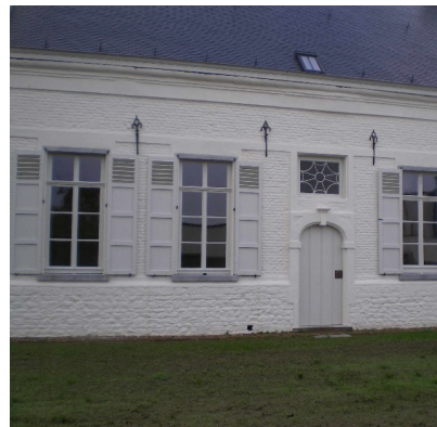
Het historische schrijnwerk (ramen, historisch glas, luiken) bepaalt in belangrijke mate de erfgoedwaarde van deze gevel. Meuzegem, pastorie
