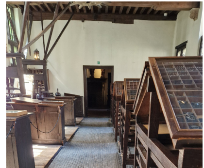
Bakstenen vloeren zijn vaak toegepast in werk- en atelier-ruimtes zoals in de drukkerij van Plantijn Moretus
