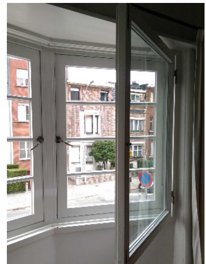
Eenvoudig houten achterzetraam. Wilrijk, Cederlaan
