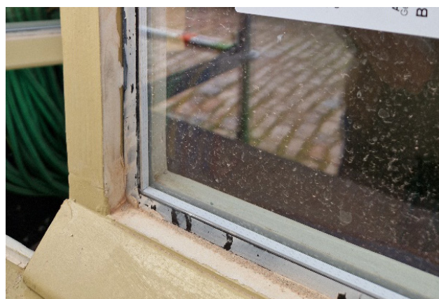
Detail van nieuw dun dubbel glas in bestaand schrijnwerk. Lier, Begijnhof
