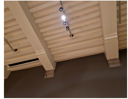
De stenen consoles onder de moerbalksloffen verdwijnen deels in de nieuwe wandafwerking, Mechelen, Hof van Busleyden
