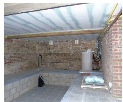
De vloer boven de kelder is geïsoleerd met rotswol tussen de houten vloerliggers.
