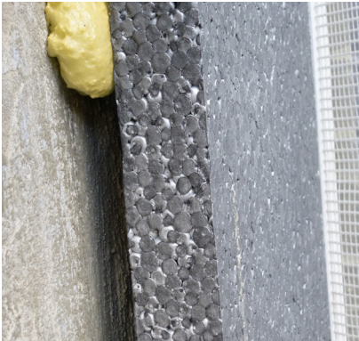
Op de historische pleister van deze achtergevel worden dunne isolatieplaten aangebracht.
