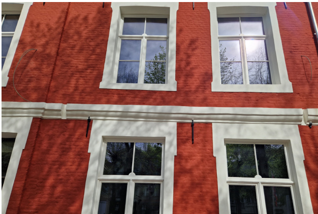
Geschilderde bakstenen gevel, Brugge
