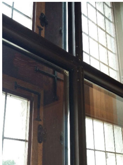
Herstelde historische ramen met bijkomende schuifsluitingen aan opendraaiende vleugels en een stalen achterzetraam. Hasselt, poortgebouw Herkenrode-abdij
