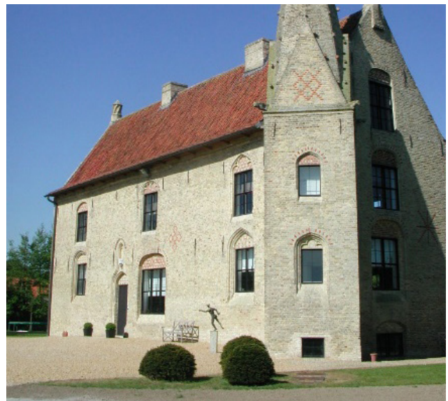
Bij de restauratie werd gekozen voor hedendaags stalen schrijnwerk. Westvleteren, Eikhoekstraat.
