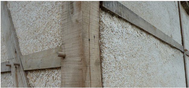
Na-isolatie van een vakwerkwand
