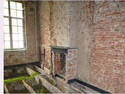
Houten vloer met kruipkelder
