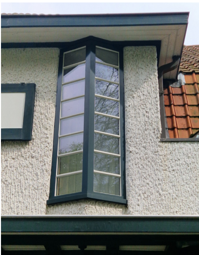
Deze originele gerotste bepleistering is handmatig aangebracht en typerend voor de Unitastuinwijk in Deurne
