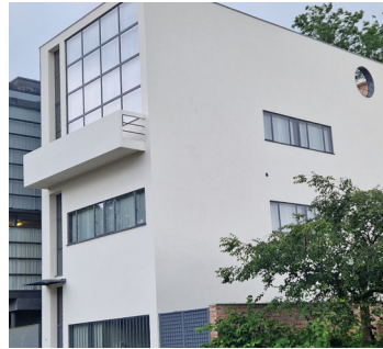
De aansluitingen van de verschillende gevel-elementen vormden een uitdaging voor de isolatie van het huis Guiette van Le Corbusier,
