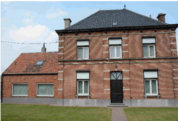
Woning voor restauratie. Deinze, Lindestraat.
