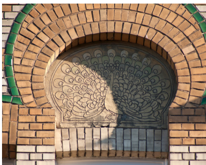
Sgraffito, een bijzondere vorm van gevelafwerking die typerend is voor art-nouveau-architectuur
