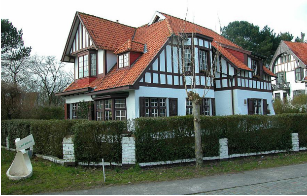
Het is aangewezen bij dit dak de verhoudingen tussen de dakvlakken te respecteren, de aansluitingen met boordplanken en goten ongewijzigd te laten en dus niet in opbouw te isoleren. De Haan, tuinwijk De Concessie, cottage l'Ermitage
