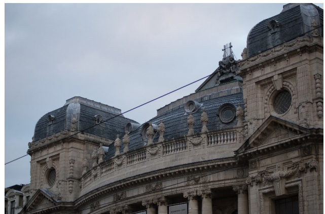
De overdadig gedecoreerde daken illustreren mee de artistieke waarde. De Vlaamse Opera vormt samen met het voormalige schermenmagazijn en hotel Wagner, een architecturaal geheel. Antwerpen, Vlaamse Opera
