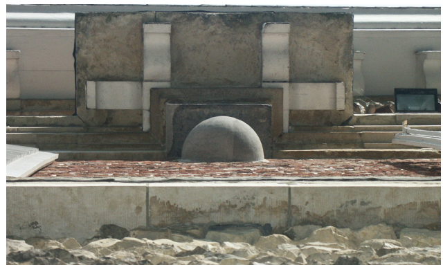
Het samenspel van rustica, dorpel, baksteen, console en kroonlijst sluit een buitenisolatie uit. Jachtpaviljoen van het kasteel van Hingene,
