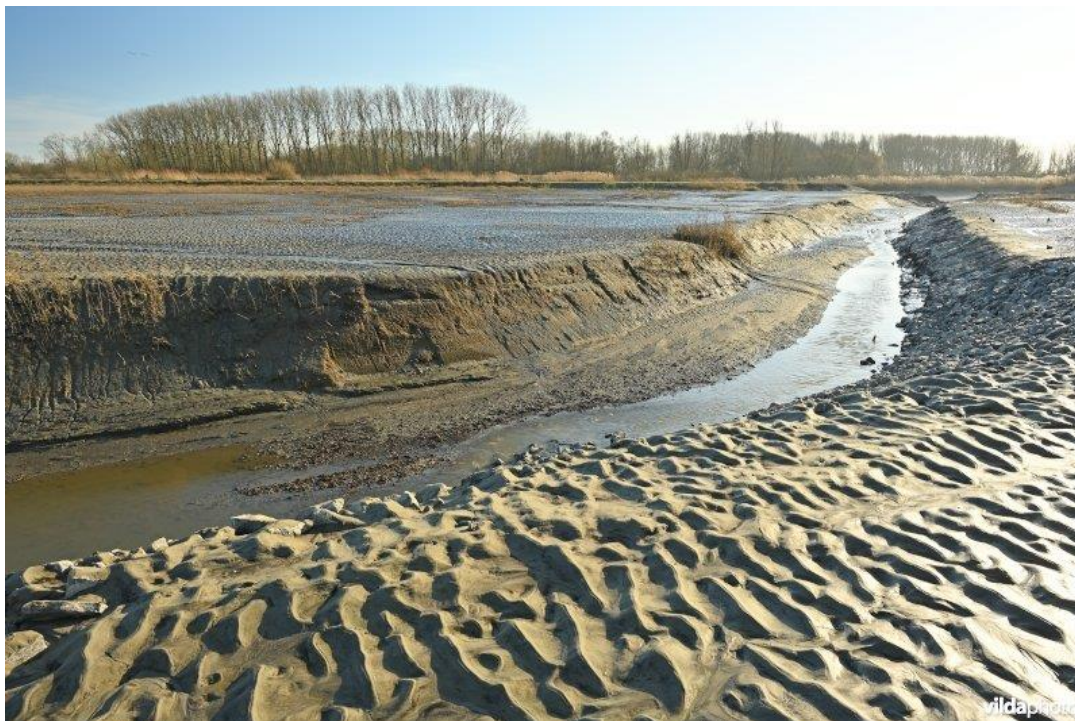
Figuur 9. uitgegraven hoofdkreek in Klein Broek na ontpolderen. Extra waterdynamiek wordt zo in het gebied toegelaten.
