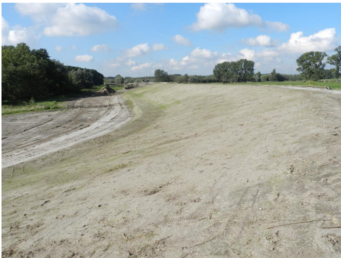
Figuur 20 Een pas ingezaaid dijktafvlak zoals in Uitbergen (LO) zonder herkenbare vegetatie wordt bijvoorbeeld als Type 10 Andere beschouwd (28/09/2015).
