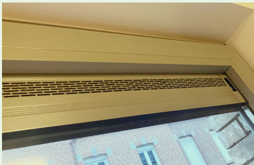
/ Voorbeeld van een manueel regelbare toevoeropening
