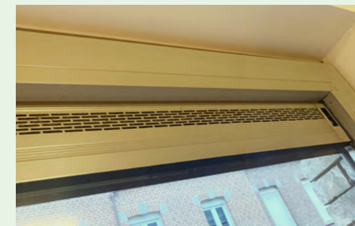
/ Voorbeeld van een manueel regelbare toevoeropening
