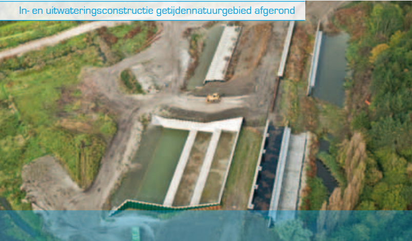
In- en uitwateringsconstructie getijdennatuurgebied afgerond
