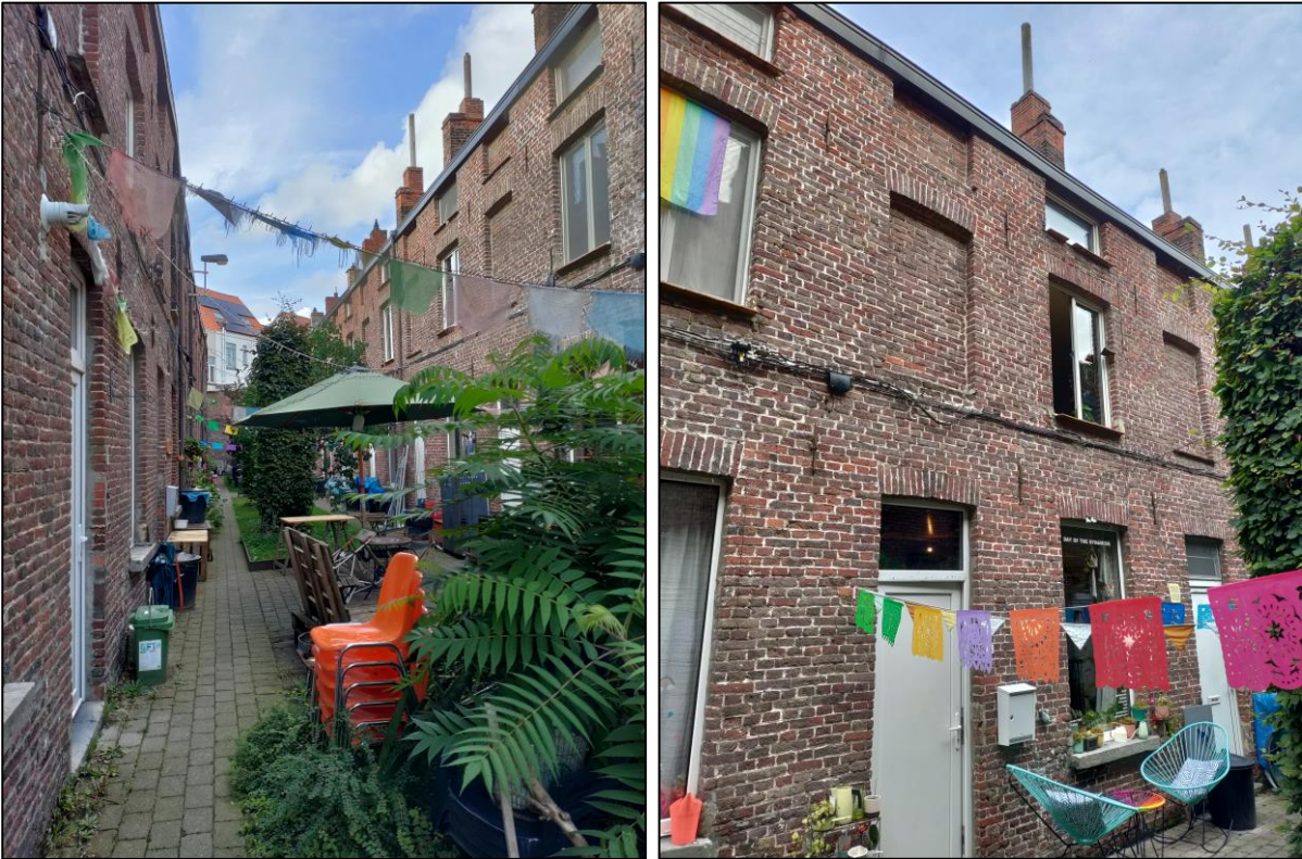
Figuur 174: beeld van voorgevels in het steegbeluik (Buildwise)
