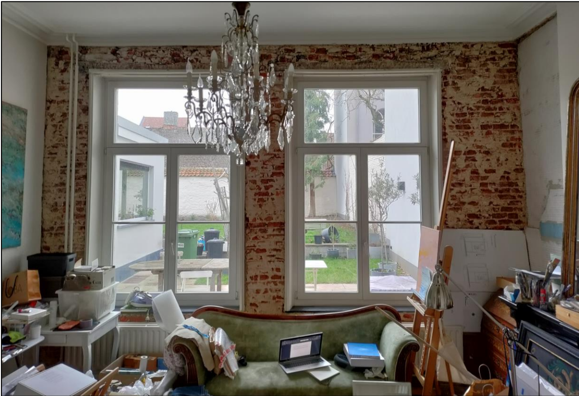
Figuur 29 Eetkamer achteraan het gelijkvloers: deze ruimte wordt deels als atelier en werkruimte gebruikt. De achtermuur is ontdaan van pleister na vochtproblemen. (Foto: Buildwise)
