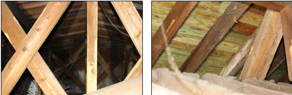
Figuur 78 De spanten in de noordoostelijke vleugel nemen de ruimte in tussen de plafonds van de zolders en het leien en zinken dak. Ze zijn opgebouwd als een soort vakwerk in naaldhout. De bebording is recent vervangen (rechts). (Foto: Buildwise)
