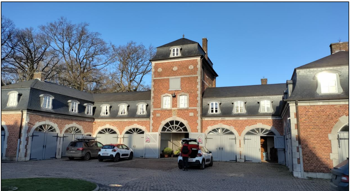
Figuur 74 Voormalig wagenhuis, waarin enkele appartementen ondergebracht zijn. (Foto: Buildwise)
