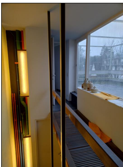
Figuur 48: Zicht op de open leidingenschacht en open trapkern (Foto's: Daidalos Peutz bouwfysisch ingenieursbureau).
