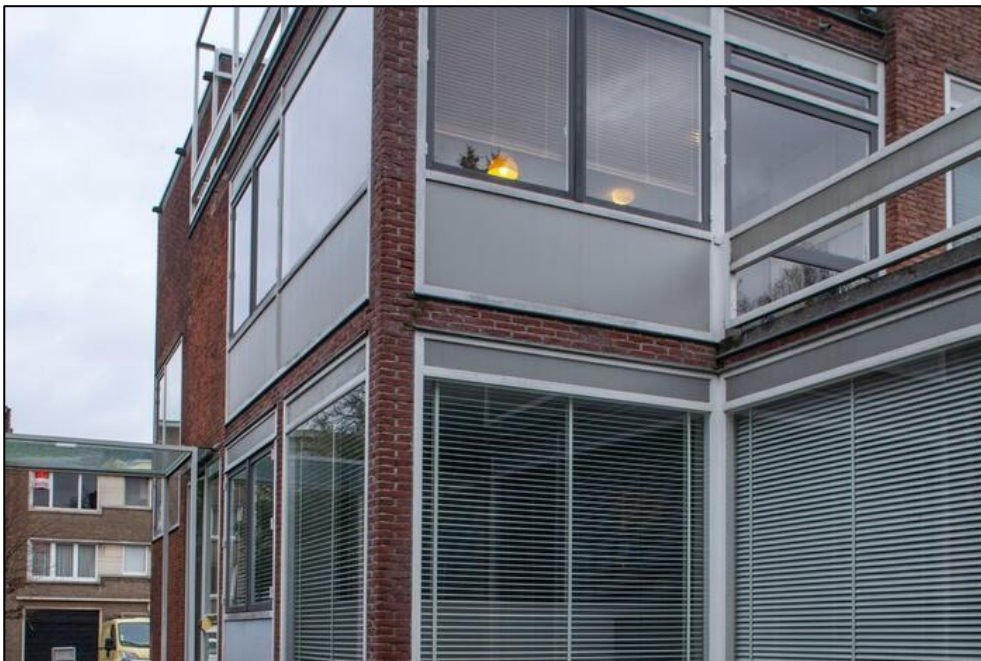
Figuur 47: Zicht vanuit het zuidwesten op de achtergevel en zijgevel met de grote atelierramen. Bestaande optrekbare binnenzonwering (Foto: Daidalos Peutz bouwfysisch ingenieursbureau).
