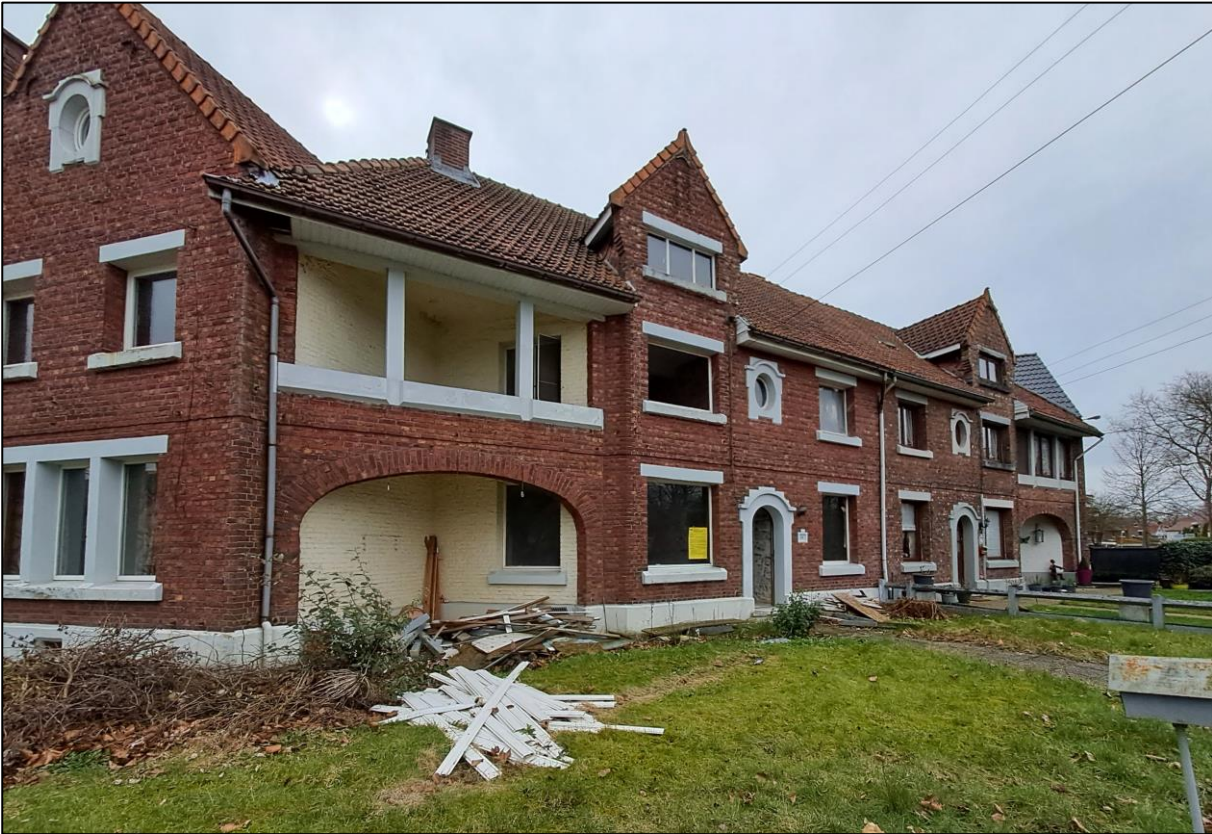
Figuur 100 Voorgevel van de tuinwijkwoning bij aanvang van de renovatiewerken. (Foto: Buildwise)
