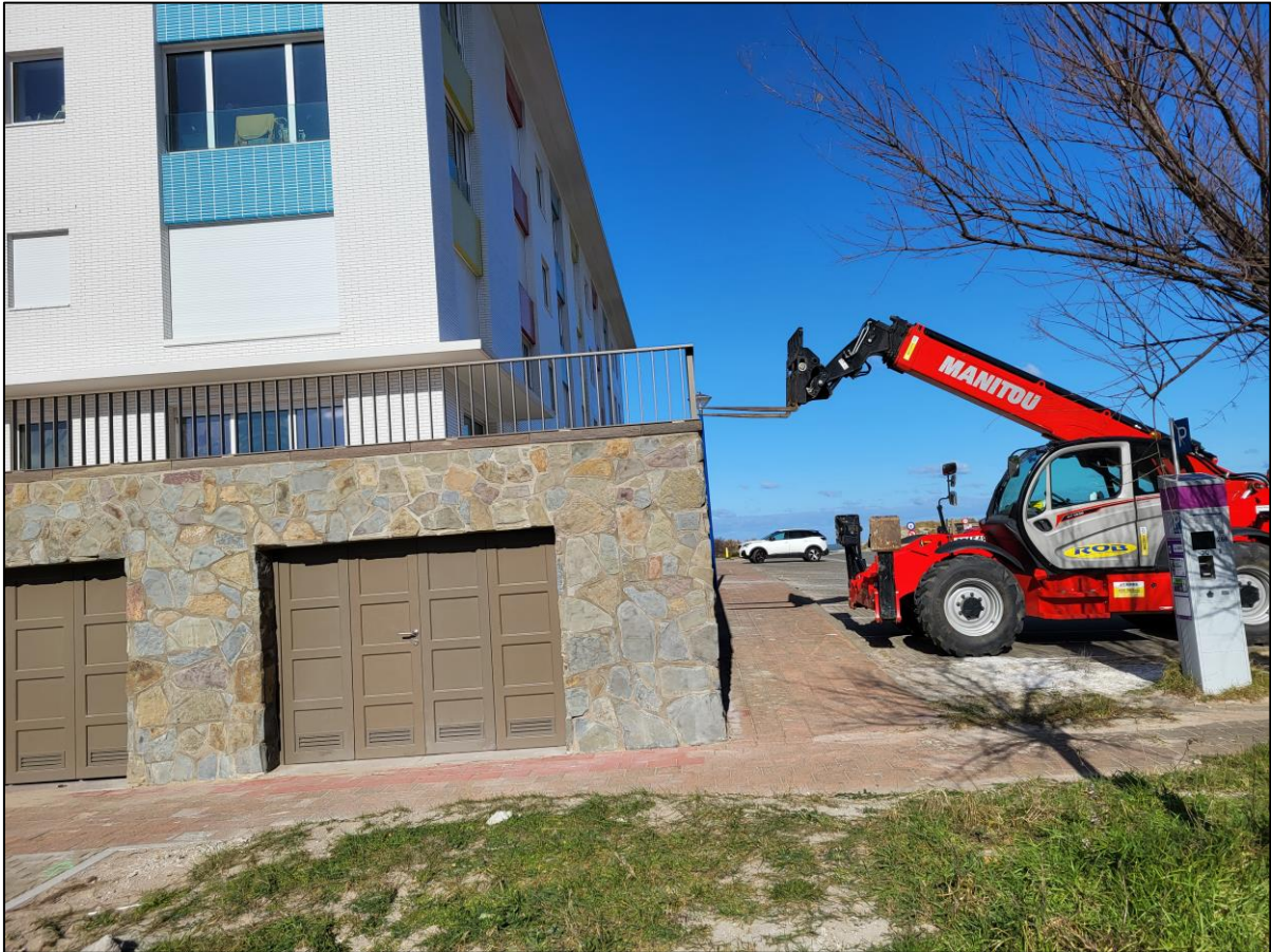
Figuur 139: parking naast het gebouw waar geothermische boringen mogelijk zijn
