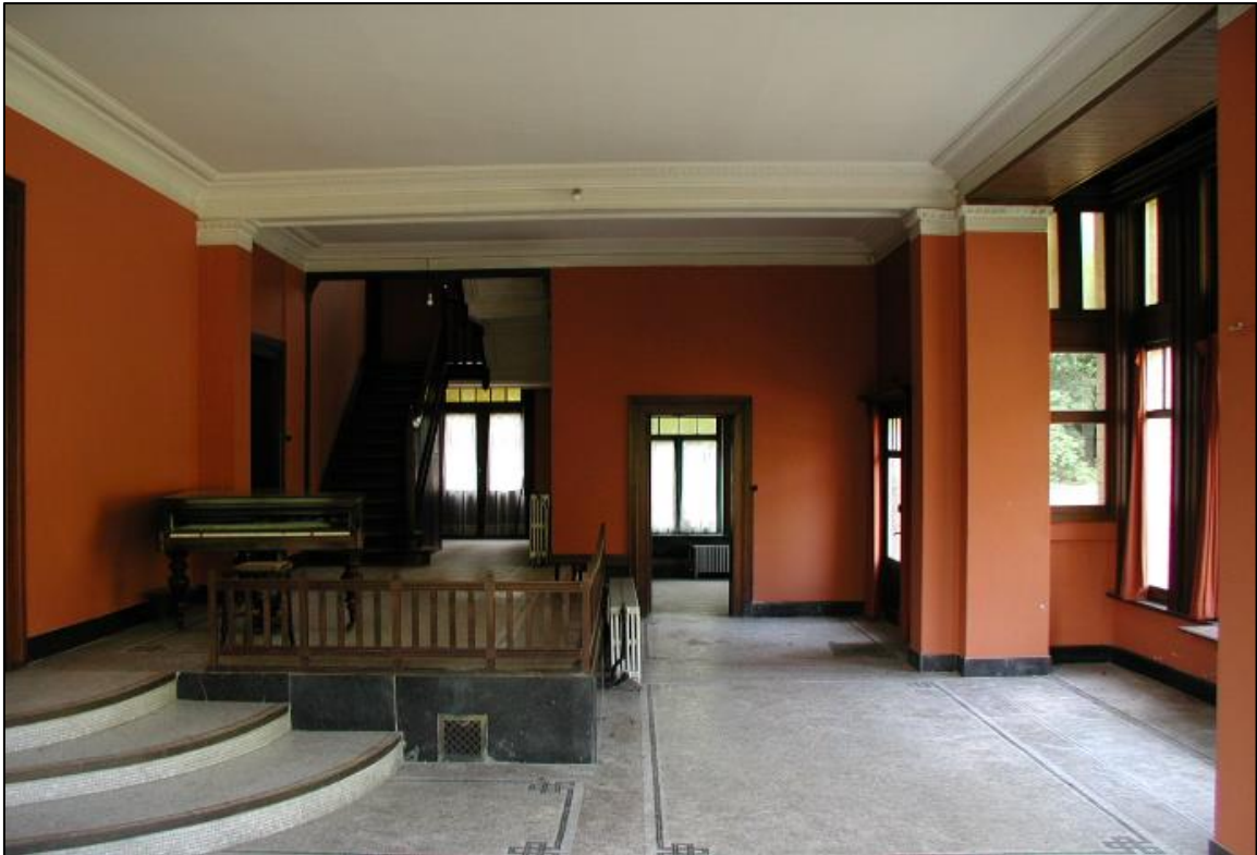
Figuur 145 De pianozaal met originele vleugelpiano, terrazzovloeren afgelijnd met mozaïek, origineel schrijnwerk en lijstwerk. (Bron: archief eigenaar)
