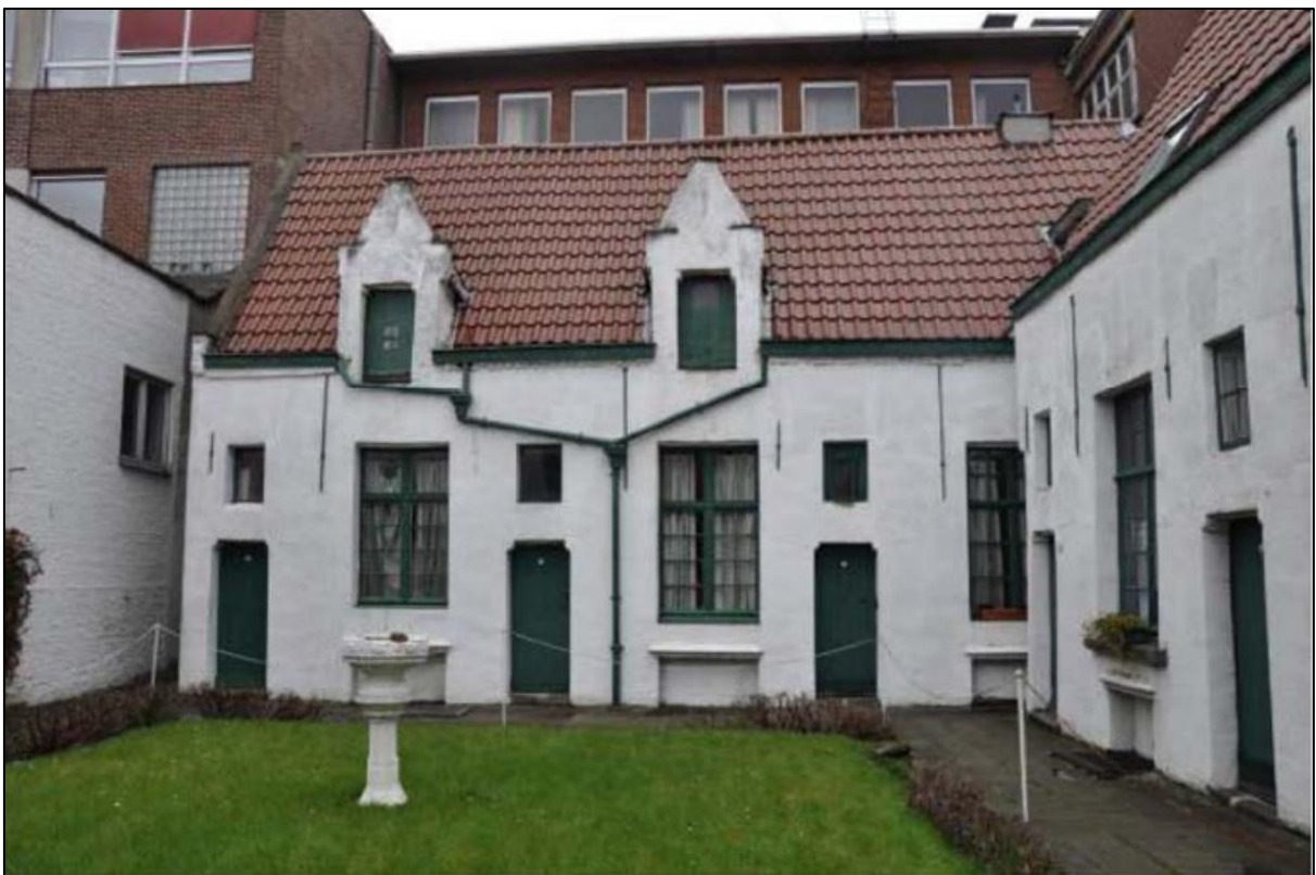
Figuur 119. Gevelaanzicht Godshuis Sint-Barbara (Daidalos Peutz bouwfysisch ingenieursbureau)
