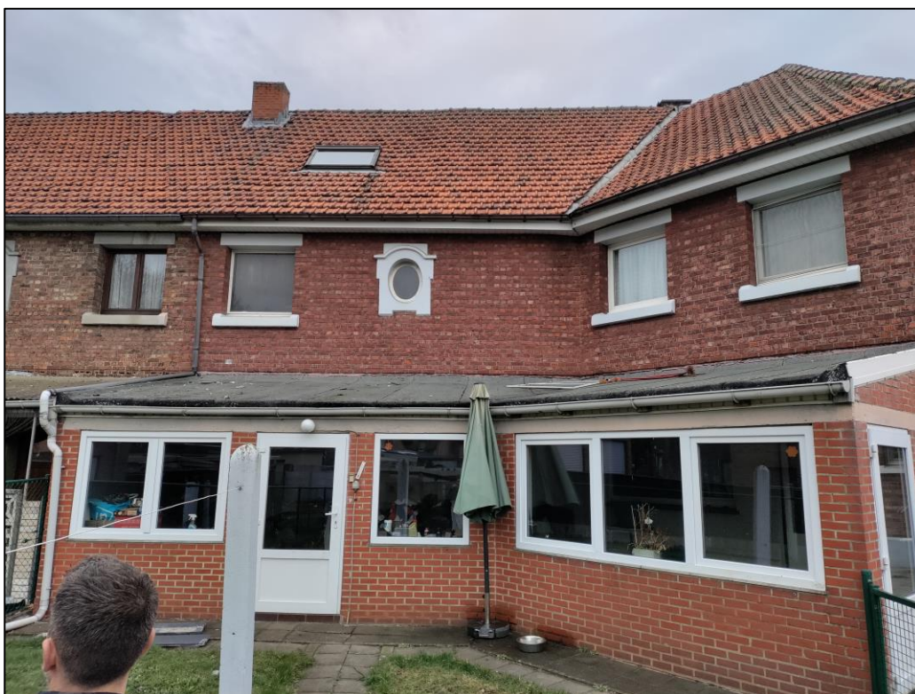
Figuur 103 Achtergevel met ossenoog ter hoogte van de overloop. De aanbouw is niet authentiek en loopt in bestaande toestand door tegen het huis van de buur. (Foto Buildwise)
