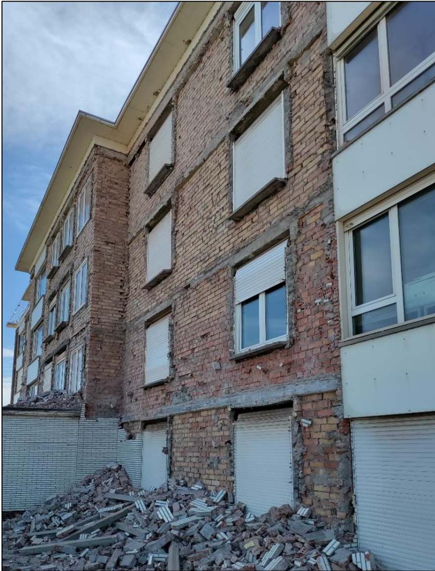
Figuur 130 Werfbeeld na de afbraak van het buitenspouwblad (september 2021) (Foto: Buildwise).
