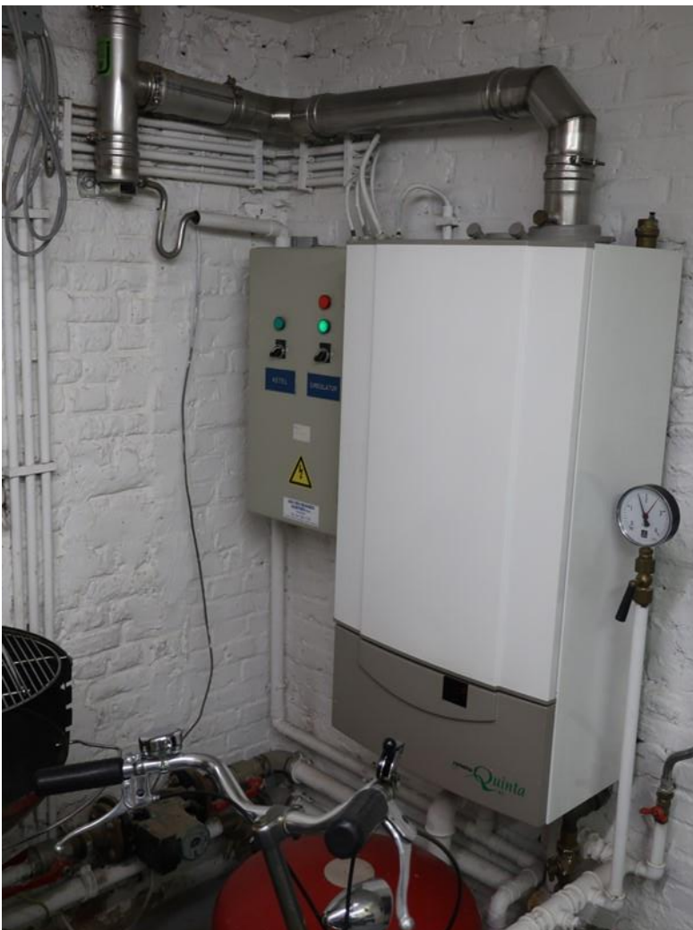
Figuur 57: opstelling van de condenserende gasketel op het onderste niveau, met aansluiting op het schouwkanaal (Foto: Maarten Van Dijck).
