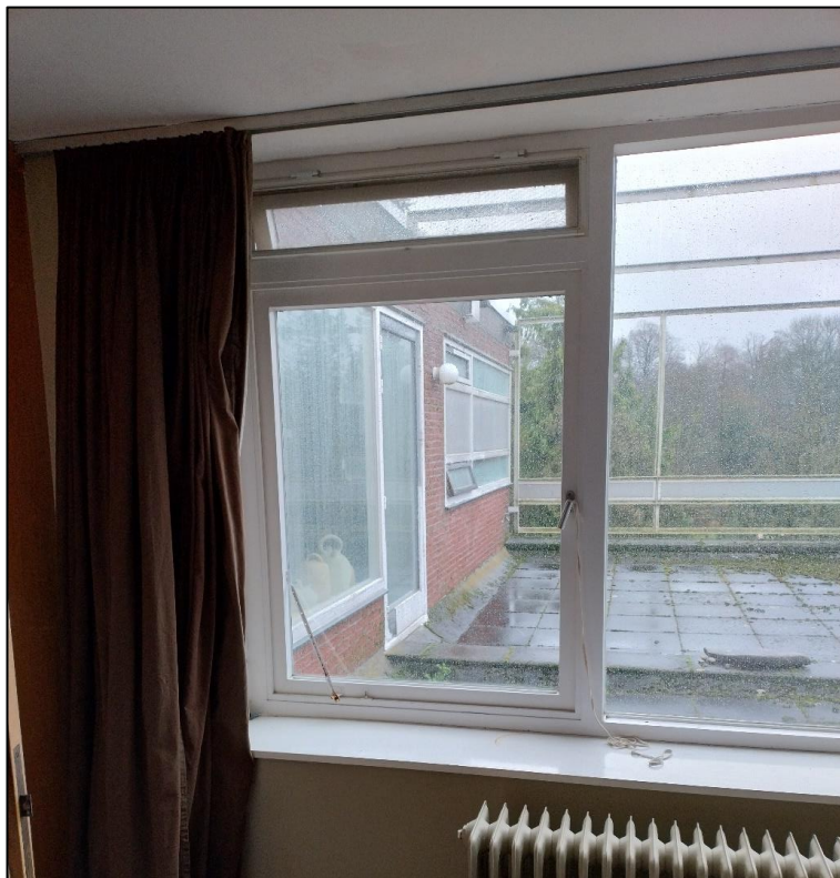
Figuur 67: Klapraam in de slaapkamer.
