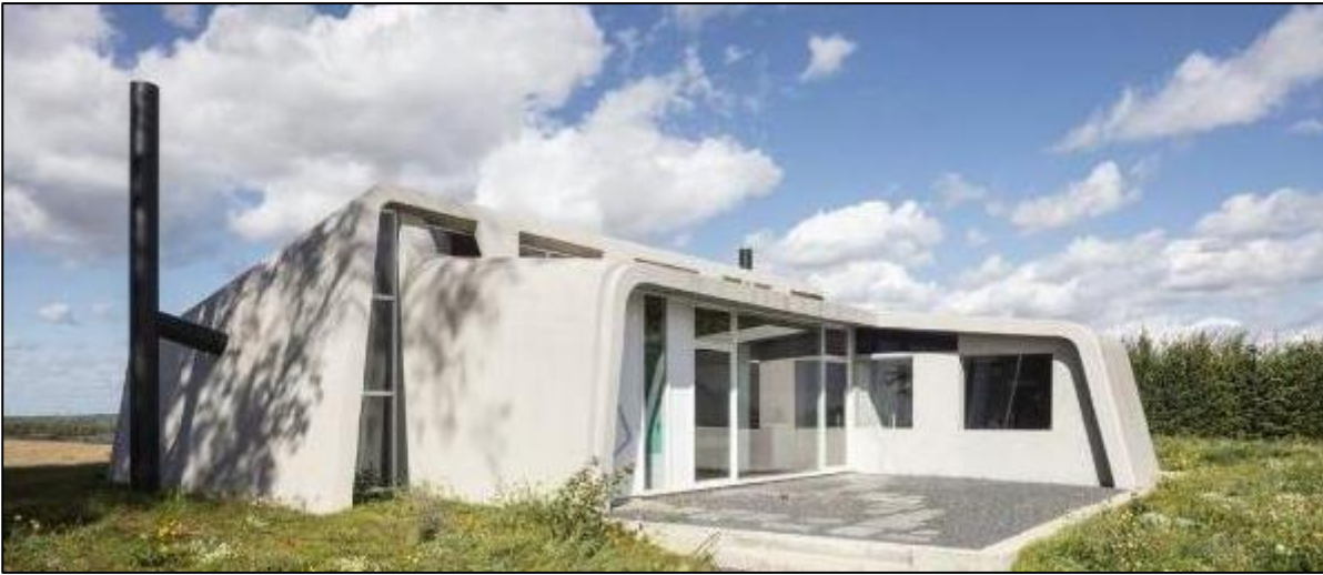
Figuur 158: Twee in elkaar grijpende betonschalen, met invulling in licht schrijnwerk. Links de schouw van de open haard, rechts de schouw van de oorspronkelijke installatie voor warmteopwekking.
