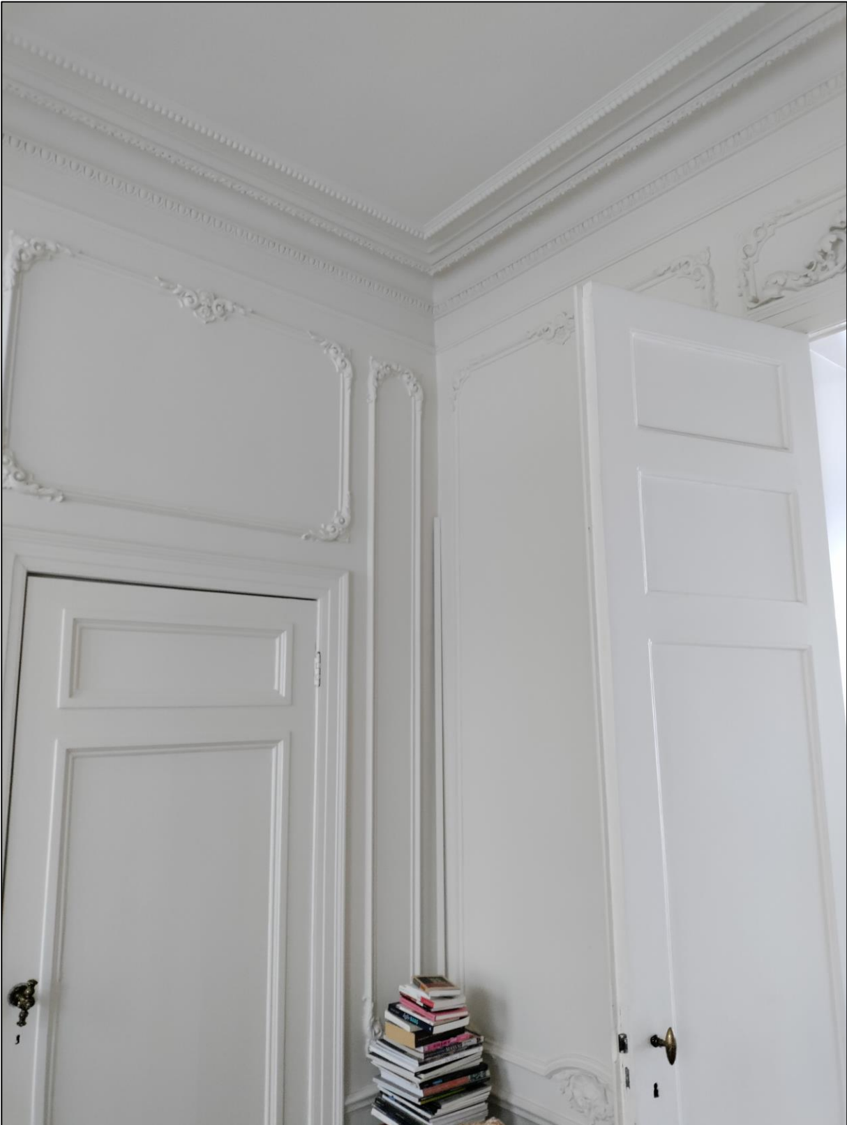
Figuur 33 Details van decoratief lijstwerk op deuren, wanden en plafonds in de salon aan de voorkant van het gelijkvloers. (Foto: Buildwise)
