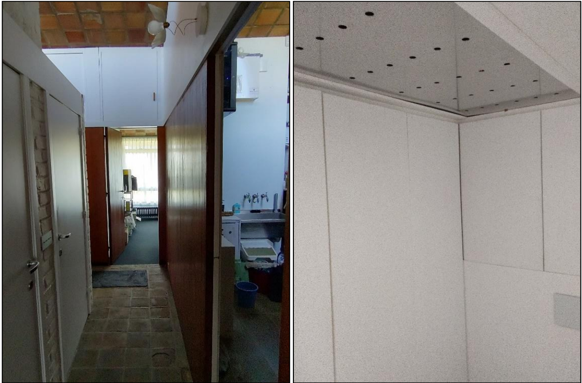
Figuur 162: Circulatieruimte met links het sanitair blok, en rechts de toegang naar de berging. In het sanitair blok is een verlaagd plafond (rechts) waarboven de ventilatie installatie is geplaatst.
