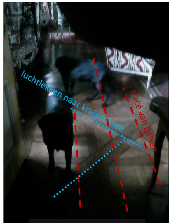
Figuur 88 Visualisatie van de plaatsen balken tot minder warmteverlies leiden en waar luchtlekken op de randen van de vierkante velden in het Versailles-parket tot hogere warmteverliezen leiden. (Foto: Buildwise)
