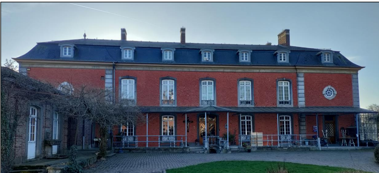
Figuur 72 Linker zijgevel (NO) met toegangsdeur die vandaag door de meeste bezoekers gebruikt wordt. (Foto: Buildwise)
