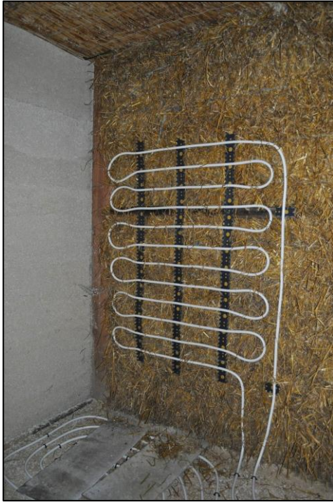
Figuur 8: Voorbeeld van wandverwarming aangebracht op biologische binnenisolatie (foto uit een andere eenheid dan het woonhuis, ter illustratie- Bron Foto: Overgenomen uit: Verdonck et al. 2017).
