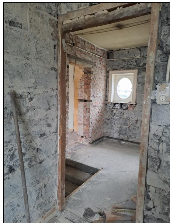
Figuur 107 Zicht vanuit de voorste slaapkamer naar de traphal, met het originele ellipsvormige raam. Het onderscheid tussen lichte wanden uit asbeton blokken en massieve baksteenwanden is duidelijk zichtbaar omdat de pleister afgekap is. (Foto: Buildwise)
