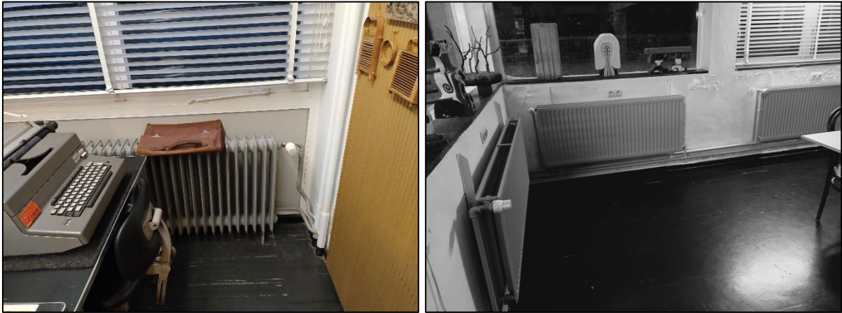
Figuur 58: Originele lamelradiatoren in het kantoor bij het atelier, nieuwe plaatradiatoren in het atelier (Foto: Daidalos Peutz bouwfysisch ingenieursbureau).
