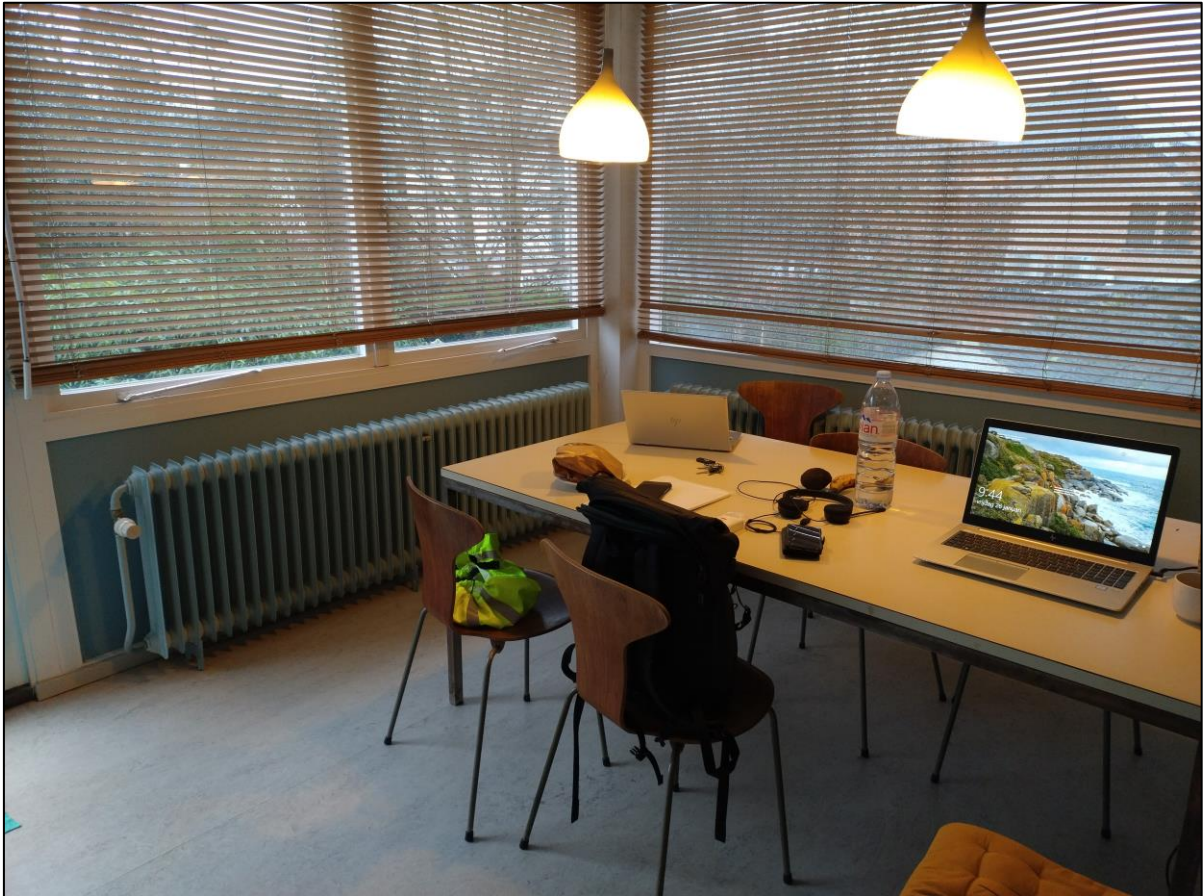
Figuur 45: Ledenradiatoren in de leefruimte, neergelaten binnenzonwering met lamellen (zuidelijk volume) (Foto: Daidalos Peutz bouwfysisch ingenieursbureau).
