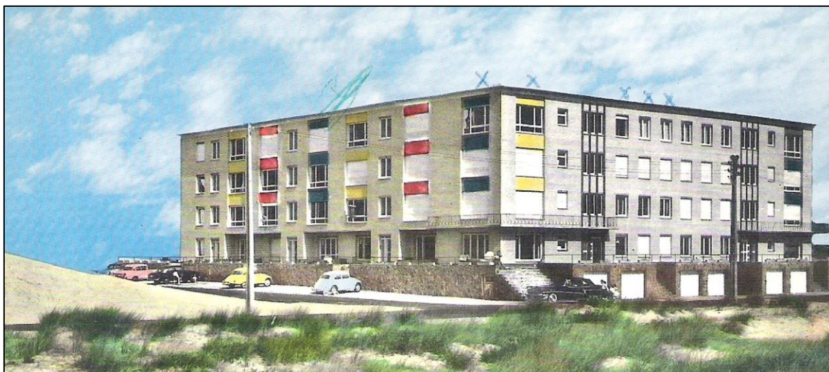
Figuur 128. Postkaart daterend van kort na de bouw, vermoedelijke jaren 1950. Hoek van de WWZ- en de ZZO-gevel. De gekleurde vlakken waren oorspronkelijk beschilderde pleister. Kort na de bouw werden ze echter bekleed met Glasal-panels omwille van vocht (- en mogelijk zout-) problemen.
