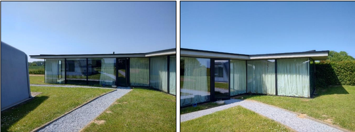
Figuur 160: Naastliggend paviljoen met de nieuwe warmteopwekkingsinstallatie (condenserende gasketel).
