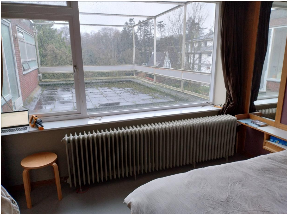
Figuur 51: Zicht vanuit de slaapkamer op het dakterras. We stellen voor om een horizontaal zonweringsdoek aan te brengen in de buitenliggende staalstructuur (Foto: Daidalos Peutz bouwfysisch ingenieursbureau).
