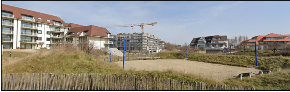
Figuur 133 Residentie Duinpark (achteraan) in renovatie tussen recentere appartementsgebouwen (Foto: Buildwise).
