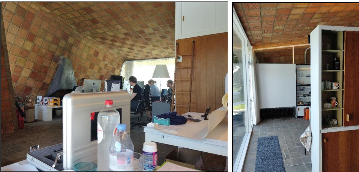
Figuur 159: Binnenafwerking van de betonnen schalen met een keramische tegel. Let op de open haard in het linkerbeeld, en de vloertegels in de leefruimte en inkom.
