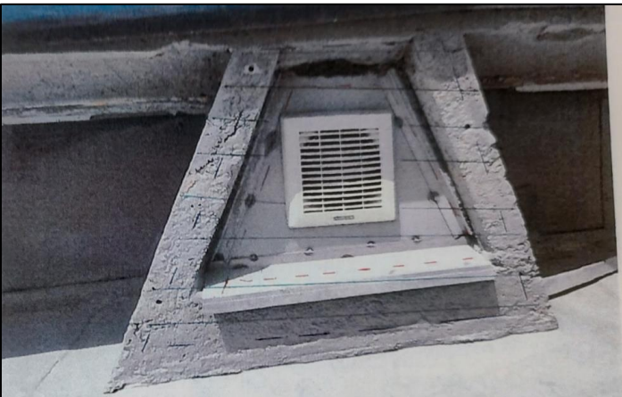
Figuur 161: Afblaas van het ventilatiesysteem dat in het sanitaire blok is geïntegreerd. De afblaas bevindt zich in de overlap tussen de twee betonschalen.
