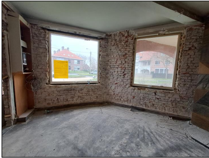
Figuur 104 Zicht vanuit de linker voorkamer (leefruimte in de bestaande toestand) op de voortuin en de loggia.
