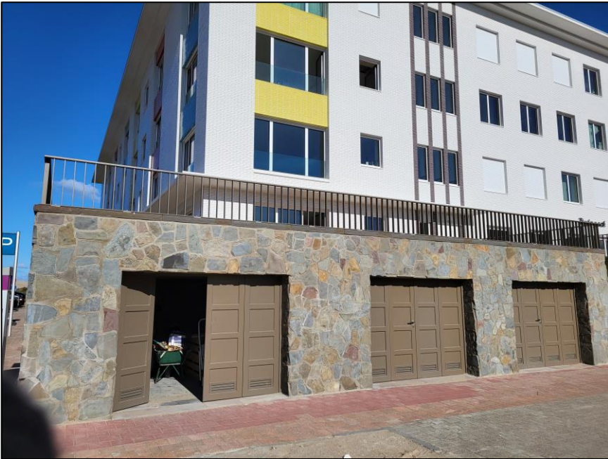
Figuur 137 een aantal garageboxen zijn gemeenschappelijk en kunnen ingenomen worden voor collectieve installaties (Foto: Buildwise).
