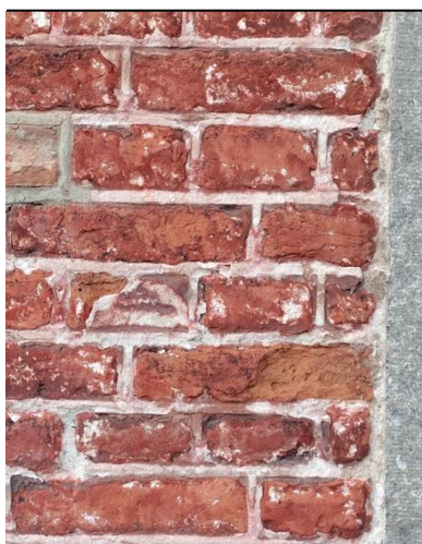
Figuur 77 Twee details van het buitenparement, met beschadigd voegwerk, vorstschade aan enkele bakstenen, gedeeltelijk bewaarde knipvoegen en sporen van zowel rode verf als een witte kalklaag. (Foto: Buildwise)
