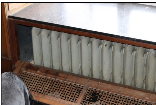
Figuur 84 Voorbeeld van een gietijzeren ledenradiator, weggewerkt achter geweven rotan canvas in een houten omkasting onder de raamtablet. (Foto: Buildwise)
