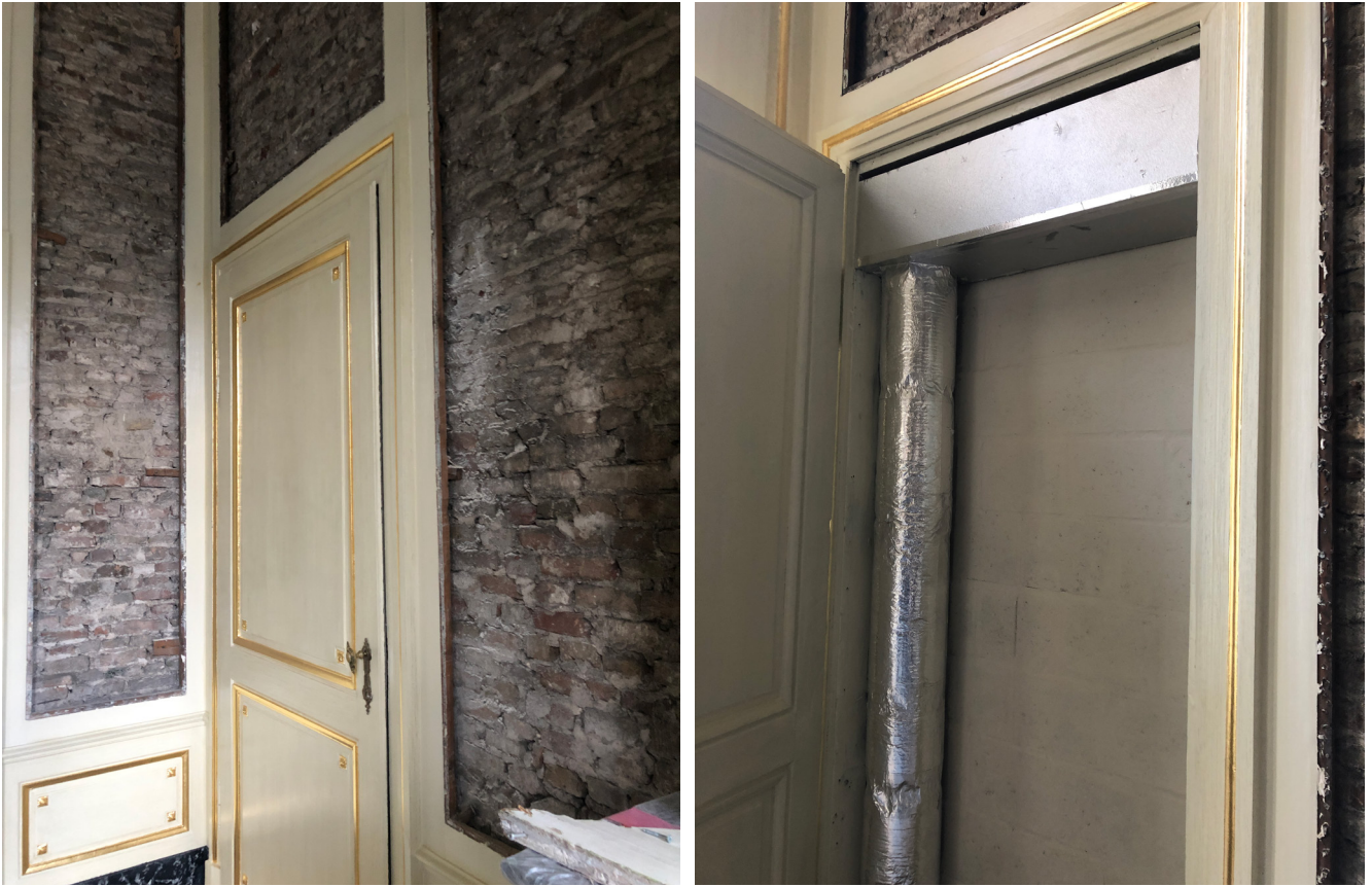
FIGUUR 111: Integratie van een luchtafvoeropening door aanpassing van de positie van het deurblad (Huis van Hamme, Brugge, foto Onroerend Erfgoed)
