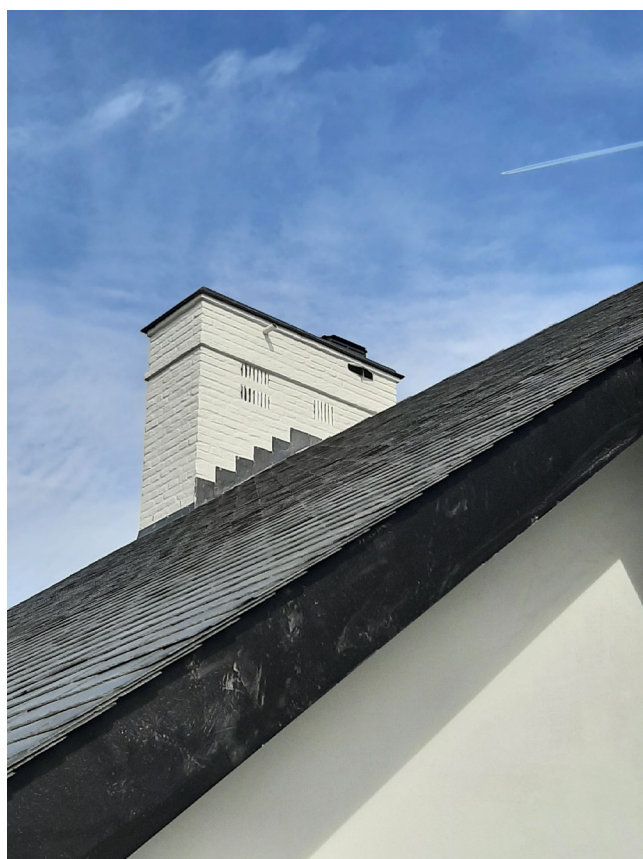
FIGUUR 128: Hergebruik van een bestaand schouwkanaal van een herenhuis te Aalst Foto Onroerend Erfgoed
