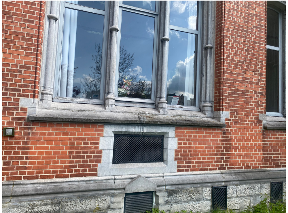
FIGUUR 19: historische roosters in de gevel bieden mogelijkheden als aan-of afvoerrooster voor lucht van een buitenunit-voorbeeld Rommelaere Instituut, Gent ©Onroerend erfgoed
