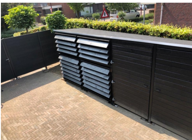
FIGUUR 14: voorbeeld van omkasting buitenunit in zijtuinstrook, verwerkt in vuilbakberging - © vito
