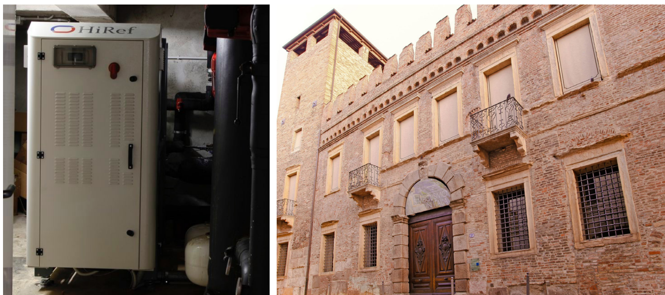
FIGUUR 35: binnenunit van water/water warmtepomp in Palazzo Zabarella, (Padova, Italië) - ©Galletti Group
