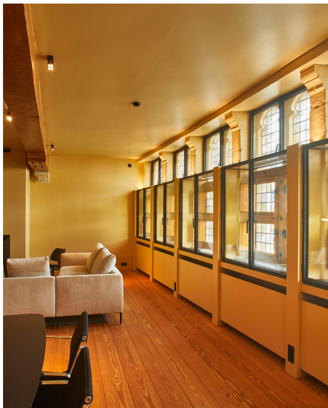
FIGUUR 107. Convectoren weggewerkt achter geschilderde panelen in het Huis de Vrije Schipper in Gent. Foto: Beeldbank Onroerend Erfgoed.
