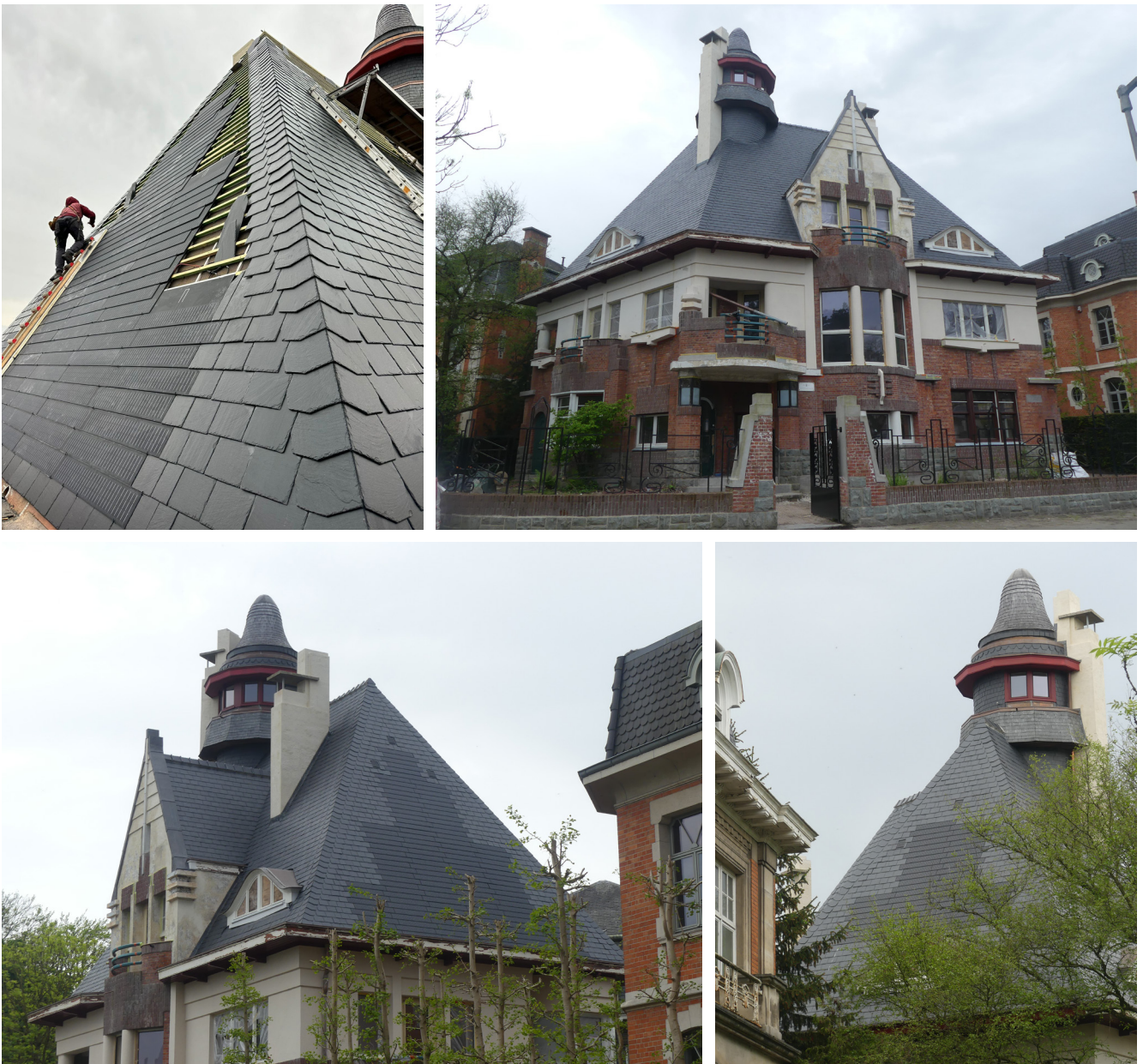
FIGUUR 46: Voorbeeld van zonneleien op de beschermde Villa Berteloot in het miljoenenkwartier in Gent. © Onroerend erfgoed
