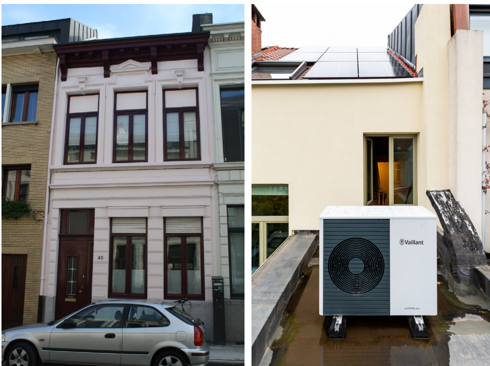
FIGUUR 23: links voorgevel woning, rechts monoblock op achterbouw in Zurenborg, niet zichtbaar vanop maaiveld achtertuin – ©Dieter Daniels, Rooilijn Architectuur
