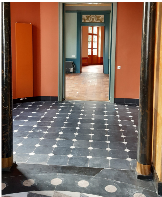
FIGUUR 109. Nieuwe vlakke radiator gelakt in dezelfde kleur als het schilderwerk van de muren in de villa Voortman in Gent. Foto: Agentschap Onroerend Erfgoed.
