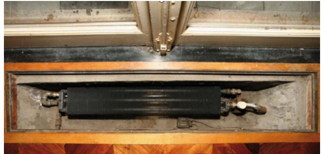
FIGUUR 77. Convector geplaatst in een convectorput voor een vensterraam. (foto: Beeldbank Onroerend Erfgoed)
