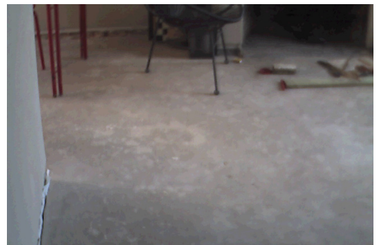
FIGUUR 82. Visueel beeld van de dekvloer met vloerverwarming uit Figuur 81. (Foto: Buildwise)
