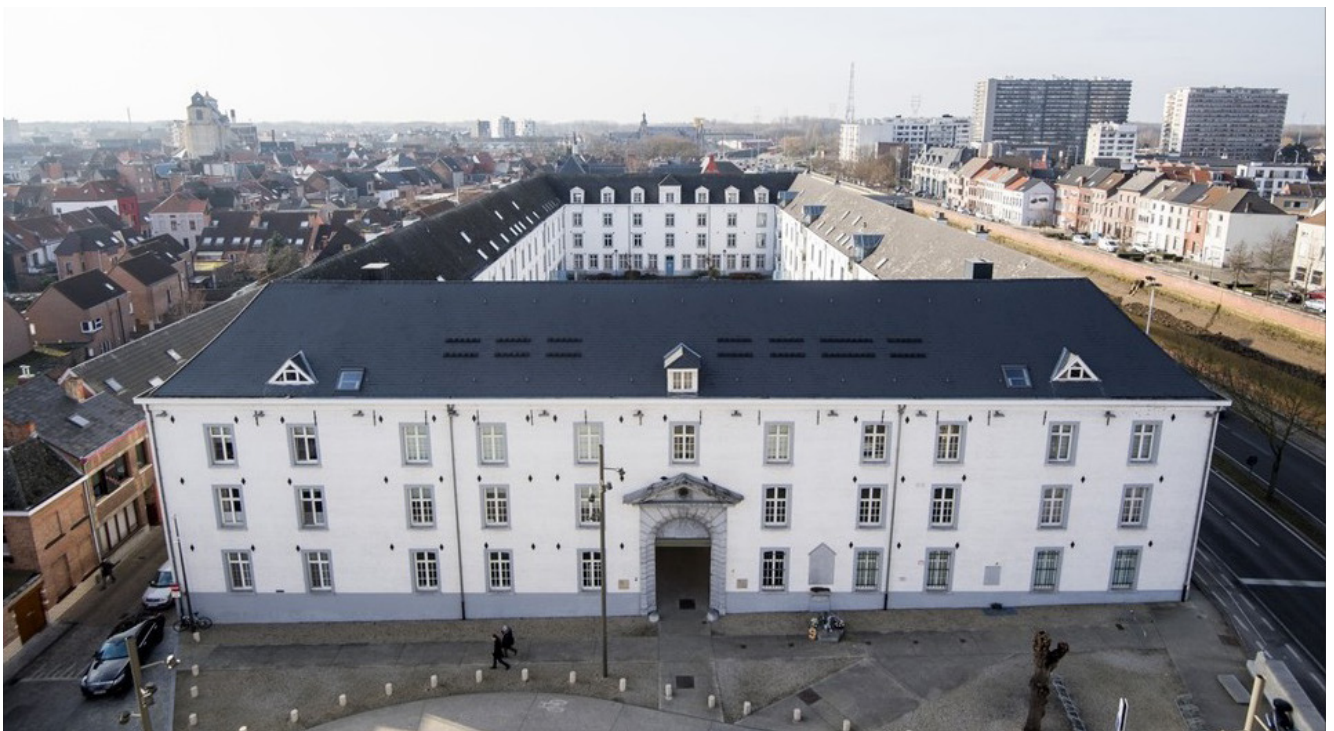
FIGUUR 125: buitenafwerking van een rooster voor natuurlijke toevoer van verse lucht in een hellend leiendak (kazerne Dossin, Mechelen) Foto Onroerend Erfgoed
