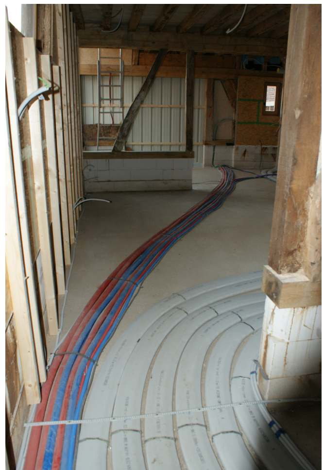
FIGUUR 120: vakwerkwoning in Alken (© Onroerend Erfgoed) met nieuw traject voor ventilatiekanalen (decentraal systeem) (© Lambrechts-Meisters)
