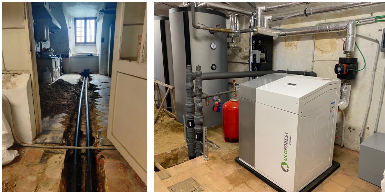
FIGUUR 32: binnenbrengen leidingen aquathermische installatie © Extraqt en Figuur 33: binnenunit aquathermische installatie kasteel de Merode in Westerlo © Nieuwsblad, 24 maart 2023
