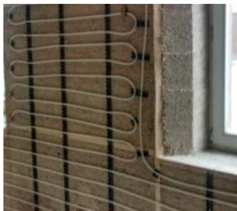
FIGUUR 84: Wandverwarming geplaatst tegen buitengevel geïsoleerd met kalkhennep in Hoeve de Hertogh, Boutersem (Laurenz Kuijpers, Energiezuinige maatregelen in monumenten met woonfunctie)
