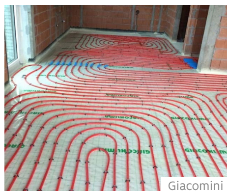
FIGUUR 137. Vloerverwarming op bedrukte PE-folie
