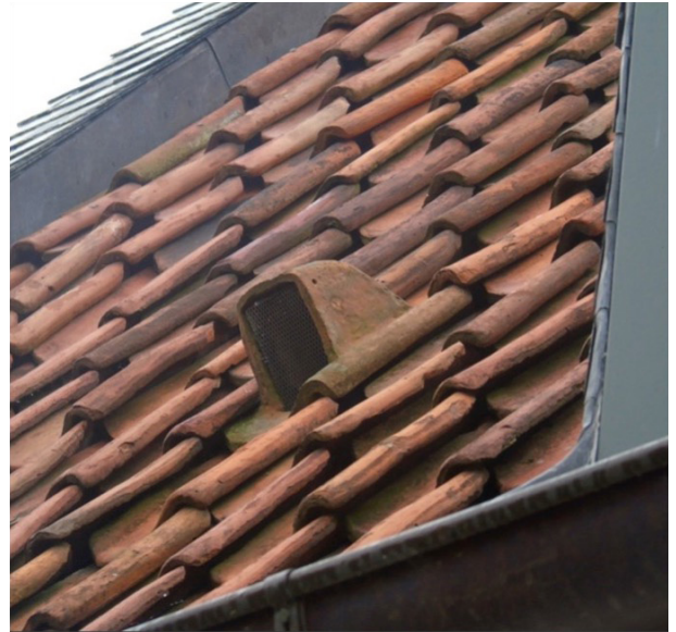
FIGUUR 115: gerecupereerde uilenpan in de buitenafwerking van een rooster voor afvoerlucht in een hellend pannendak (systeem D). (conciërgewoning kasteel van Vichte, Erfgoed en Visie)
