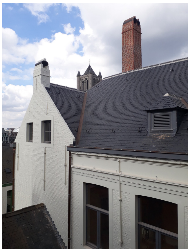
FIGUUR 127: Ventilatioerooster ingewerkt in de dakkapel van het stadhuis te Gent Foto Onroerend Erfgoed
