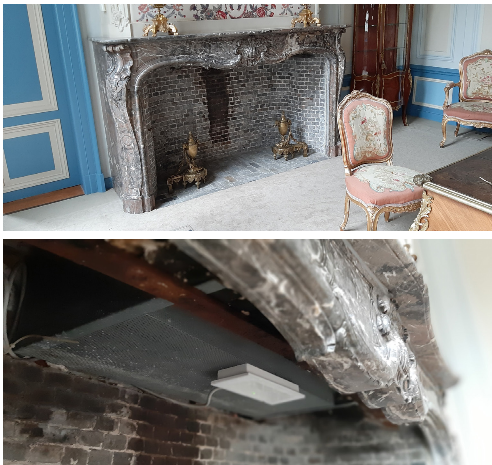
FIGUUR 118: Luchtafvoer integratie in bestaande schouw, Huis de Caese, Brugge (Agentschap Onroerend Erfgoed)
