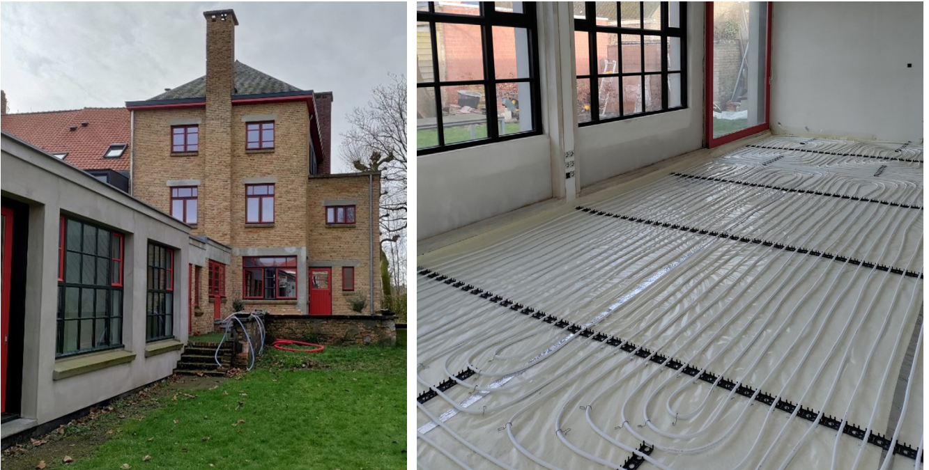
FIGUUR 80. Vloerverwarmingsbuizen die ingewerkt worden in de chape (dekvloer) in het ateliergedeelte van de modernistische Woning Billiet in Brugge. De buizen zijn aangebracht op harde isolatieplaten, afgedekt met folie. © Buildwise
