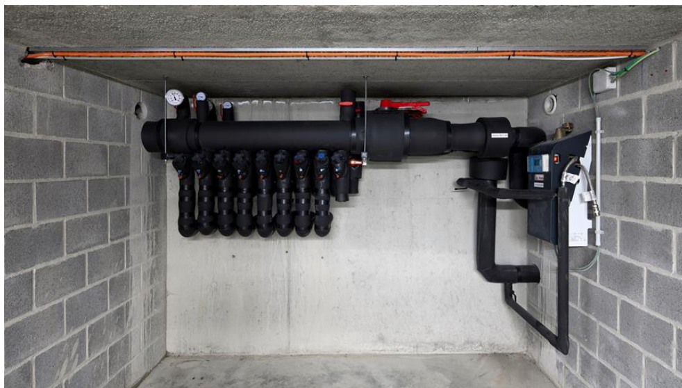
FIGUUR 41: Voorbeeld van een binnenunit/ doorsteek van de bodemlussen van een water/water warmtepomp - © VITO
