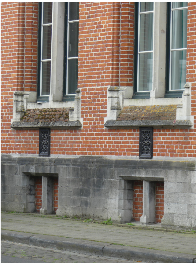
FIGUUR 112: Historisch aanwezige luchttoevoerroosters in de gevel. Bron: Onroerend Erfgoed
