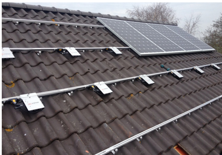
FIGUUR 48: voorbeeld van een Micro omvormer (witte plaatjes) voor plaatsing panelen © sunshine renewable Solutions
