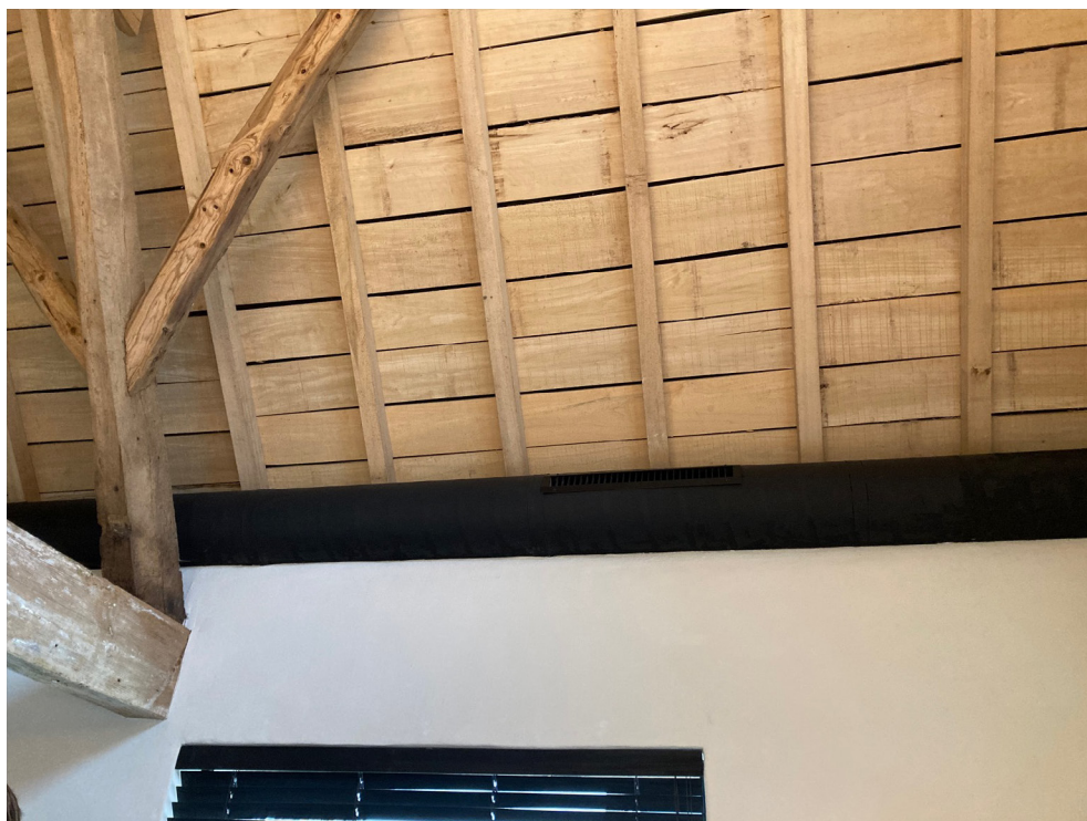
FIGUUR 122: Hergebruik van bestaande verticale kanalen (Huis Lousbergs- De Hemptinne, Gent)
