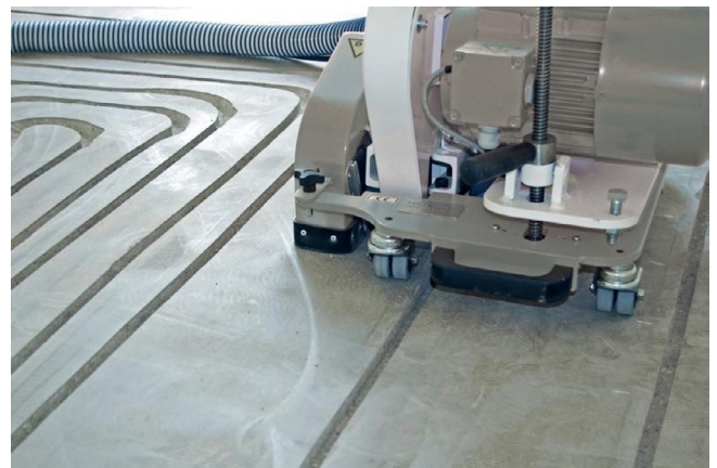
FIGUUR 139. Gefreesde sleuven in de dekvloer (Vasco)
