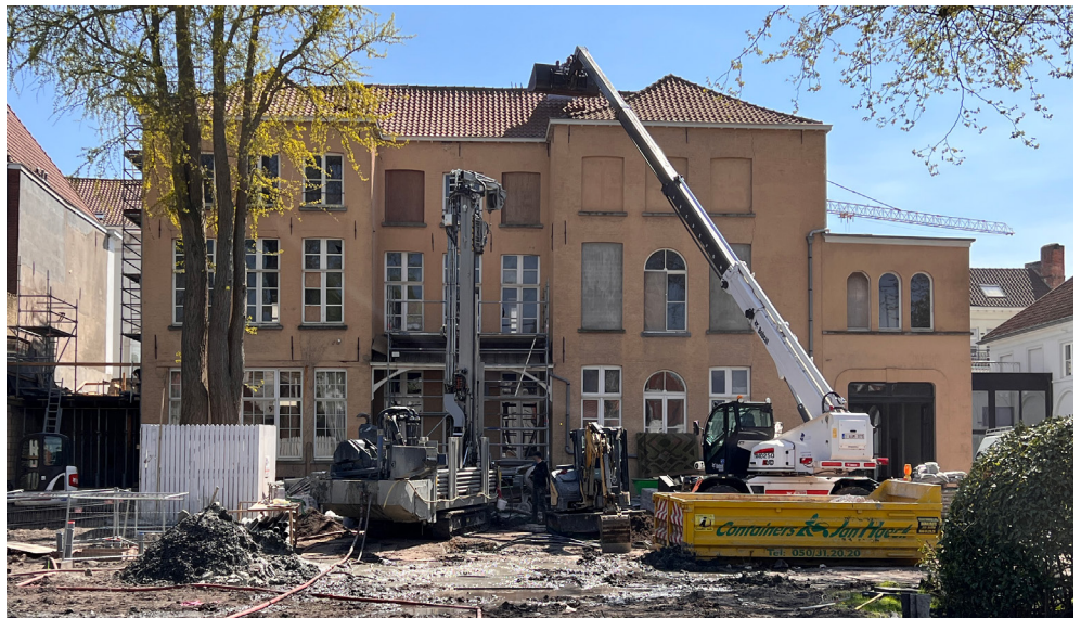
FIGUUR 37: Voorbeeld van een booropstelling voor de aanleg van een bodem warmtepomp 48
