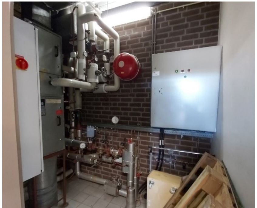
FIGUUR 8: Voorbeeld van een warmtenetaansluiting of afleverzet (voor 500m 2 gebruiksoppervlakte) 31
