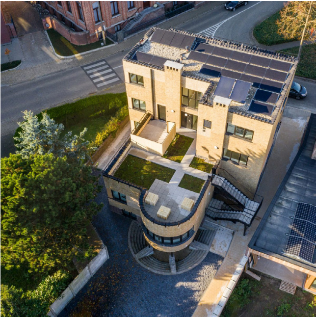
FIGUUR 52 en Figuur 53: Panelen met een stellage voor verbeterde natuurlijke ventilatie op de voormalige modernistische dokterswoning 'Huis van Bockstal' in Vorselaar Figuur 54: Voorgevel 'Huis van Bockstal' © LivinArchitecten
