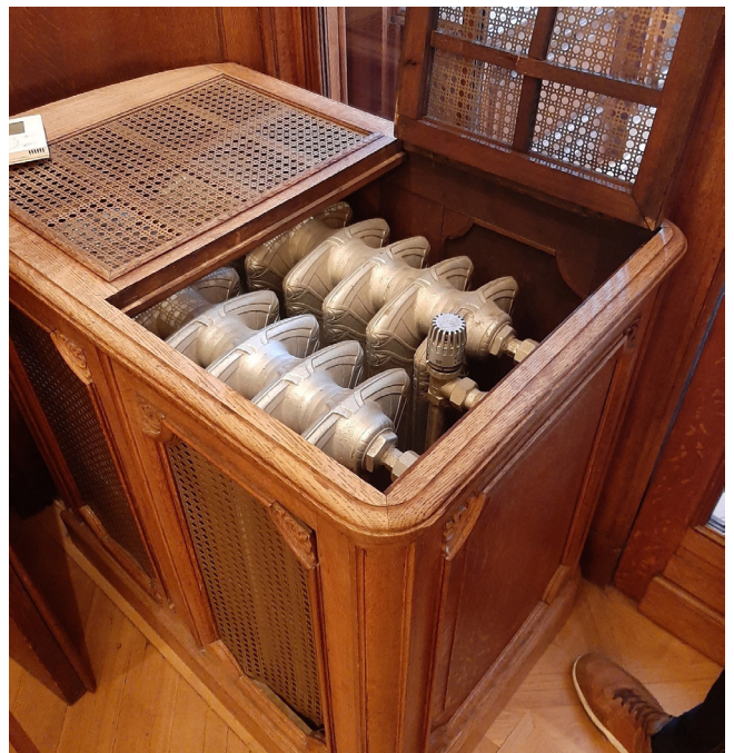
FIGUUR 78. Twee gietijzeren ledenradiatoren geplaatst in een speciaal daarvoor gecreëerde kast uit hout en rieten schermen in het huis Lousbergs - de Hemptinne in Gent. De kast is qua kleur en vormgeving geïntegreerd in het interieur dat ouder is. (foto: Agentschap Onroerend Erfgoed)
