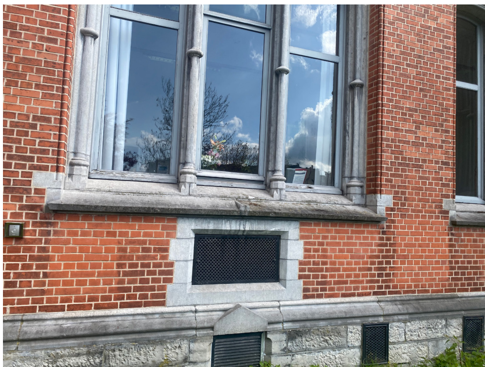
FIGUUR 126: Opportuniteit voor de integratie van een rooster in een gevelrooster van het Rommelaere Instituut in Gent. Foto Onroerend Erfgoed
