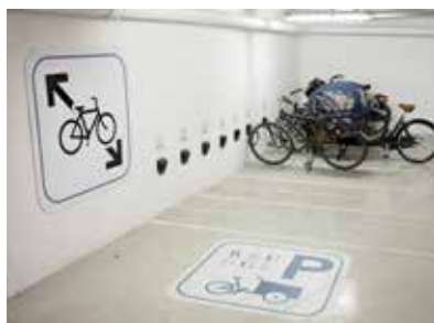
Inpandige buurtfietsenstalling Brugge
