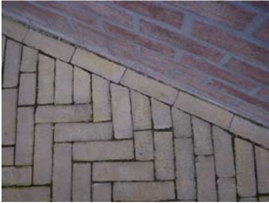
Fig. 3.1b Vulstukken moeten worden gezaagd en mogen nooit kleiner zijn dan een halve steen.
