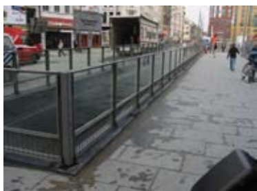
Fig. 2.1.3g Een hekwerk kan net als een muurtje perfect dienst doen als natuurlijke gidslijn, mits het hek vanaf de grond is opgetrokken of de open ruimte er onder maximaal 10cm is.
