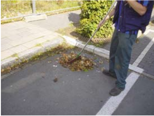
Fig. 3.1d In scherpe hoeken blijft allerlei vuil liggen, terwijl borstelmachines niet tot in de hoek kunnen komen. Dit vuil kan een voedingsbodem vormen voor onkruid.
