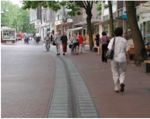
Fig. 2.1.5c Winkelstraat met goot in het midden die dienst kan doen als natuurlijke gidslijn voor blinde en slechtziende personen. De goot heeft kleine openingen, waardoor deze geen obstakel vormt en gebruikers van de witte stok er niet in zullen blijven steken. Het contrast met de omliggende bestrating is verhoogd door de stroken blauwe steen aan weerszijden van de goot.
