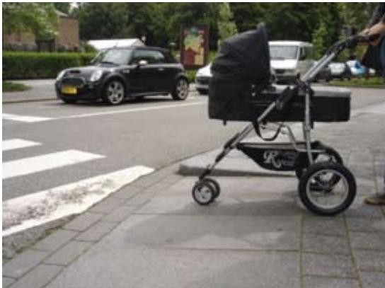
Fig. 2.1.4m Deze geprefabriceerde stoeprandverlaging is ontworpen voor rolstoelgebruikers en kinderwagens. De helling is langer en daardoor minder steil.
