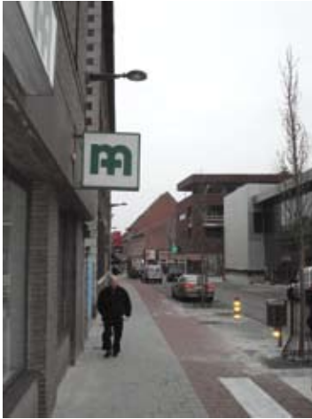
Fig 2.1.1h Om een ruimere obstakelvrije doorgang te verkrijgen heeft men hier de algemene straatverlichting aan de gevels bevestigd.
