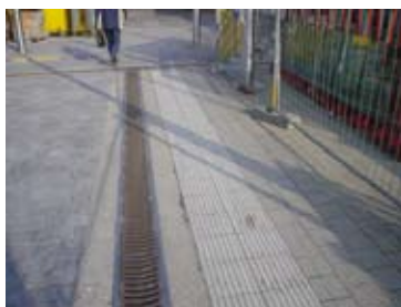
Fig. 2.1.3h De goot zou perfect kunnen dienen als natuurlijke gidslijn, ware het niet dat de openingen te breed zijn en dwars op de looprichting staan waardoor de witte stok er gemakkelijk in kan blijven steken. Was er een geschikter rooster gekozen dan had de speciale voorziening t.b.v. blinden en slechthzienden ernaast achterwege gelaten kunnen worden.
