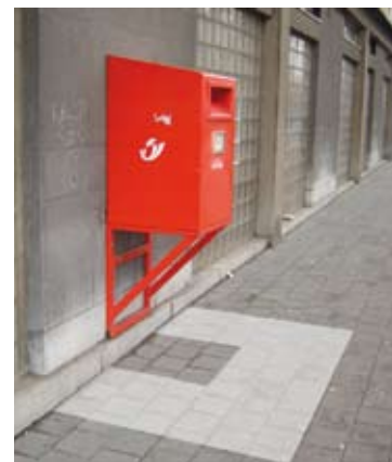
Fig. 2.1.1q Een obstakel dat op grondniveau niet tastbaar is kan eventueel ook door een afwijkende bestrating worden gemarkeerd in een strook van 60cm rondom het obstakel.
