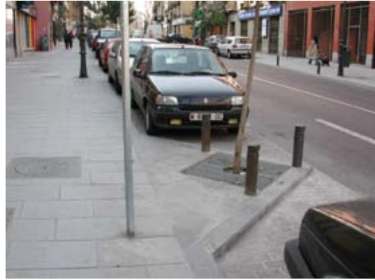
Fig. 3.1e In een stompe hoek blijft vuil minder snel liggen en bovendien ontstaan op deze manier geen plaatsen die onbereikbaar zijn met een borstelmachine.
