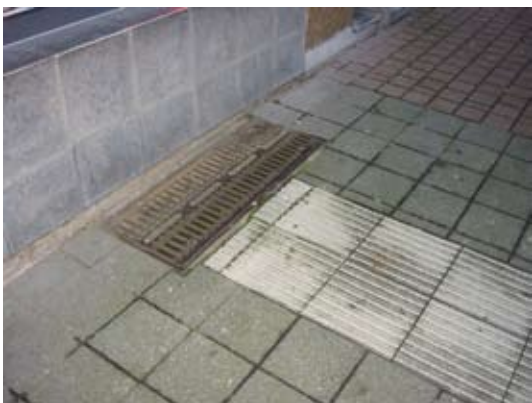
Fig. 2.2.3o Het gebruik van tegels < halve tegel wordt liefst vermeden
