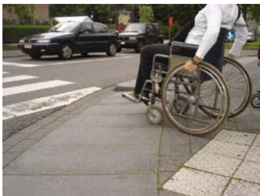
Fig. 2.2.1a Een geprefabriceerde stoeprandverlaging afgestemd op het gebruik door rolstoelgebruikers. De verlaging op de foto is 1m diep, waardoor het hellingspercentage onder de maximum toegestane norm blijft.
