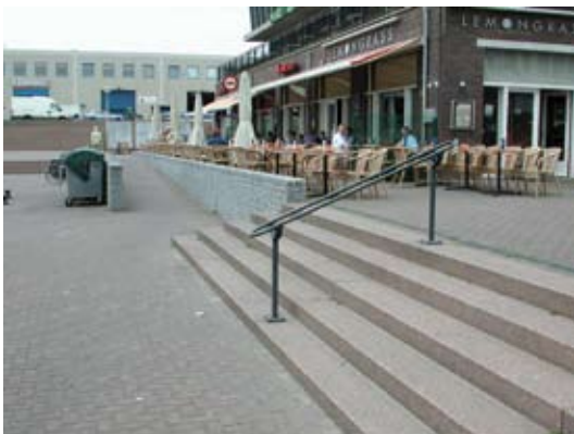
Fig. 2.1.4a4 Hier is een leuning in het midden van de brede trap geplaatst. Dit is een minder goede oplossing. Blinden en slechtzienden komen via de natuurlijke gidslijn altijd aan de zijkant van de trap uit en daar is geen leuning. Merk op dat ook waarschuwingsmarkeringen en contrastmarkeringen ontbreken.
