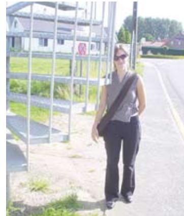
Fig. 2.1.1n Aan deze trap kan een blinde of slechtziende zich behoorlijk kwetsen, doordat het obstakel op grondniveau niet tastbaar is.
