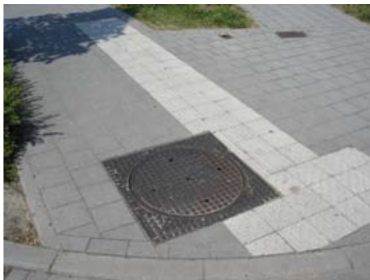
Fig. 2.2.3n Een putdeksel in een geleidelijn werkt zeer verwarrend
