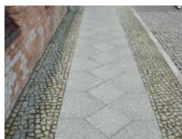
Fig. 2.1.3l De looproute en obstakelzone zijn in verschillende materialen uitgevoerd. Dit verschil in textuur kan ook goed dienen als natuurlijke geleiding.
