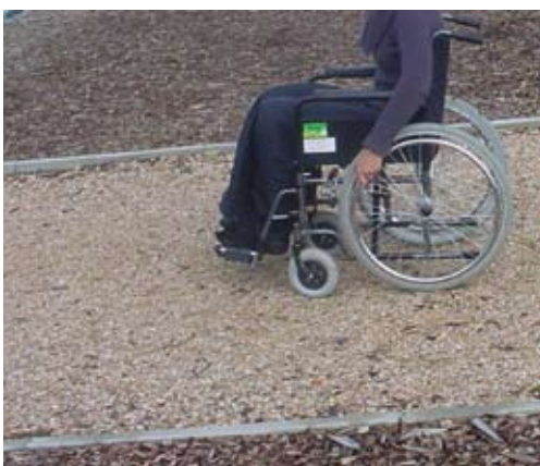
Fig.2.1.5.d Een wandelpad met een semi-verharding
